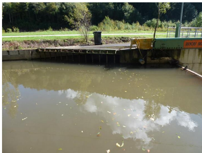
Abbildung 2.9: Einlauf des Triebwassers mit Grobrechen
