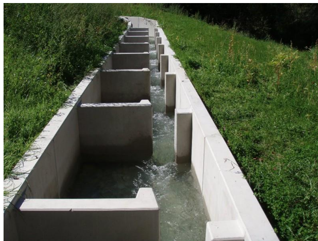
Abbildung 3.2: Fischeufstiegshilfe Vertical-Slot-Fischpass (Schlitzpass) ( http://www.drauradweg.com/de.aspx/sehenswertes/View/784 )
