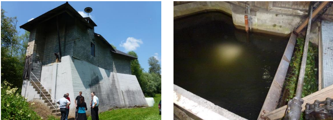
Abbildung 2.29: Rechenanlage KW III; Außen- und Innenansicht
