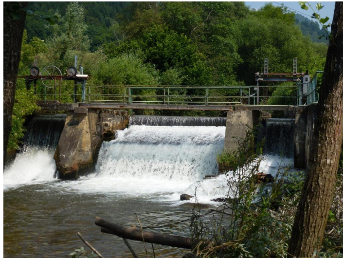
Abbildung 4.29: KW Pemberger unterwasserseitig
