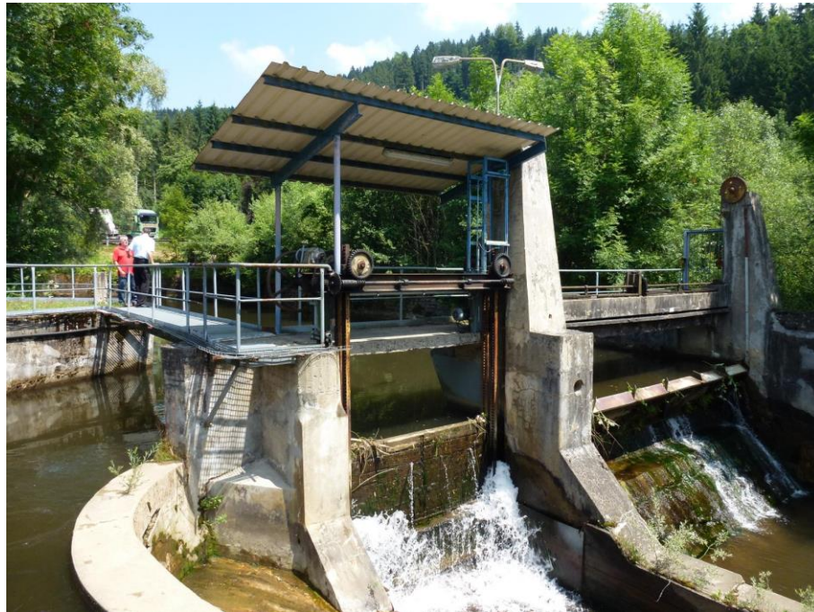
Abbildung 4.25: Wehranlage KW III unterwasserseitig
