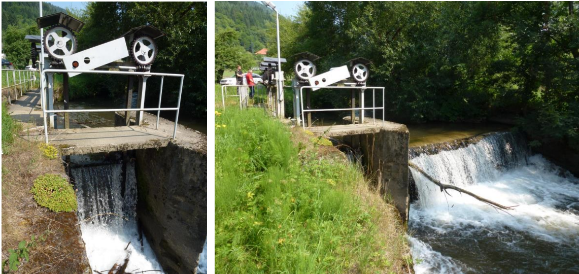
Abbildung 2.38: Wehranlage KW Kettenwerk unterwasserseitig; rechts: Festes Wehr, links: Grundablass
