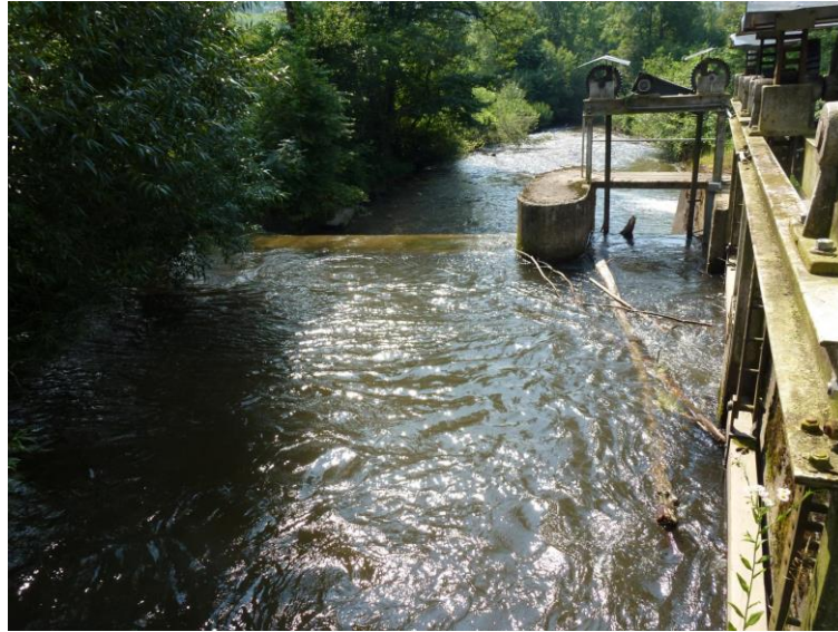
Abbildung 2.39: Wehranlage KW Kettenwerk oberwasserseitig
