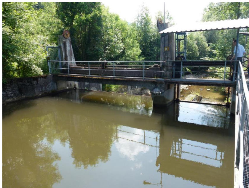
Abbildung 2.28: Wehranlage KW III oberwasserseitig
