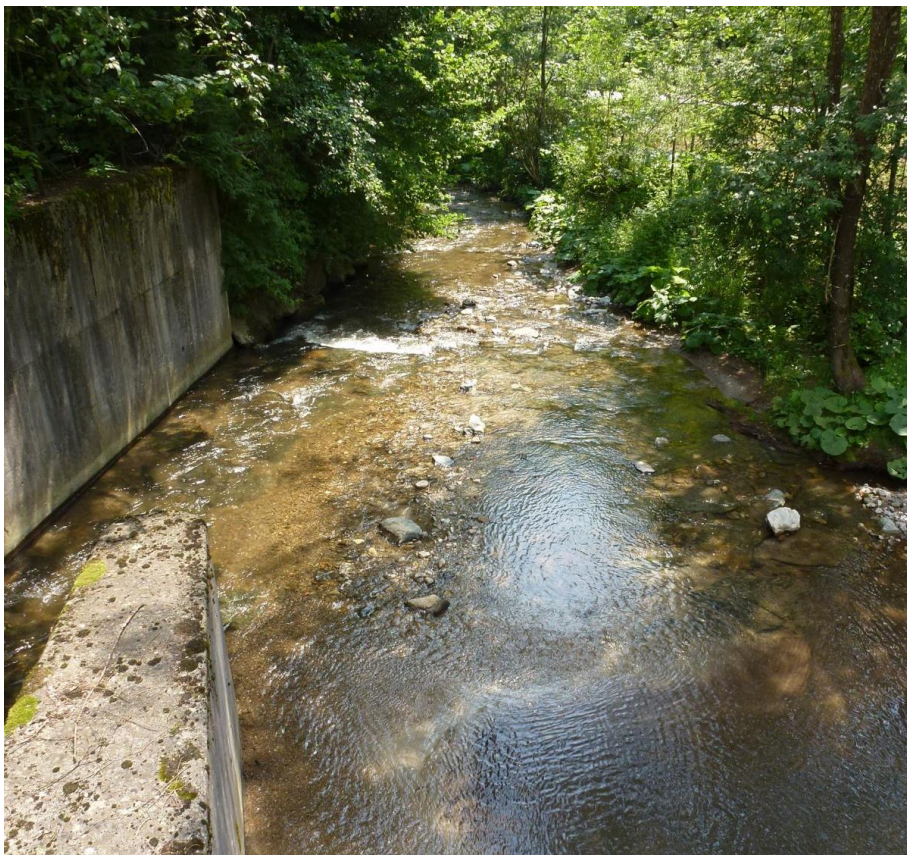
Abbildung 2.17: Restwasserstrecke KW IV
