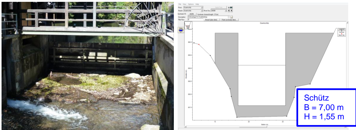
Abbildung 4.17: Links: Wehranlage KW Hüttenberg unterwasserseitig, rechts: als HEC-RAS Modellierung
