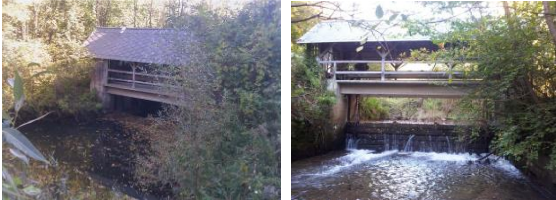
Abbildung 2.24: Wehranlage KW II ober- und unterwasserseitig (Fotodokumentation GEOS Consulting ZT-GmbH, 2012)
