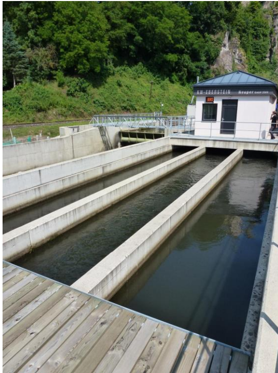
Abbildung 2.33: 3-Kammern Sandfang KW Eberstein I
