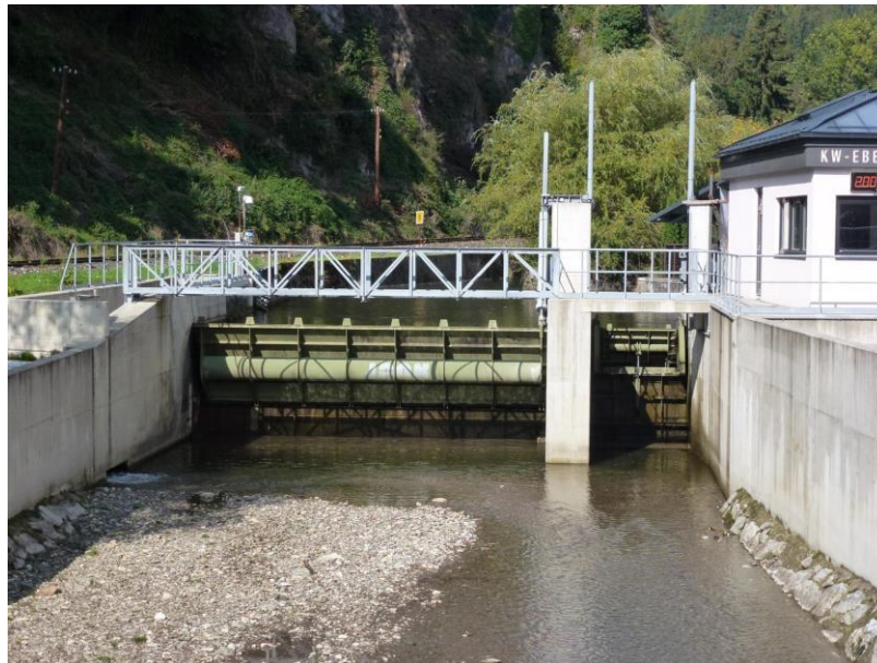
Abbildung 4.27: Wehranlage KW Eberstein I unterwasserseitig
