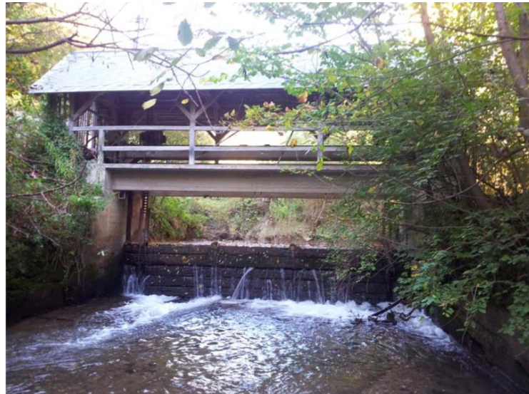
Abbildung 4.23: Wehranlage KW II (Görtschitztor) unterwasserseitig (Fotodokumentation GEOS Consulting ZT-GmbH, 2012)
