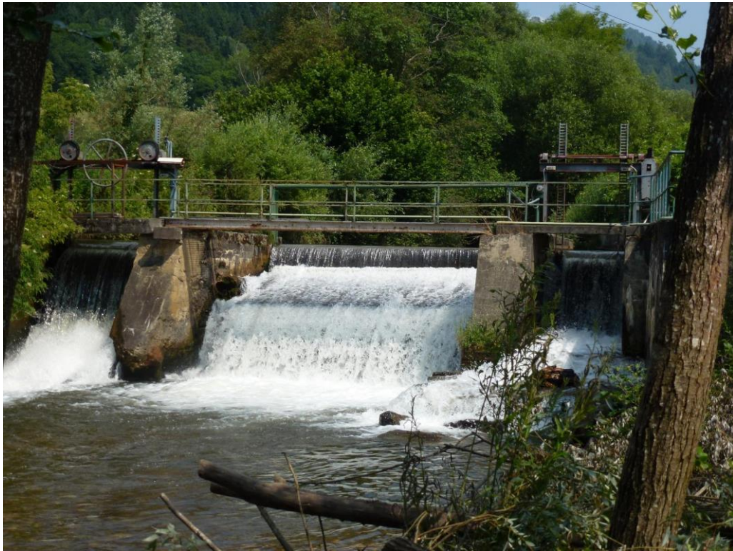
Abbildung 2.35: Wehranlage KW Pumberger (unterwasserseitig)
