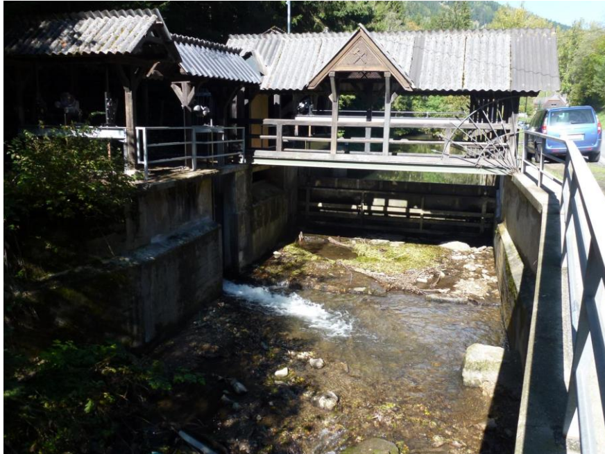
Abbildung 2.6: Wehranlage KW Hüttenberg (unterwasserseitig)
