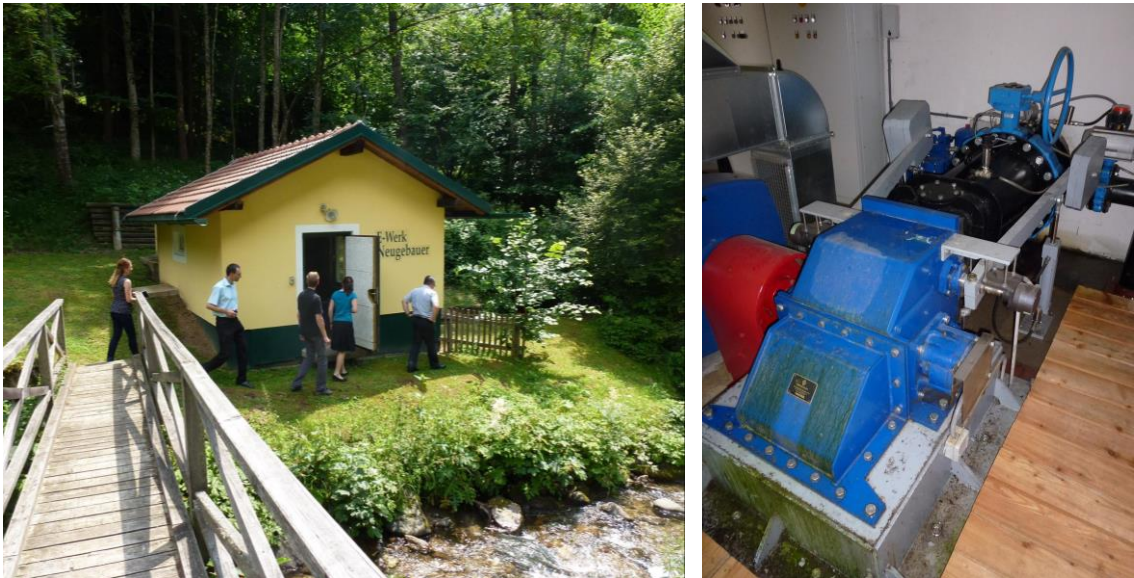
Abbildung 2.12: E-Werk Neugebauer und Maschinenraum
