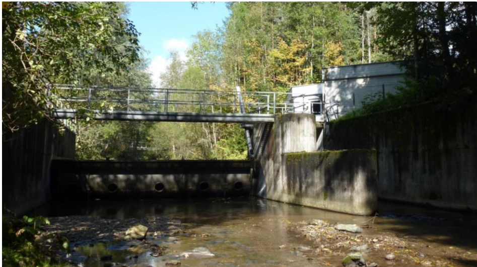
Abbildung 4.19: Wehranlage KW IV unterwasserseitig
