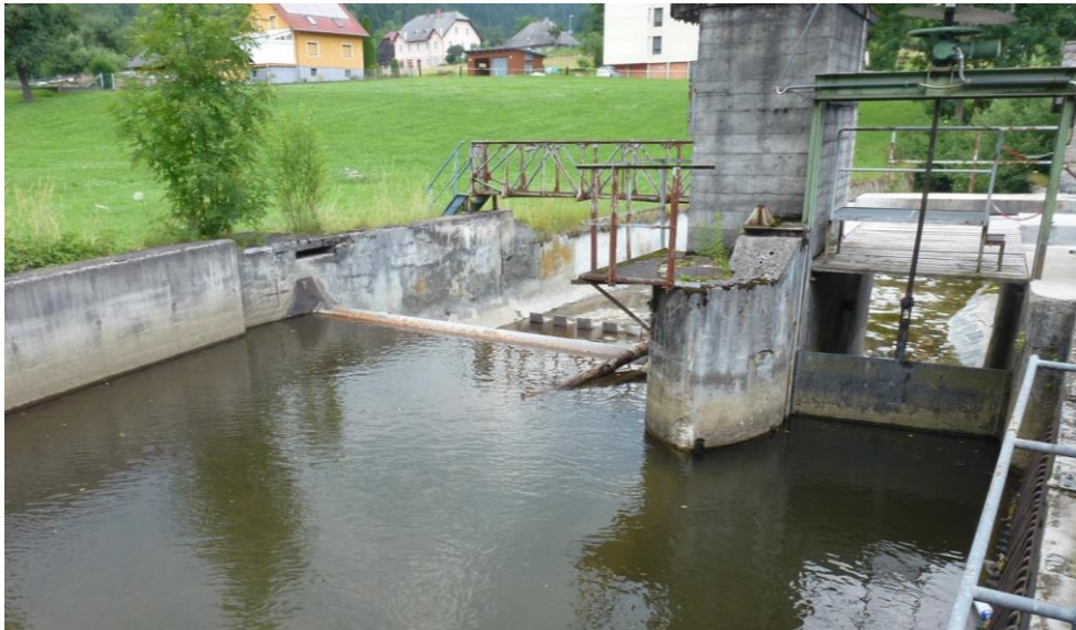
Abbildung 4.21: Wehranlage KW I oberwasserseitig
