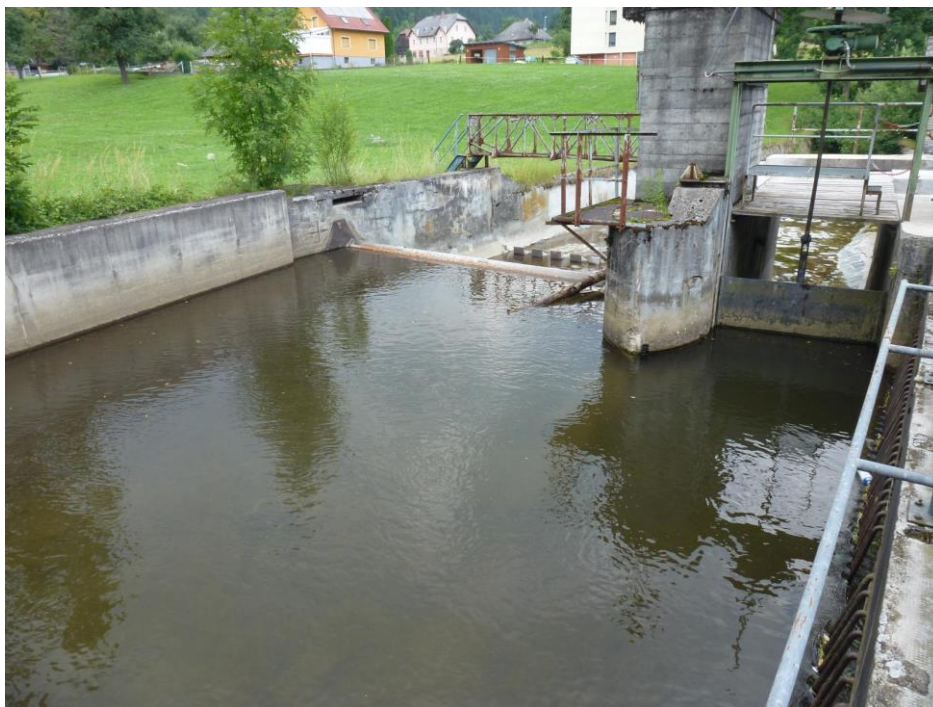
Abbildung 2.20: Wehranlage KW I (oberwasserseitig)
