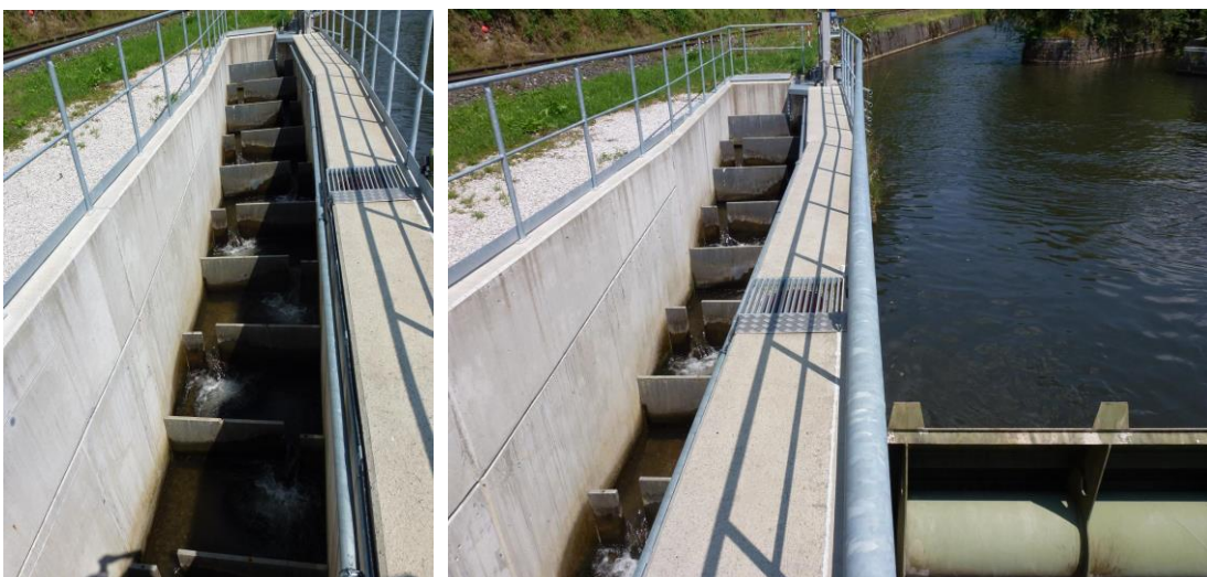
Abbildung 2.34: Fischaufstiegshilfe KW Eberstein I
