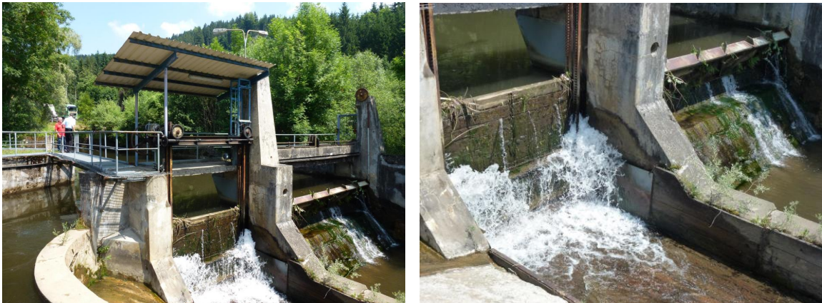
Abbildung 2.27: Wehranlage KW III unterwasserseitig, rechts: Detail Spülschütz und Wehrklappe
