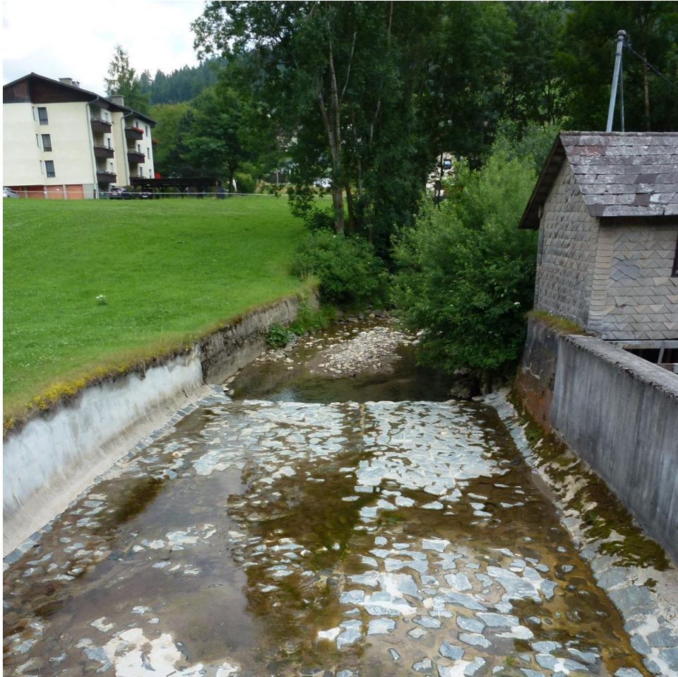
Abbildung 2.23: Restwasserstrecke nach der Wehranlage KW I
