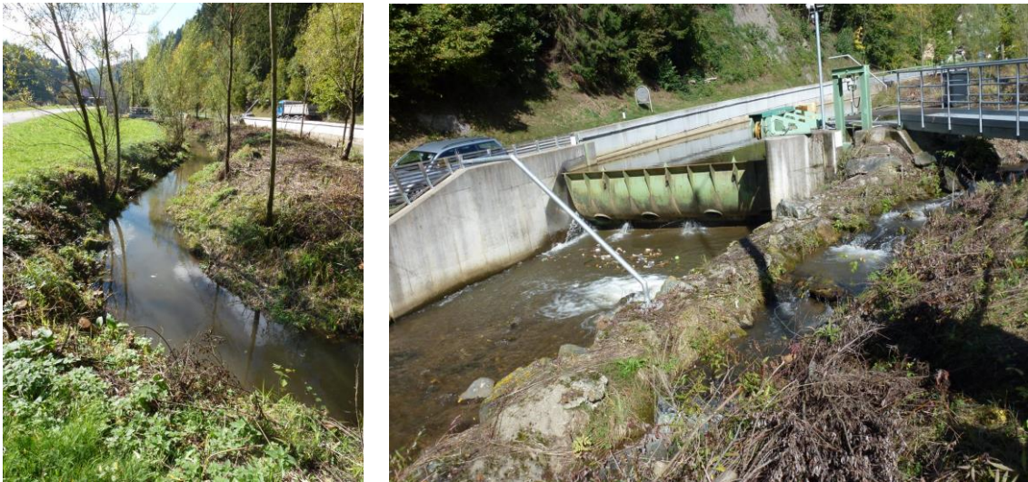
Abbildung 2.10: Fischaufstiegshilfe KW Moser
