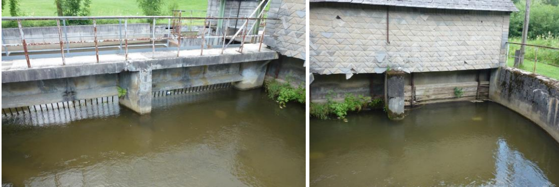
Abbildung 2.21: Einlaufbauwerk mit Grobrechen und Holzschützen
