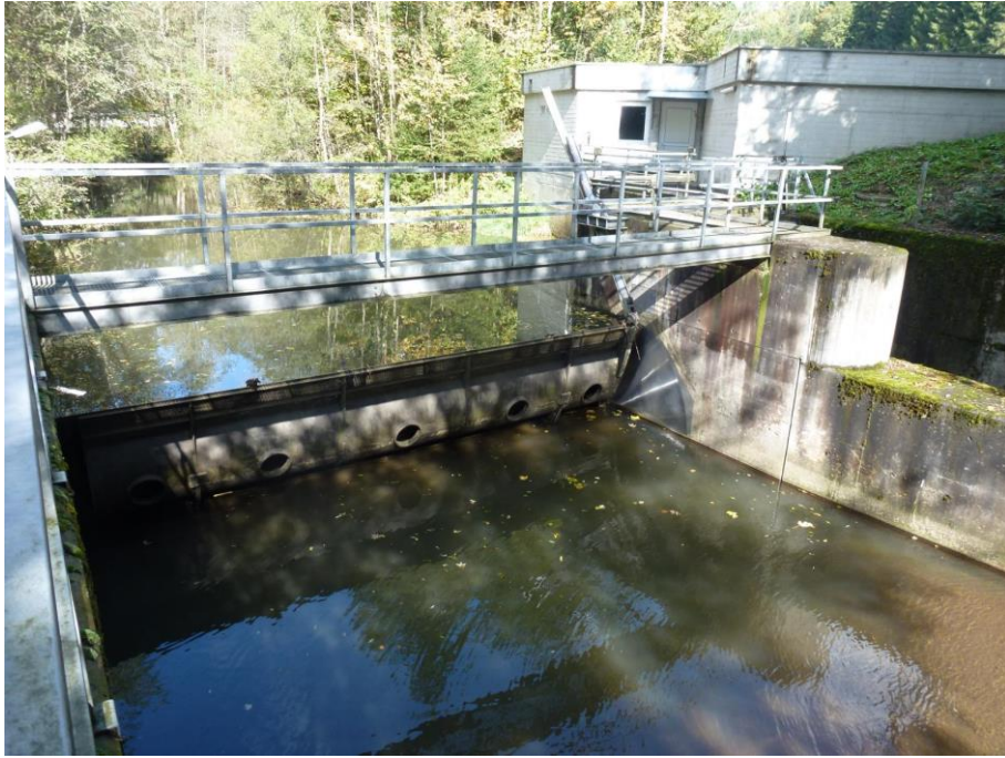
Abbildung 2.16: Wehranlage KW IV (unterwasserseitig)
