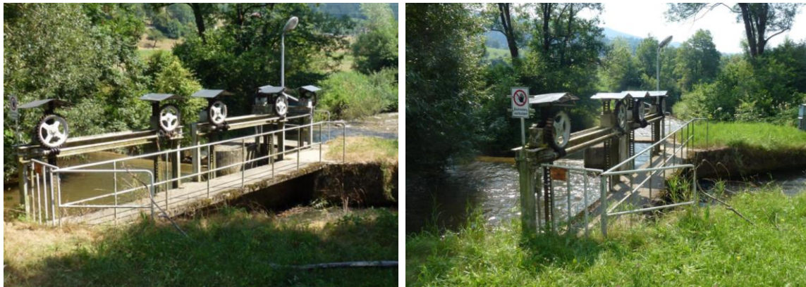
Abbildung 2.40: Einlauf KW Kettenwerk
