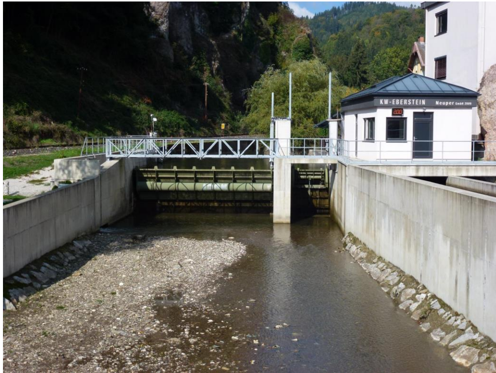
Abbildung 2.32: Wehranlage Kraftwerk Eberstein I (unterwasserseitig)
