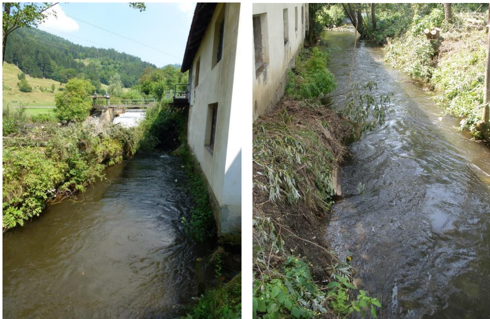
Abbildung 2.37: Unterwasserkanal
