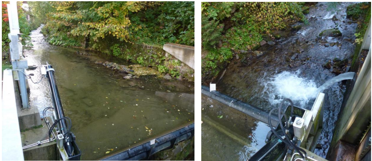
Abbildung 2.14: Links: Stauraum, Rechts: Pflichtwasserabgabe KW Neugebauer
