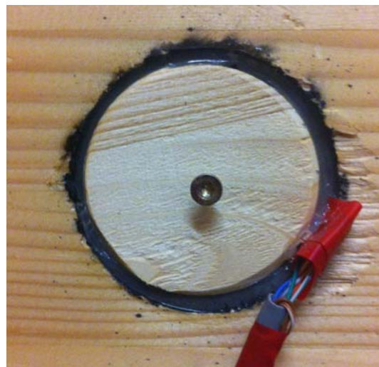
Abb. 1.18 verschlossener Bereich zur Messung der Schraubenkräfte im Prüfkörper
