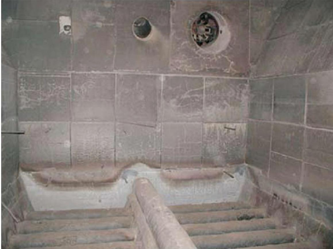
**Abbildung 3: Düsenboden einer stationären Wirbelschicht** Strabag Energietechnik GmbH & Co KG [1]
