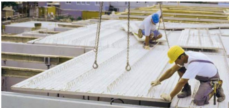
Abbildung 9-5 | Montageunterstellung bei Elementdecken 129
