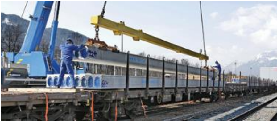
Abbildung 8-20 | Verladen der Betonfertigteile 122
