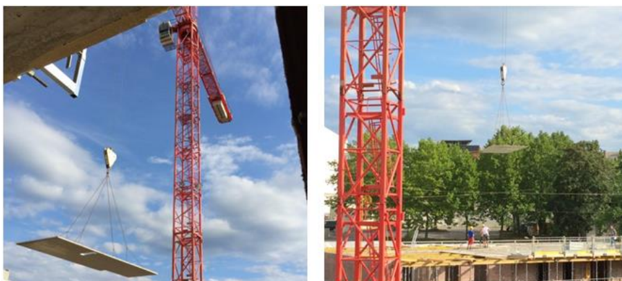
Abbildung 9-11 | Beispielbild – Versetzen von Elementdecken
