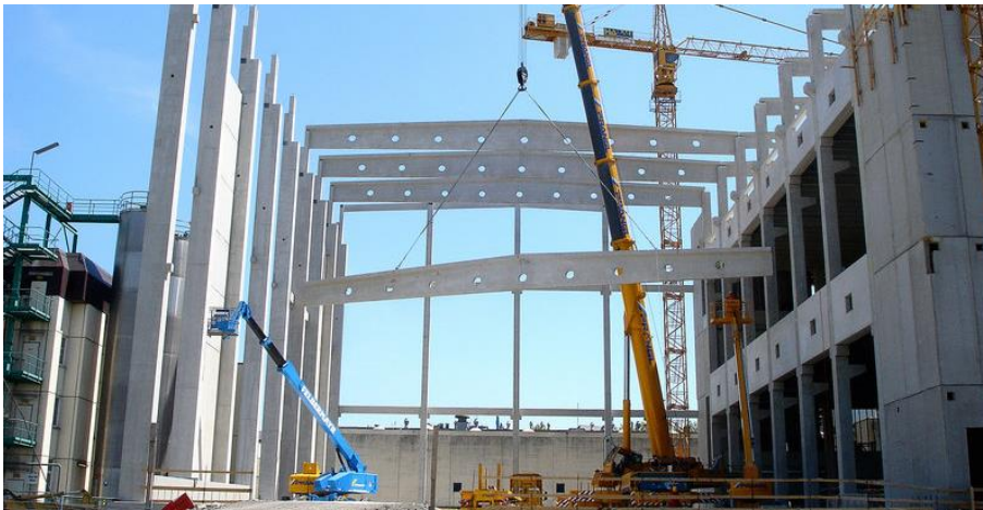
Abbildung 9-12 | Beispielbild – Versetzen von Fertigteilträgern 137
