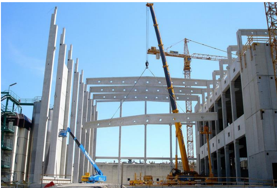
Abbildung 9-9 | Montage eines Fertigteilbinders 133
