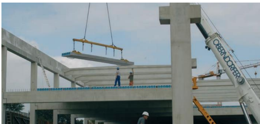
Abbildung 5-4 | Vorgespannte Hohldielendecke 65
