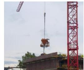
Bild 7.18 Kraneinbringung
