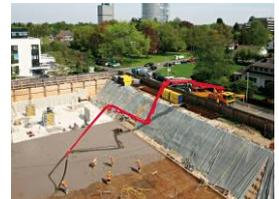
Bild 7.17 Pumpeinbringung<sup>399</sup>
