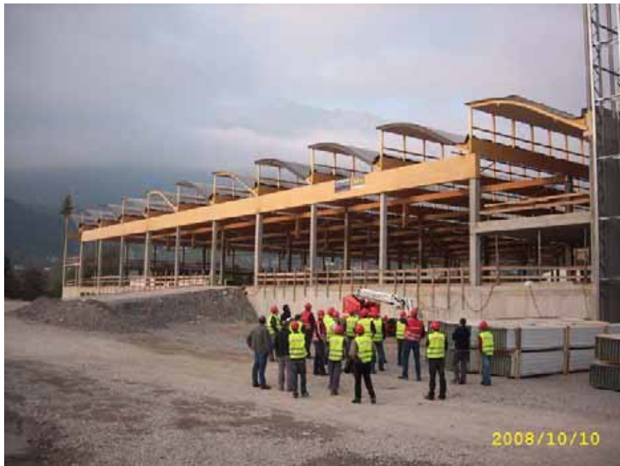
Abb. B4.14 Zur Firstfeier (Foto: Kaufmann Bausysteme GmbH)
