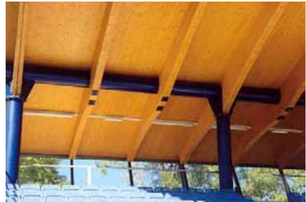
Abb. B1.12 Mittelrippen, 2-teilige Randrippen mit 3-schichtigem BSP-Aufbau, Rohr als Überzugträger (Quelle: H. Stingl)
