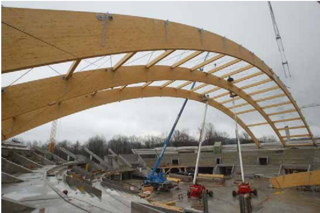
Abb. B2.12 Erstes Binderdoppelfeld mit Verbänden und Abspannseilen (Foto: WIEHAG)
