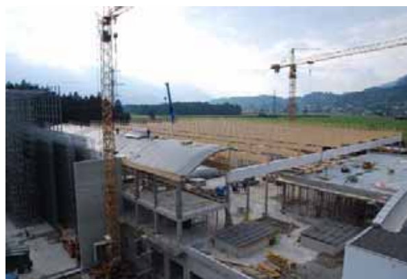
Abb. B4.13 Montage der Dachkonstruktion (Fotos: Kaufmann Bausysteme GmbH)
