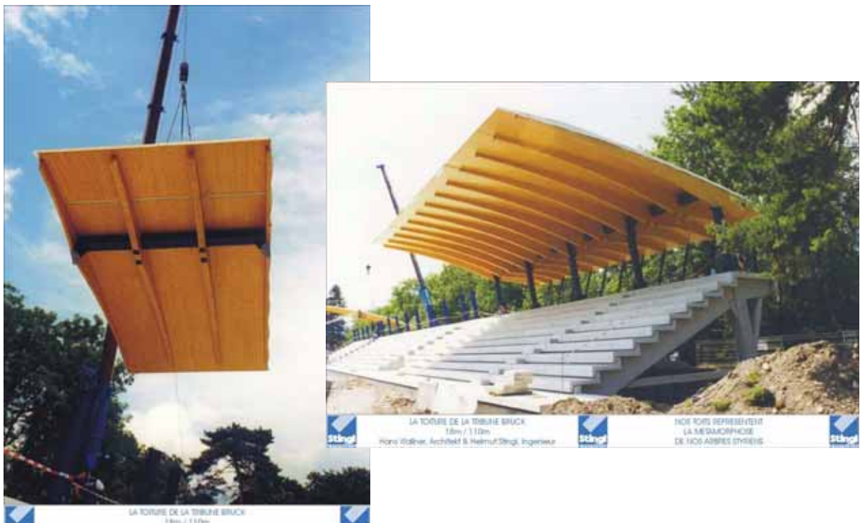
Abb. B1.22 Einheben eines Dachelementes mittels eines Mobilkrans und Bauzustand (Quelle: H. Stingl)
