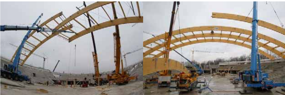
Abb. B2.11 Einheben eines fertigen Binderpaares (Foto: WIEHAG)
