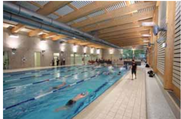
Abb. B1.2 Unionbad in Graz: Arch. DI W. Kampits / Prof. DI Dr. H. Gamerith, Graz. Statik Massivbau: DI Kager, Ziv.-Ing.-Büro Eisner, Graz. Statik Holzkonstruktion: H. Stingl, Trofaiach. Pendelwände aus BSH-Rippen mit aufgeleimten BSP-Platten. Dachtragwerk aus BSH-BSP-Elementen (Pi). (Quelle: W. Kampits)
