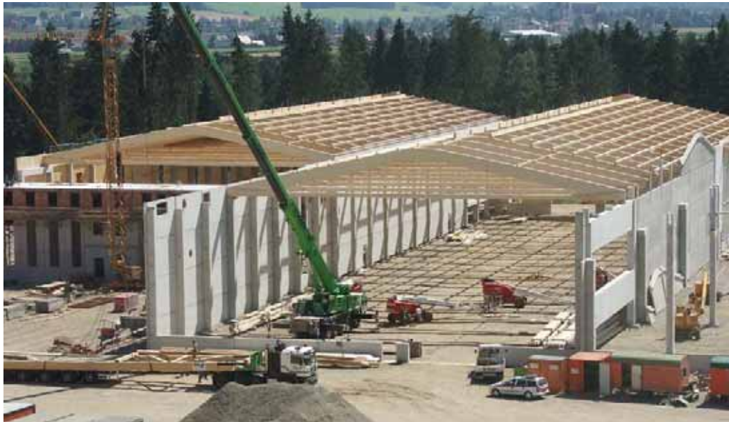
Abb. B3.6 Blick auf die entstehenden zweischiffigen Hallen während der Montage (Quelle: H. Stingl)
