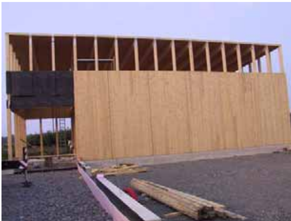
Abb. B1.2 Unionbad in Graz: Arch. DI W. Kampits / Prof. DI Dr. H. Gamerith, Graz. Statik Massivbau: DI Kager, Ziv.-Ing.-Büro Eisner, Graz. Statik Holzkonstruktion: H. Stingl, Trofaiach. Pendelwände aus BSH-Rippen mit aufgeleimten BSP-Platten. Dachtragwerk aus BSH-BSP-Elementen (Pi). (Quelle: W. Kampits)
