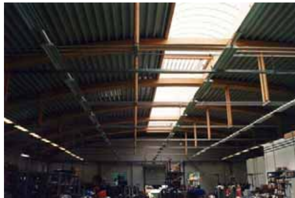
Abb. B4.18 Sport- und Freizeitzentrum in Frohnleiten, 48 m Stützweite, 11 m Binderachsteilung (links) und Produktionshalle der Rottenmanner Kabeltechnik in Rottenmann, 28 m Stützweite (rechts). (Fotos: Stingl Holzleimbau)
