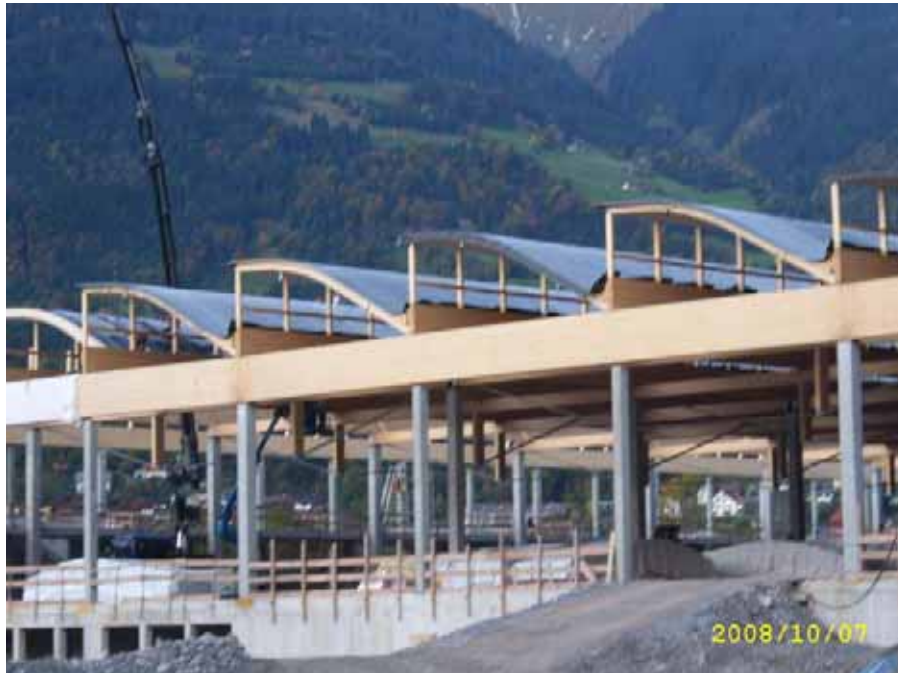
Abb. B4.6 Rohbau Dachkonstruktion (Foto: Kaufmann Bausysteme GmbH)
