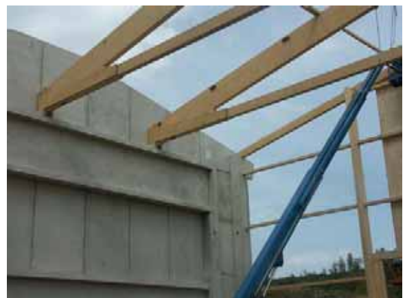
Abb. B3.16 Montage der Träger (links) und Binderauflager mit Anschluss Kerto-Platten und Stützkeilen zwischen den Gurten (rechts). (Quelle: H. Stingl)
