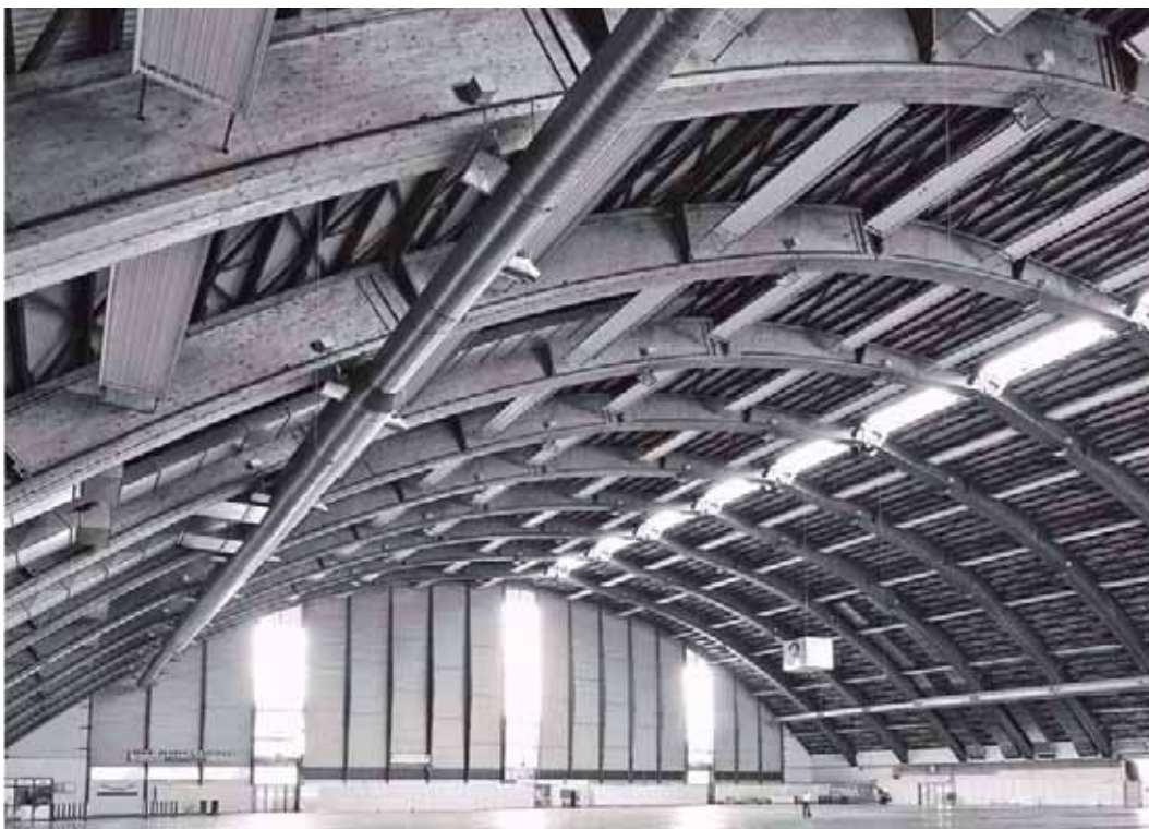
Abb. B2.2 Messehalle Klagenfurt (Halle in aktuellem Zustand), ca. 100 m Spannweite, errichtet 1966 durch die Fa. WIEHAG (Foto: Archiv WIEHAG)
