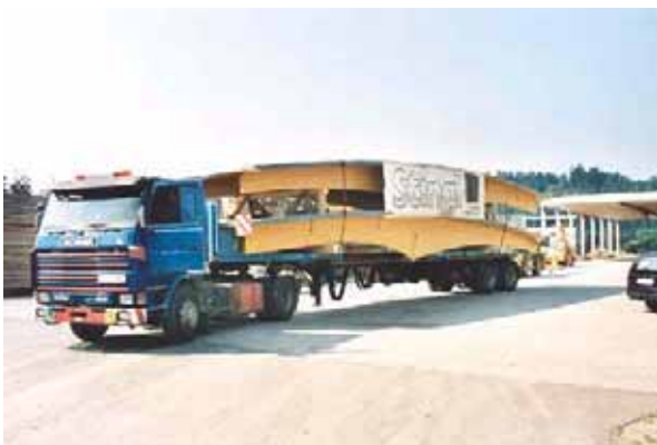
Abb. B1.21 Transport der überbreiten Dachelemente auf die Baustelle (Quelle: H. Stingl)
