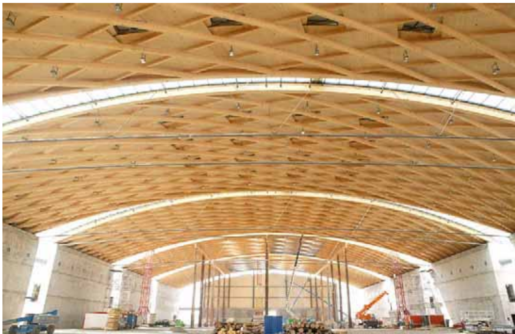
Abb. B2.3 Messehalle in karlsruhe, 85 m Spannweite, errichtet 2004 von der Fa. WIEHAG (Foto: WIEHAG)
