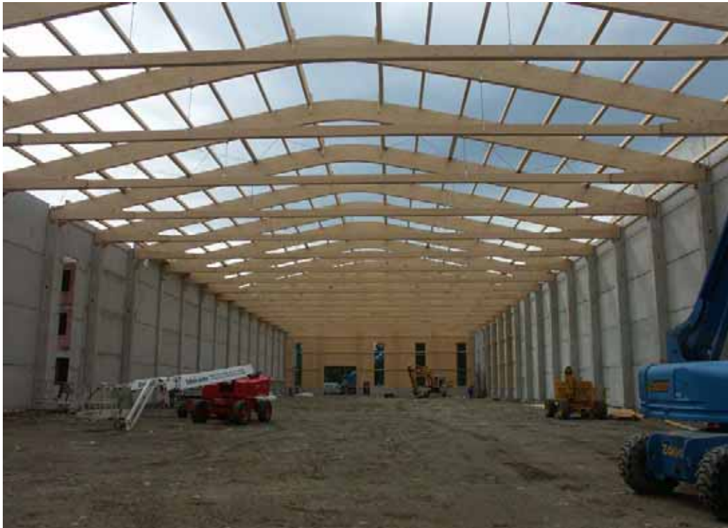
Abb. B3.17 Fertig montiertes Dachtragwerk mit Pfettenlage und Dachverbänden (erstes Hallenschiff). (Quelle: H. Stingl)
