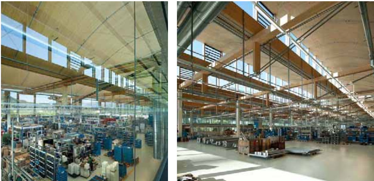
Abb. B4.4 Innenansicht mit Blick auf die Lichtbänder (links), Halleninnenansicht mit Blick auf die unterspannten Hauptträger (rechts). (Fotos: Kaufmann Bausysteme GmbH)
