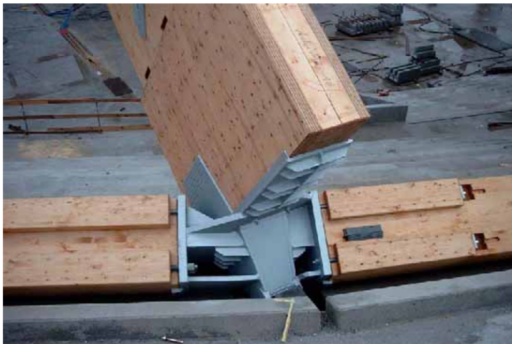
Abb. B2.13 Komplexität des Auflagerstahlteiles mit Anschluss an den „Auflagerring“ (Foto: WIEHAG)
