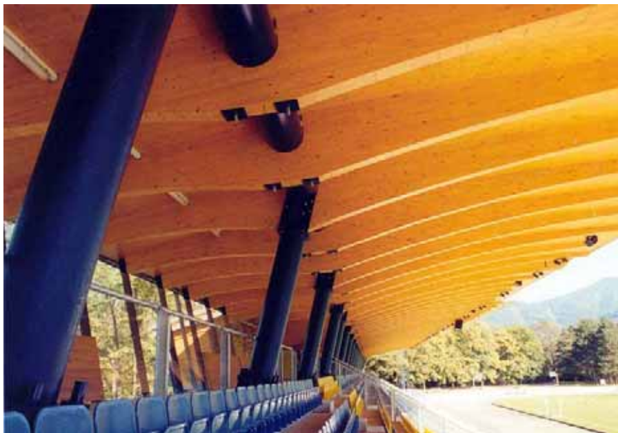
Abb. B1.10 Rundrohrstützen und Dachelemente (Quelle: H. Stingl)
