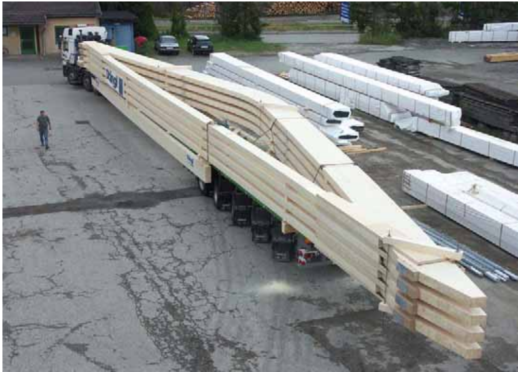
Abb. B3.15 Transport der Dachelemente auf die Baustelle (Quelle: H. Stingl)
