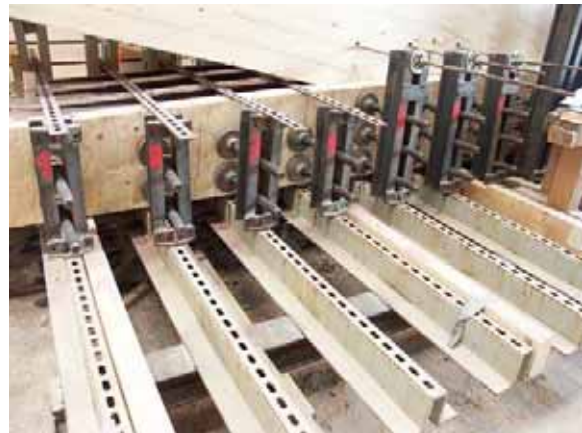
Abb. B3.13 Ansetzen der Pressen (links) und Spindelpressen zu je 7 to Presskraft (rechts). (Quelle: H. Stingl)
