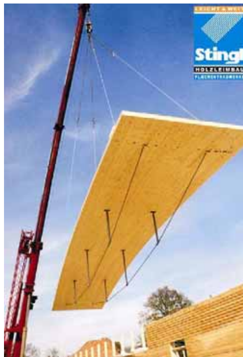
Abb. B4.17 Montage der Dachkonstruktion für Billa-Markt in Graz Andritz (Foto: Stingl Holzleimbau)
