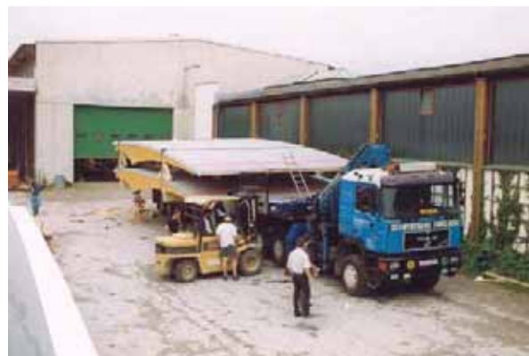
Abb. B1.21 Transport der überbreiten Dachelemente auf die Baustelle (Quelle: H. Stingl)
