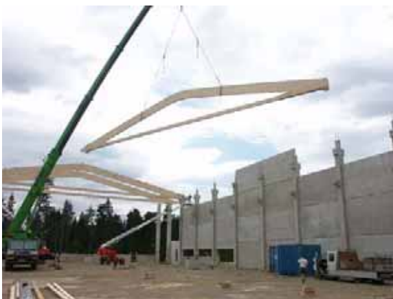
Abb. B3.16 Montage der Träger (links) und Binderauflager mit Anschluss Kerto-Platten und Stützkeilen zwischen den Gurten (rechts). (Quelle: H. Stingl)
