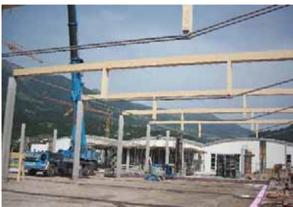
Abb. B4.13 Montage der Dachkonstruktion (Fotos: Kaufmann Bausysteme GmbH)
