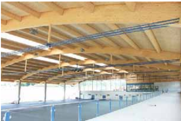
Abb. B4.18 Sport- und Freizeitzentrum in Frohnleiten, 48 m Stützweite, 11 m Binderachsteilung (links) und Produktionshalle der Rottenmanner Kabeltechnik in Rottenmann, 28 m Stützweite (rechts). (Fotos: Stingl Holzleimbau)
