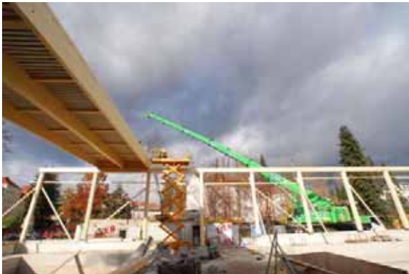
Abb. B1.2 Unionbad in Graz: Arch. DI W. Kampits / Prof. DI Dr. H. Gamerith, Graz. Statik Massivbau: DI Kager, Ziv.-Ing.-Büro Eisner, Graz. Statik Holzkonstruktion: H. Stingl, Trofaiach. Pendelwände aus BSH-Rippen mit aufgeleimten BSP-Platten. Dachtragwerk aus BSH-BSP-Elementen (Pi). (Quelle: W. Kampits)
