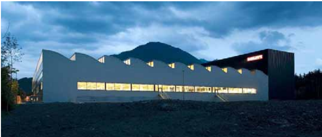
Abb. B4.1 Neu errichtete Produktionshalle der Fa. HILTI AG in Thüringen. (Foto: Kaufmann Bausysteme GmbH)
