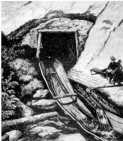
Holzstich aus dem Jahre 1847 Der Stollenausgang des 1. Durchbruches. Eine Wasserriese aus Brettern, daneben der Gehsteig. Als kleines Fensterchen ist der Stolleneingang auszunehmen.
