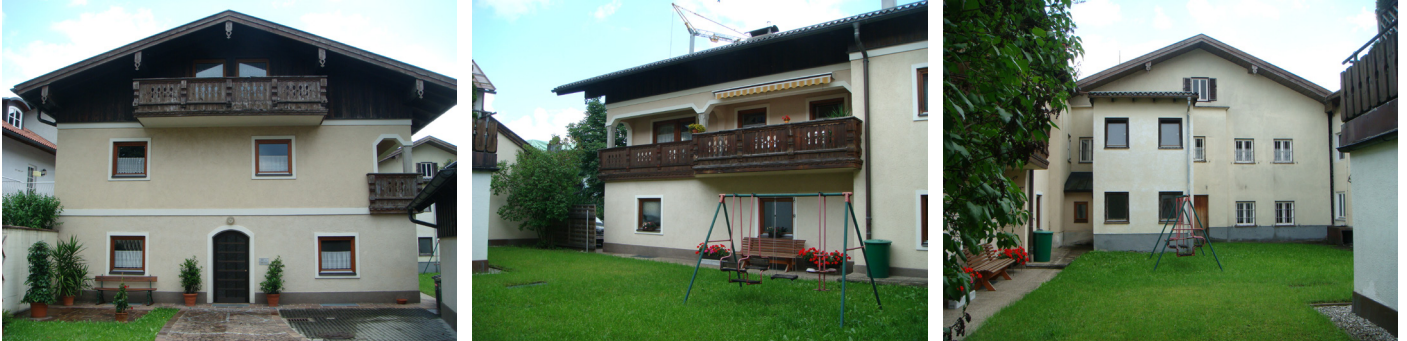
Abb. 56-58: Nord-West- und Süd-West-Fassade
