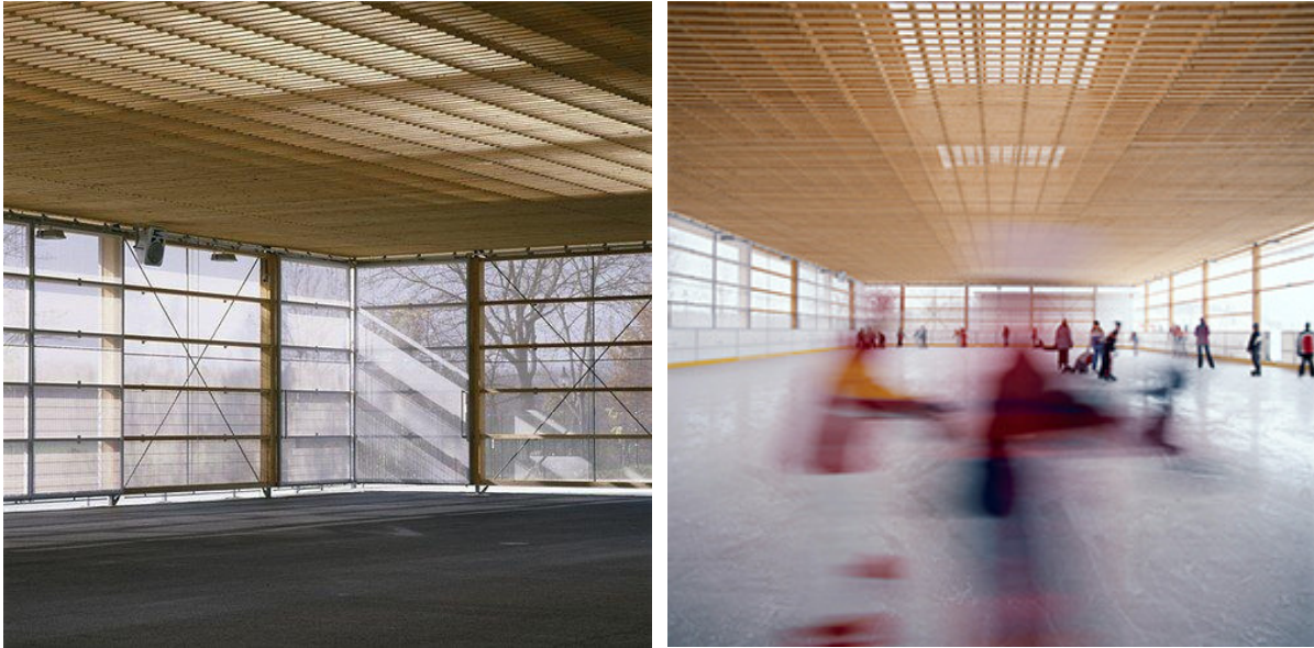
Abb. 3-2: Innenansichten der Eishalle Bergheim (© Paul Ott, Graz) 2
