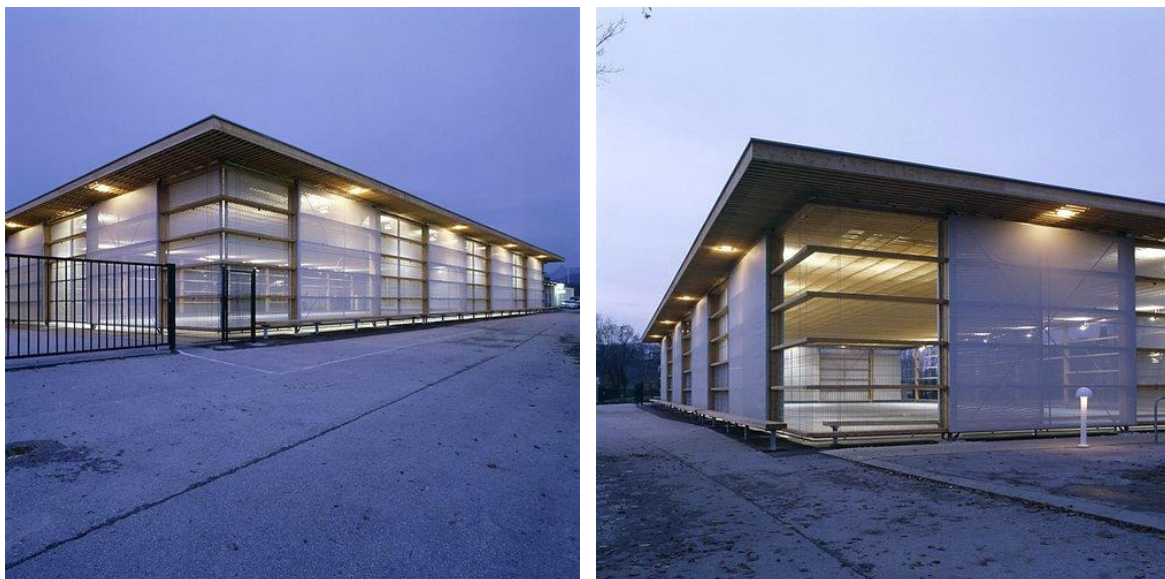
Abb. 3-1: Außenansichten der Eishalle Bergheim (© Paul Ott, Graz) 1 )
