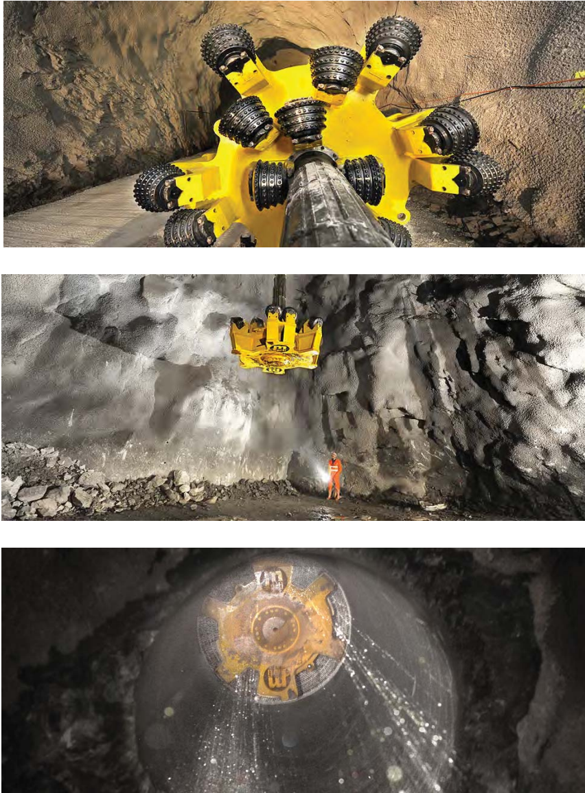
Abbildung 3.50: Aufweitkronen und Aufweitbohrung für die Herstellung der Druckschächte des PSW Nant de Drance 72
