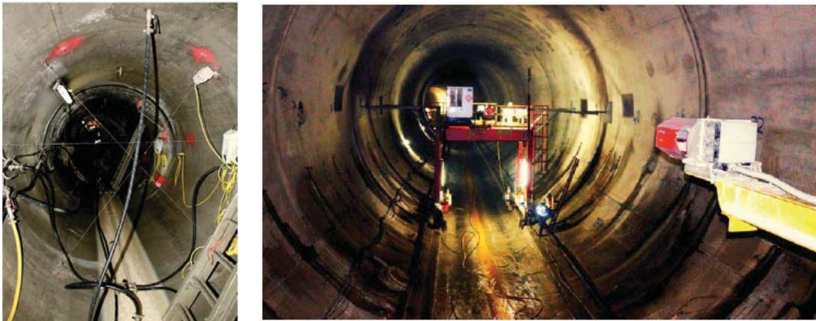
Abbildung 2.21: Kontrolle der Wirksamkeit der Vorspanninjektion über Messung der Radialverformung 60
