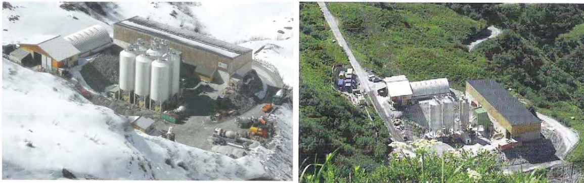
Abbildung 1.19: Mischanlage Höhenburg bei der Errichtung des PSW Limberg II auf einer Seehöhe von ca. 1.900m im Winter (linkes Bild) und Sommer (rechtes Bild) 41
