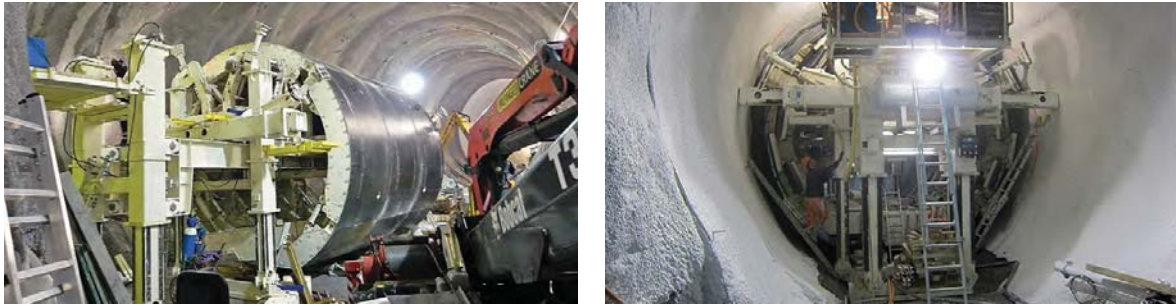
Abbildung 2.17: Fullroundschalung zur Betonage der Ortbetonauskleidung der Unterwasserdruckstollen beim PSW Limmern 50
