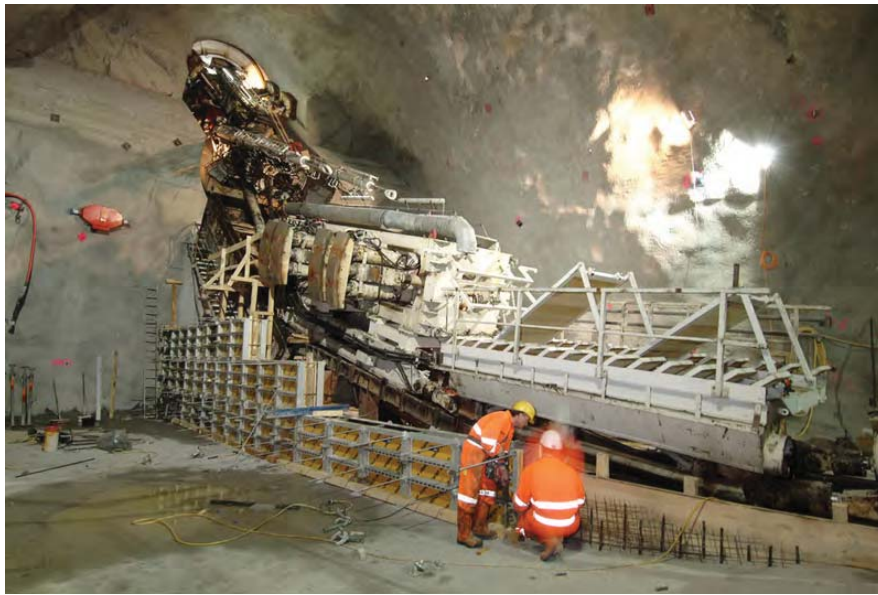
Abbildung 3.33: Montage der Gripper TBM am Schachtfuß für das Auffahren des 38,7 Grad geneigten Druckschachtes des PSW Kops II 45
