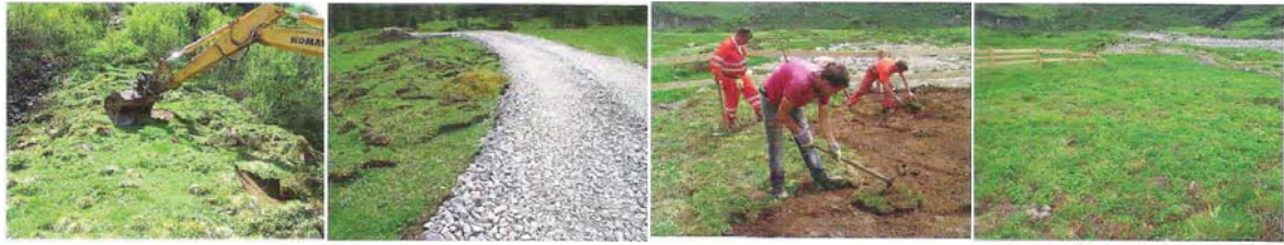
Abbildung 1.20: Bergung von Rasensoden und Oberboden bei der Errichtung einer temporären Baustraße, Rückbau und abschließende Renaturierung beim Projekt Limberg II 42
