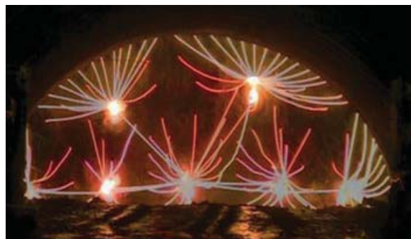
Abbildung 3.9: Initialisierung einer Vortriebssprengung mit pyrotechnischer Zündung (Schlauchzündung) 11
