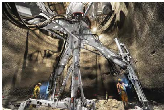
Abbildung 4.13: Herrenknecht Shaft Drilling Jumbo zur Herstellung der Sprenglöcher für die Schachtaufweitung der Druckschächte des PSW Nant de Drance 25
