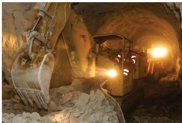
Abbildung 3.19: Tunnel - Ladegerät bei der Aufnahme und Weitergabe des Ausbruchsmaterials zum weiteren Transport an einen Muldenkipper im Druckstollen des PSW Feldsee 24
