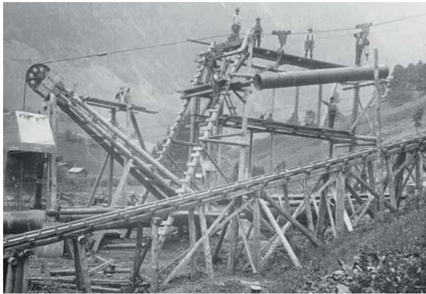
Abbildung 1.25: Errichtung der oberirdischen Druckrohrleitung des KW Bärenwerk von 1922 bis 1923 49
