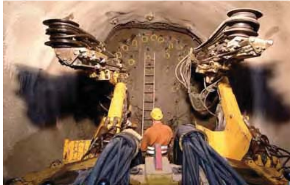
Abbildung 3.4: Vollausbuch eines Stollenquerschnittes der Unterwasserführung des PSW Kops II 5
