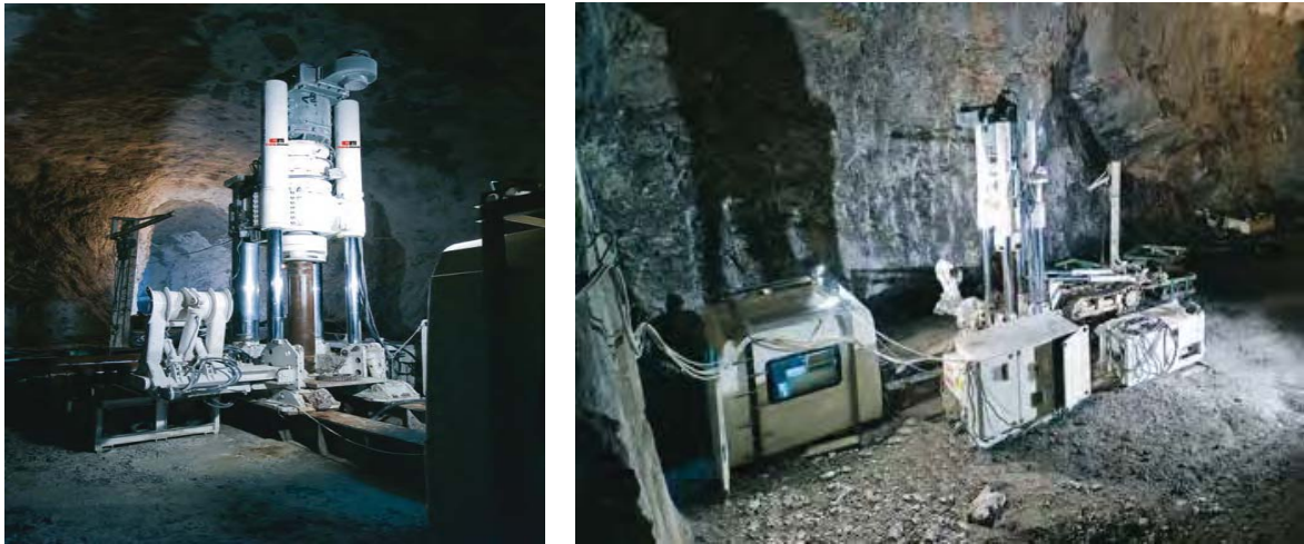
Abbildung 3.43: Raise Boring Anlage am Schachtkopf 58
