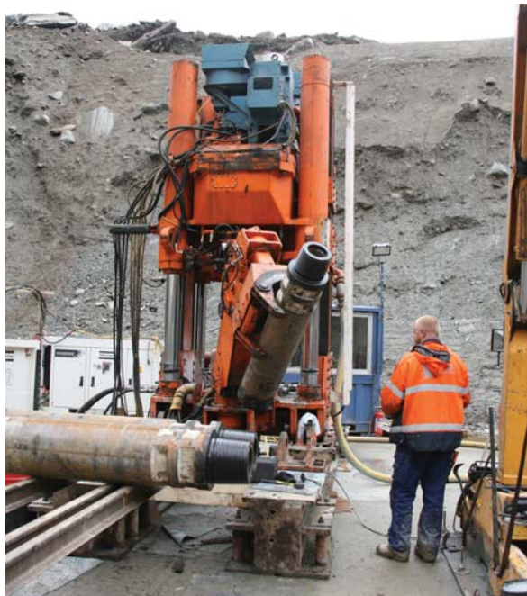
Abbildung 3.46: Bohrgestänge und Gestängemanipulator bei der Errichtung des Druckschachtes für das PSW Feldsee 64
