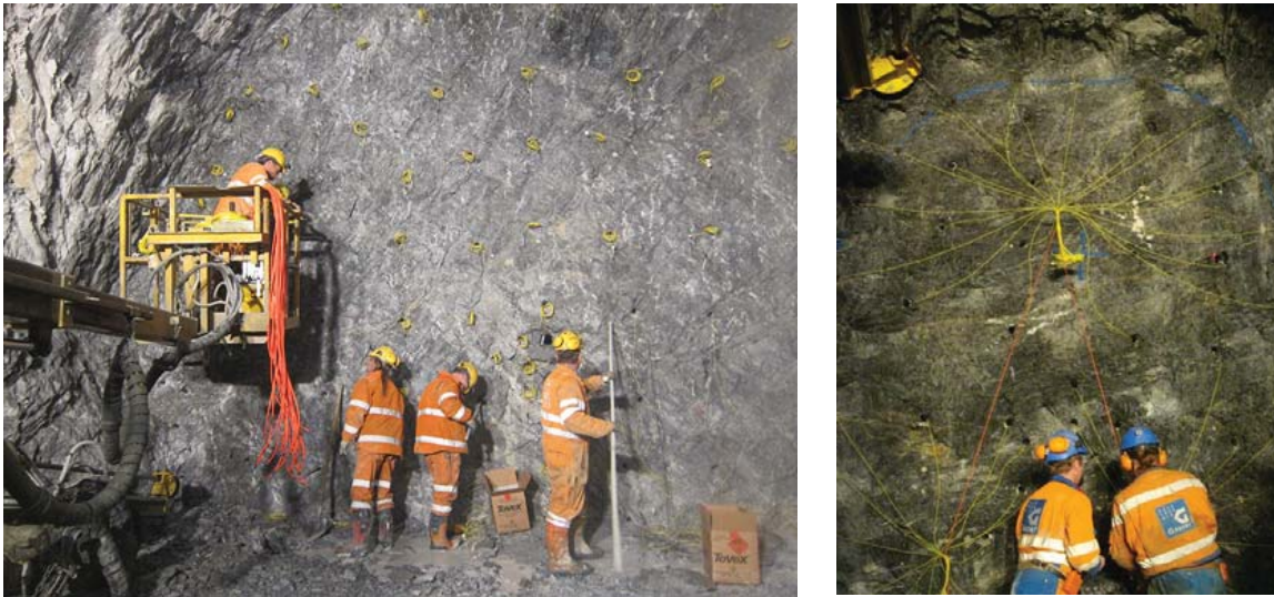
Abbildung 3.17: Einsatz von Schlauchzündern im Stollen- und Kavernenvortrieb 22 linkes Bild: Laden der Ortsbrust mit Schlauchzündern und patroniertem Sprengstoff rechtes Bild: Bündeln der Schlauchzündern eines Abschlages
