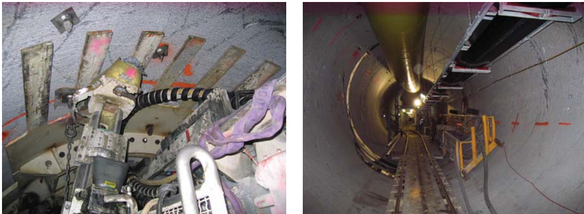
Abbildung 2.10: Vortriebsarbeiten für den ca. 6 km langen Druckstollen des Bogong Hydropower Project in Australien mit einer Gripper TBM 33
