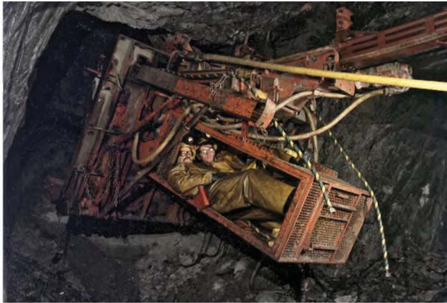
Abbildung 3.41: Alimak Arbeitsbühne am Schachtfuß beim Einfahren in einen Schacht unter sehr beengten Platzverhältnissen 54
