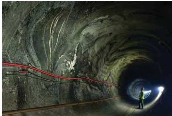
Abbildung 2.13: Maschinell aufgefahrener Druckstollen des PSW Glendoe ohne Auskleidung 41
