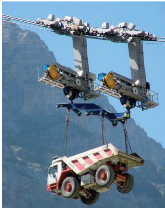
Abbildung 1.17: Bauseilbahn mit 40t Ausnahmelast zur Erschliessung des Baubereiches für das PSW Limmern 37
