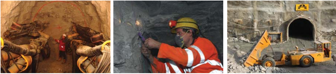
Abbildung 4.4: Vortriebsarbeiten beim Sprengvortrieb im Druckstollen des PSW Feldsee 9
