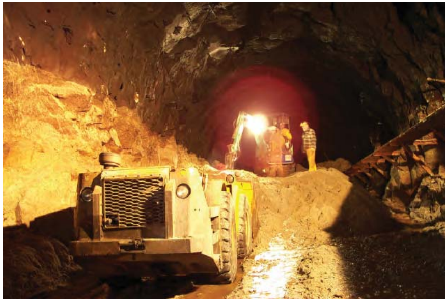
Abbildung 2.9: Räumung des Sandfangs "Rock and Sand Trap" eines nicht ausgekleideten Druckstollens 31
