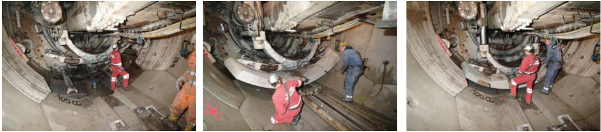
Abbildung 2.18: Einbau eines Sohltübbings innerhalb des Schildmantels der DSM bei der Errichtung des Druckstollens für das PSW Kops II 55
