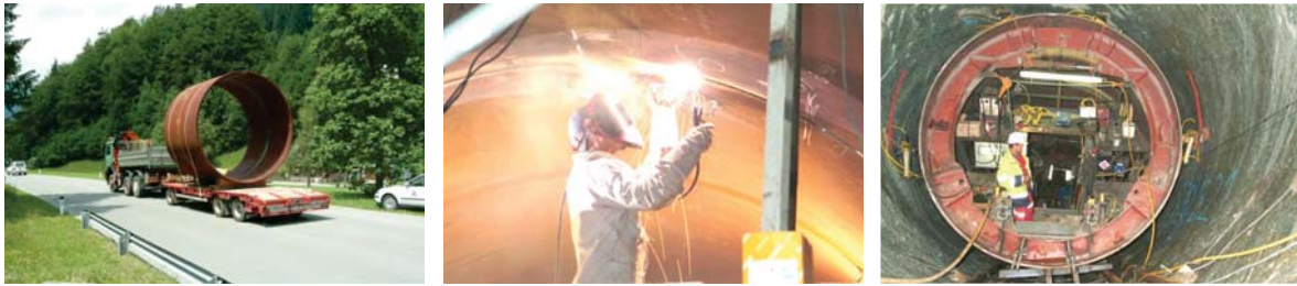
Abbildung 2.22: Arbeiten zur Panzerung des Druckschachtes beim PSW Kops II 69
