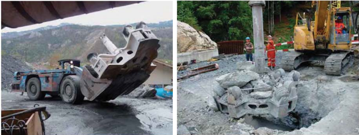
Abbildung 3.48: Aufweitkrone mit einem Ausbruchsdurchmesser von 3,05 für die Herstellung eines 53 Grad geneigten Schrägschachtes zur Aufnahme der Druckrohrleitung beim KW Schattenhalb 3 68
