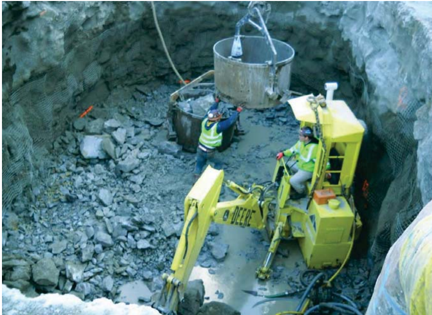
Abbildung 3.36: Schutterung an der Schachtsohle beim zyklischen Abteufen eines Schachtes im Festgestein 49
