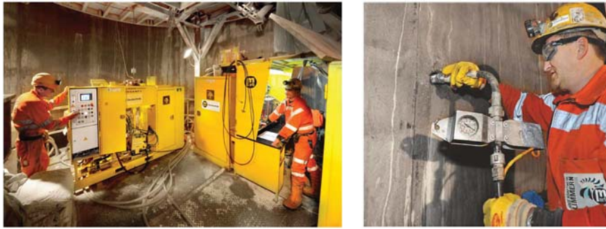
Abbildung 4.15: Injektionsarbeiten im Druckschacht des PSW Nant de Drance 28
