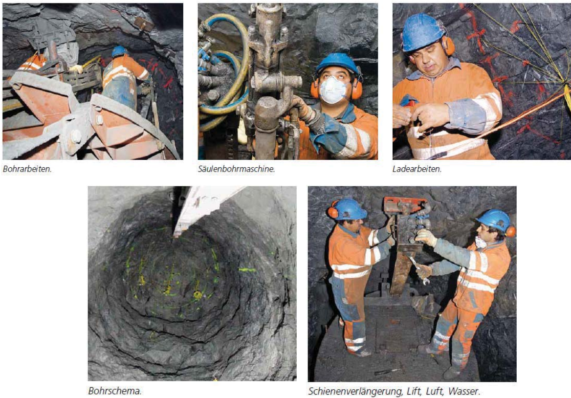
Abbildung 3.40: Arbeiten zum Auffahren eines 55 Grad geneigten Schachtes im Rahmen des Projektes KWO plus mittels Alimak Verfahren 53
