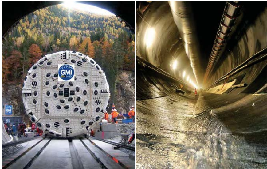
Abbildung 4.8: Hauptzugangstunnel zur Kavernenzentrale des PSW Nant de Drance 19 Linkes Bild: Gripper TBM nach der Montage am Installationsplatz Rechtes Bild: Ableitung von Bergwasserzutritten über die Tunnelsohle
