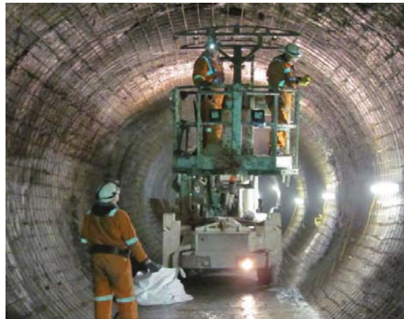
Abbildung 2.16: Bewehrungsarbeiten zur nachträglichen Auskleidung mit Spritzbeton beim PSW Glendoe 48
