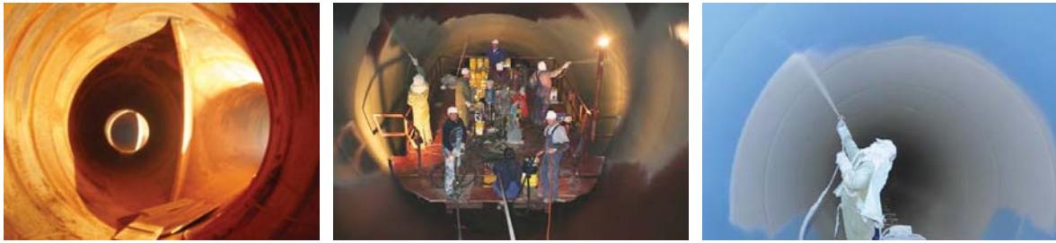
Abbildung 2.24: Korrosionsschutz- und Beschichtungsarbeiten am gepanzerten Triebwasserweg einer Hochdruckanlage 73
