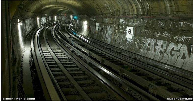
Abbildung 51: Oberbau mit sechs Schienen der Pariser Metro [37]
