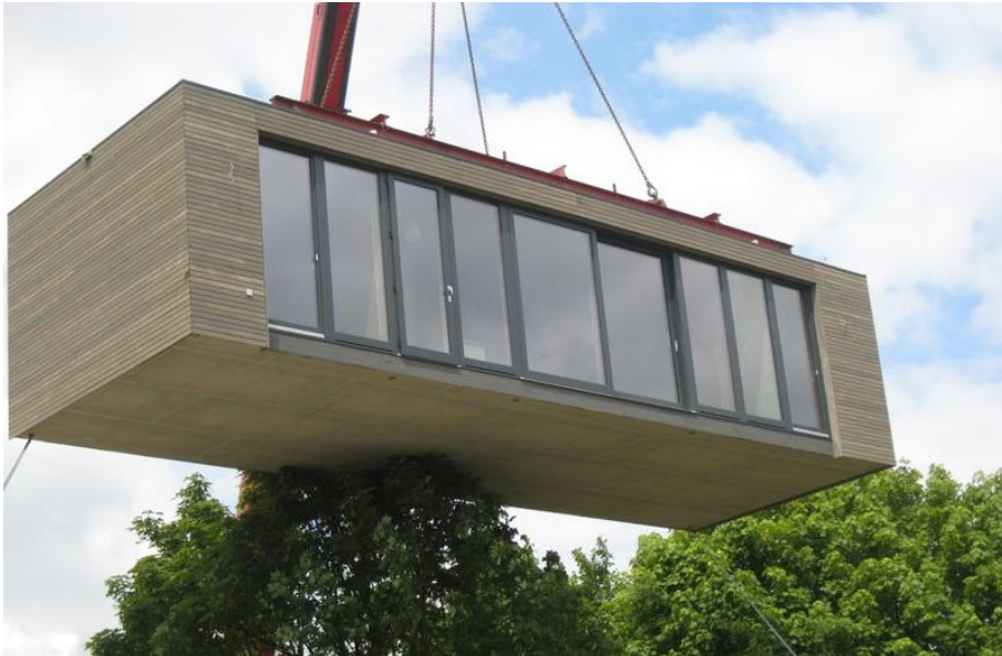
Abbildung 66 Beispiel einer fertigen Raumzelle aus Holz 543
