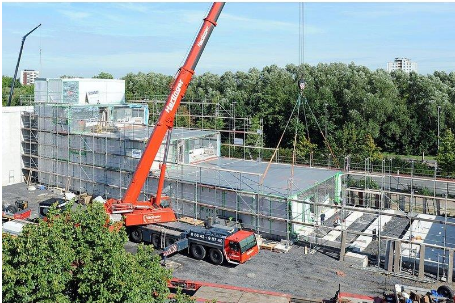
Abbildung 29 Baustellenmontage Modulbau 244
