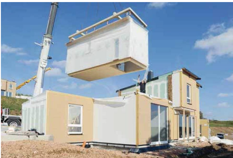
Abbildung 96 Montage der Module 693
