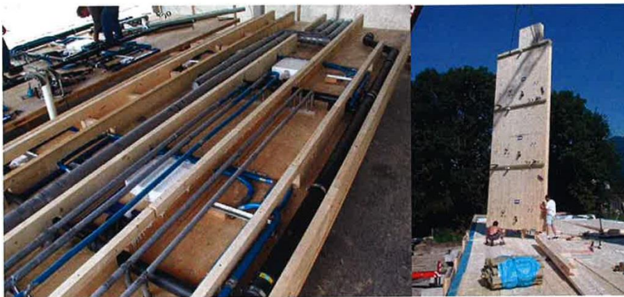
Abbildung 59 komplett vorgefertigter Sanitärschacht eines dreigeschossigen Gebäudes 424
