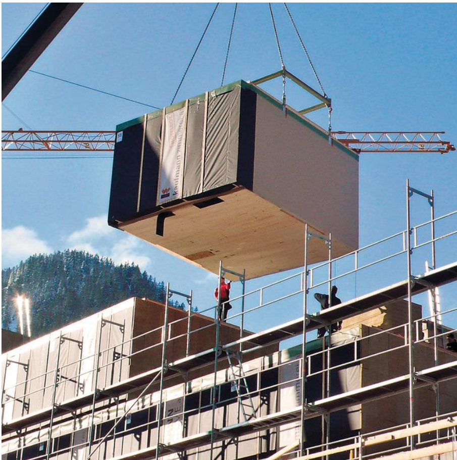
Abbildung 39 Positionierung der fertigen Raummodule 272
