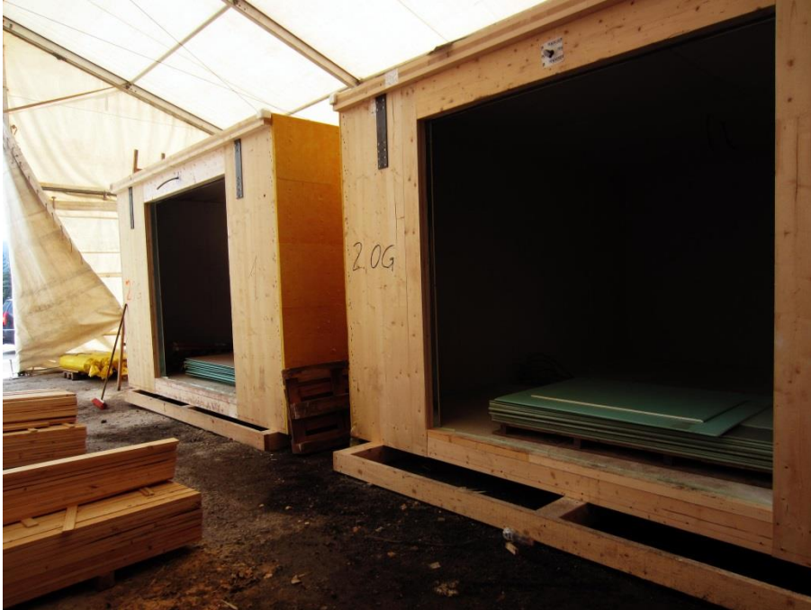
Abbildung 32 Vorgefertigte Raumzellen des Kurhotel Weissenbach 257
