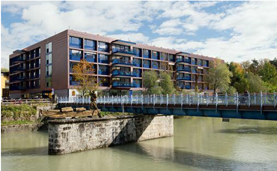
Abbildung 31 Seniorenwohnheim in Hallein aus modularer Bauweise 252
