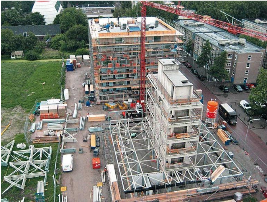
Abbildung 36 zentraler Erschließungskern aus Stahlbeton 264
