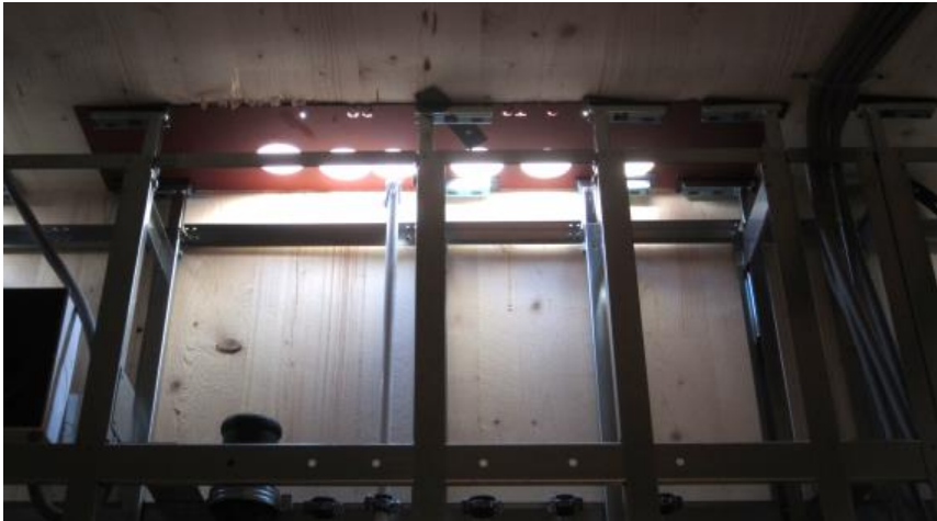
Abbildung 67 oberer Anschluss des teilvorgefertigten Gebäudeschachts 563
