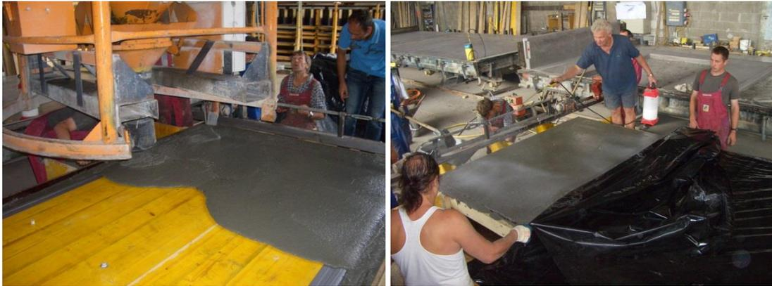
Abbildung 5.3: Einbringung des Betons, Aufsprühen des Verdunstungsschutzes und Folienaufbringung für VBT 190 [IBB, SW]
