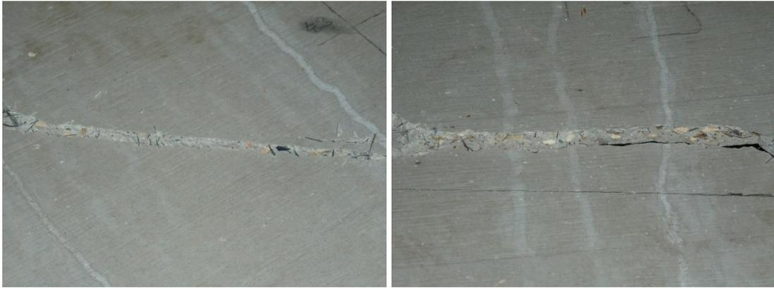
Abbildung 6.5: Schubsammelrissbereich VBT 190-02 [Verfasser, LKI]
