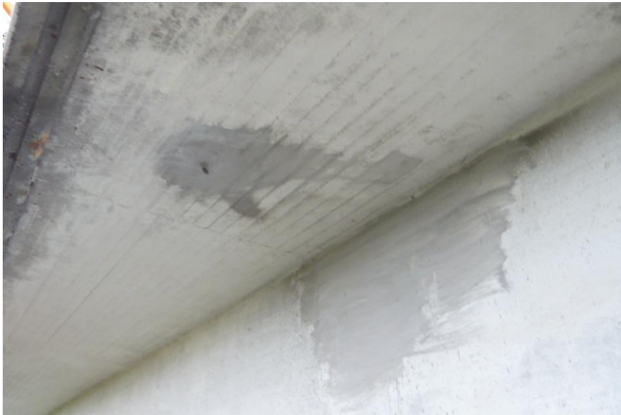
Bild 2.41 Kurzer Ablaufstutzen und Wasserverfrachtung zum Hauptträger (Krummbachbrücke, 06.09.2007) [37]
