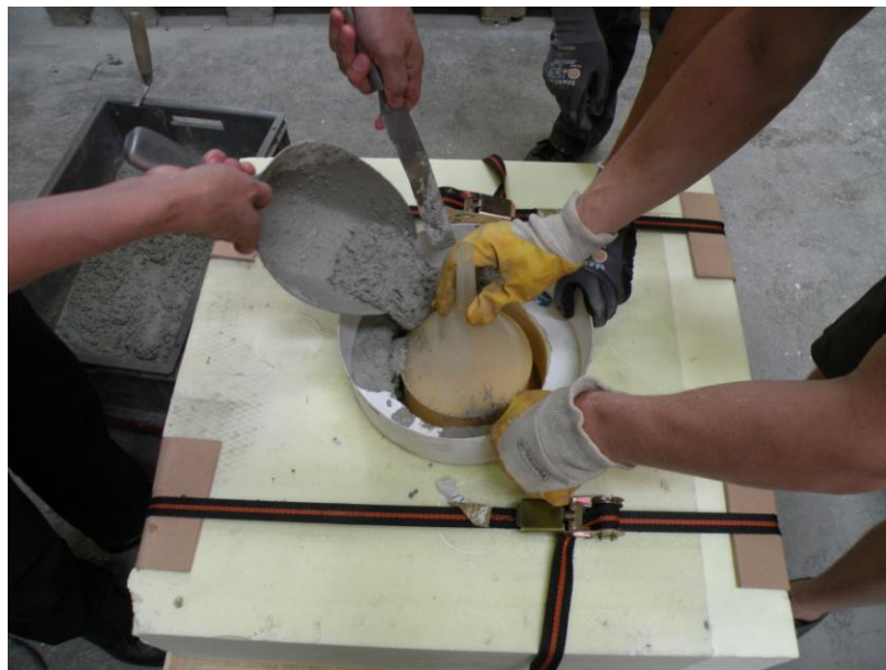
Bild 6.7 Befüllen der Schalung
