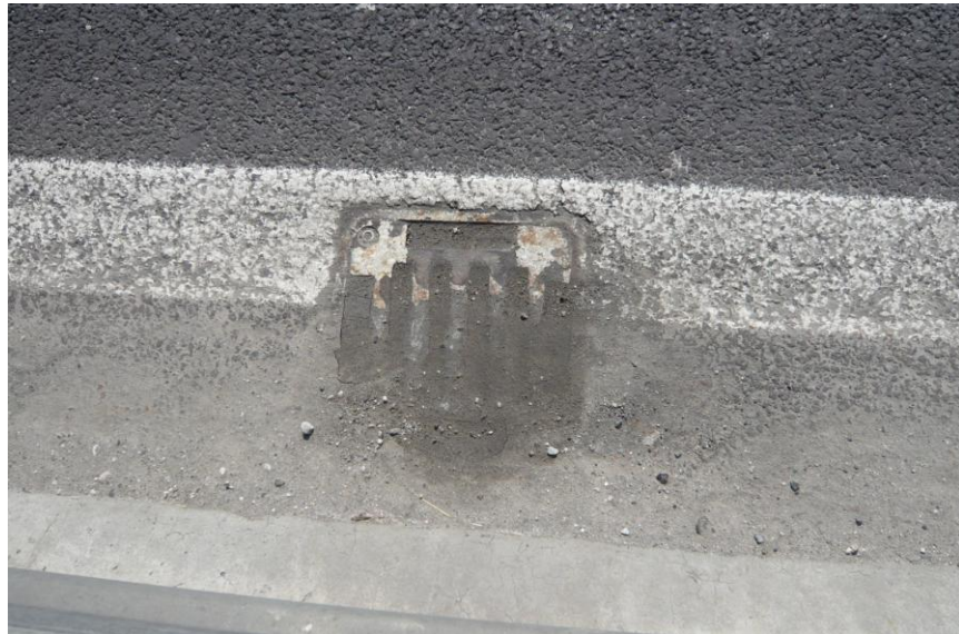
Bild 2.49 Verlegter Brückeneinlauf (A9 B2, 06.04.2009) [37]
