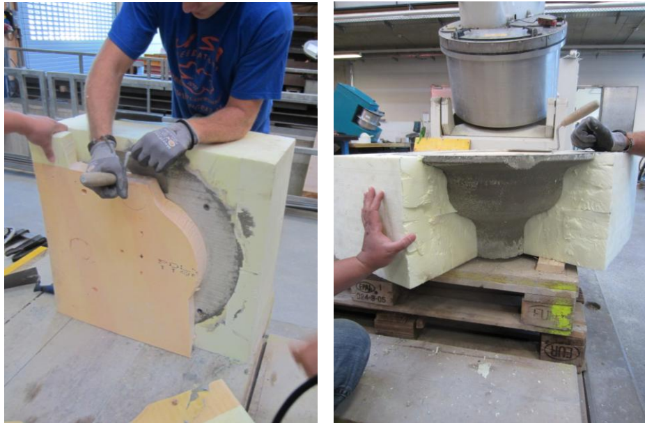
Bild 6.8 Entfernen der XPS-Schalung
