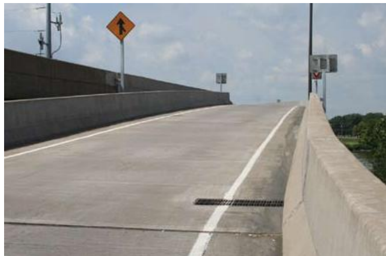
Bild 2.28 ACO BridgeDrain Einbaubeispiel [31 S. 65]
