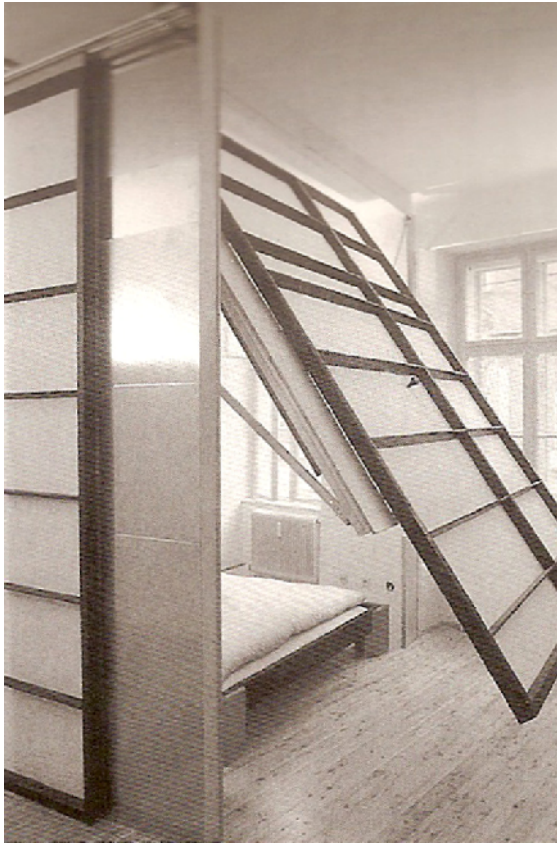
Abb. 23: Garagentore als Raumtrenner
