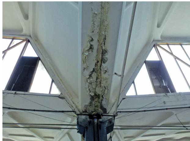
Abb. 140 Raffinerie Korrosion Tragwerk
