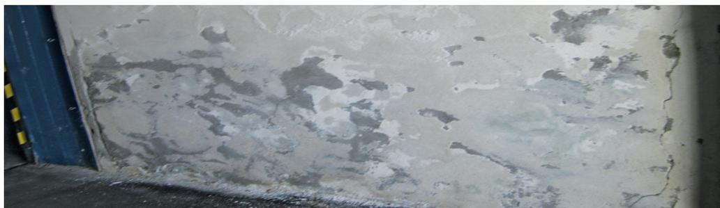
Abb. 56 Feuchte Mauer Schauofenhalle
