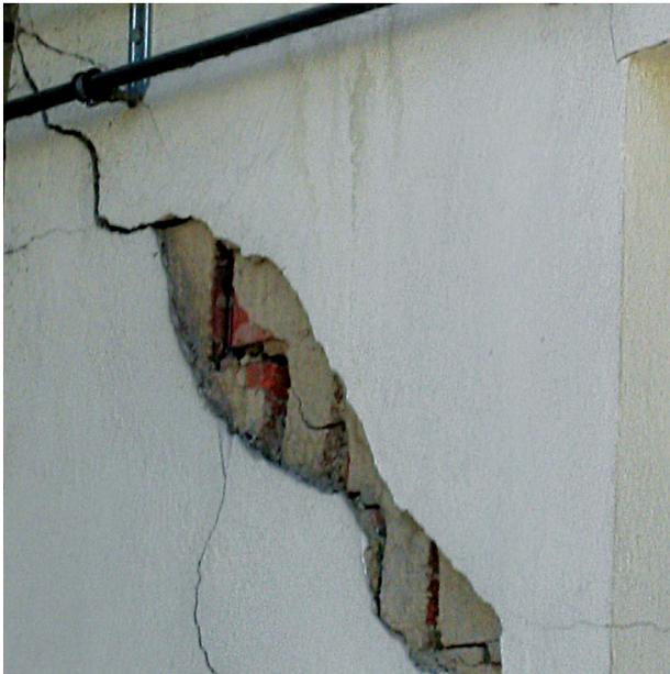
Abb. 143 Mauerriss an Außenfassade
