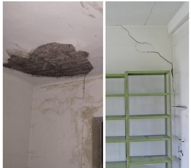
Abb. 64 Gefahrstofflager Decke im 1OG Mauerriss im Erdgeschoss
