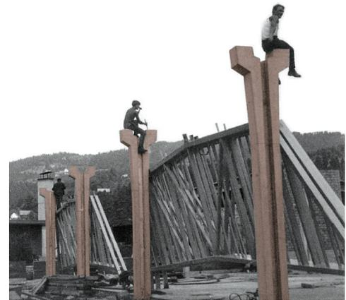
Abb. 45 Fertigteile für die Schedkonstruktion 1971
