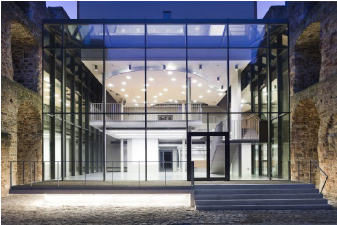
Abb.33 - Cafeteria der Zeughaus Ruine Kassl
