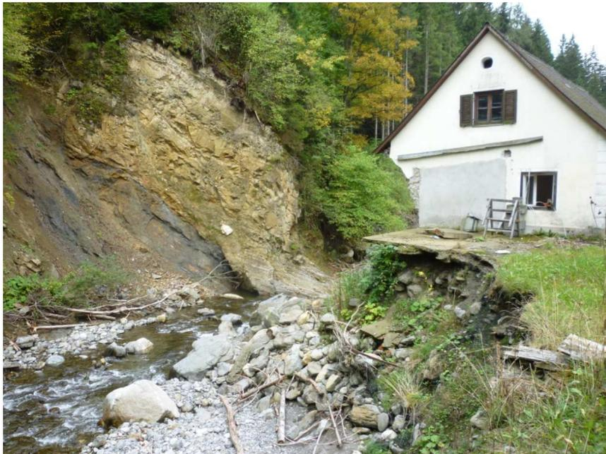
Abbildung 29: Durch Seitenerosion zerstörtes Wohnhaus am Schöttlbach
