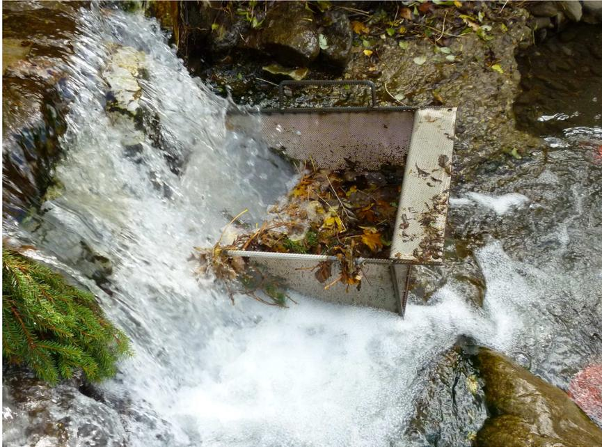
*Abbildung 9: Beweglicher Geschiebefänger am Krumeggerbach in Oberwölz*
