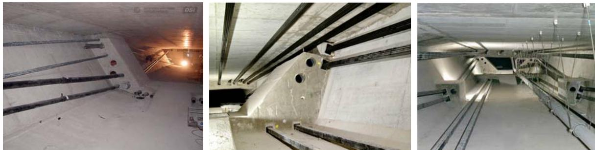
Abbildung 2 Externe Vorspannung im Kastenquerschnitt [11],[12]
