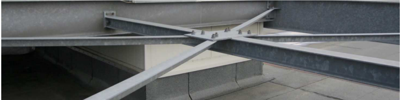
Abb. 1-2 Beispiel für Winkelprofile mit Zwei-Schrauben-Verbindungen (Quelle: Haslinger Stahlbau GmbH)
