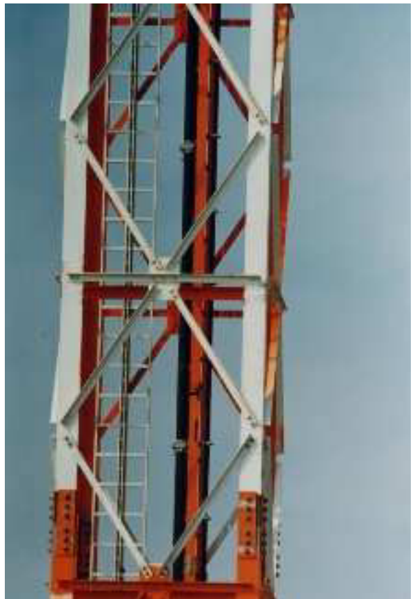
Abb. 1-1 Beispiel für die Anwendung von Winkelprofilen im Mastbau aus [11]
