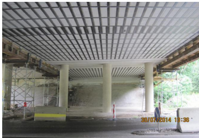
Abbildung 2-2: Anwendungsbeispiel einer CFK verstärkten Brücke 2
