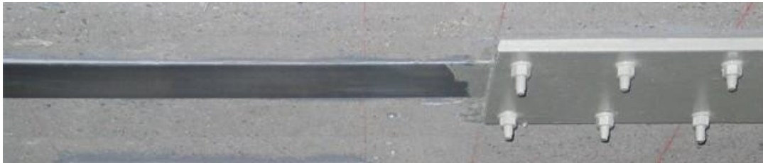
Abbildung 2-3: Verankerungsplatte der Firma S&P 3
