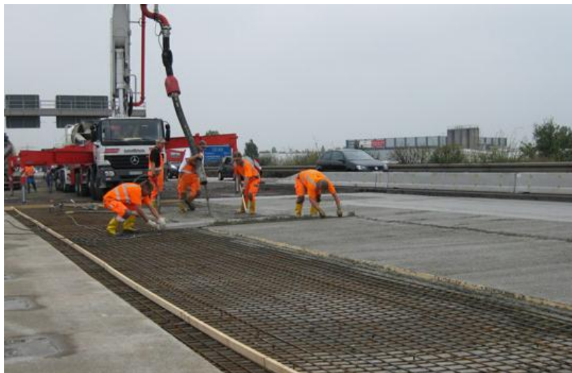
Abbildung 8-1: Aufbeton einer Fahrbahn 24
