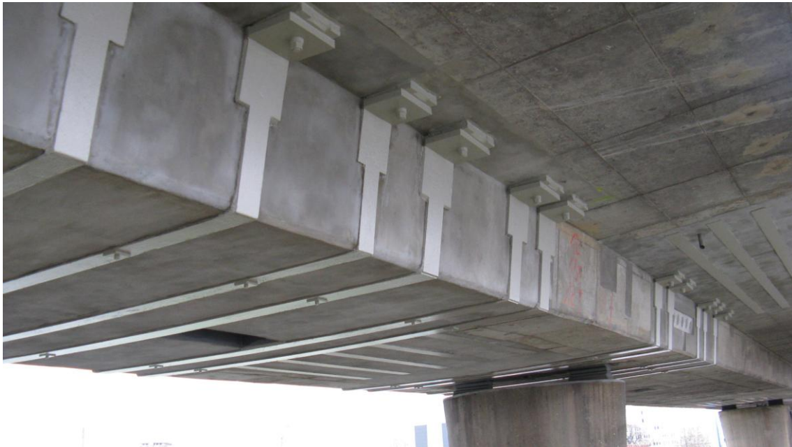
Abbildung 8-2: Brückenverstärkung mittels Stahllaschen 25
