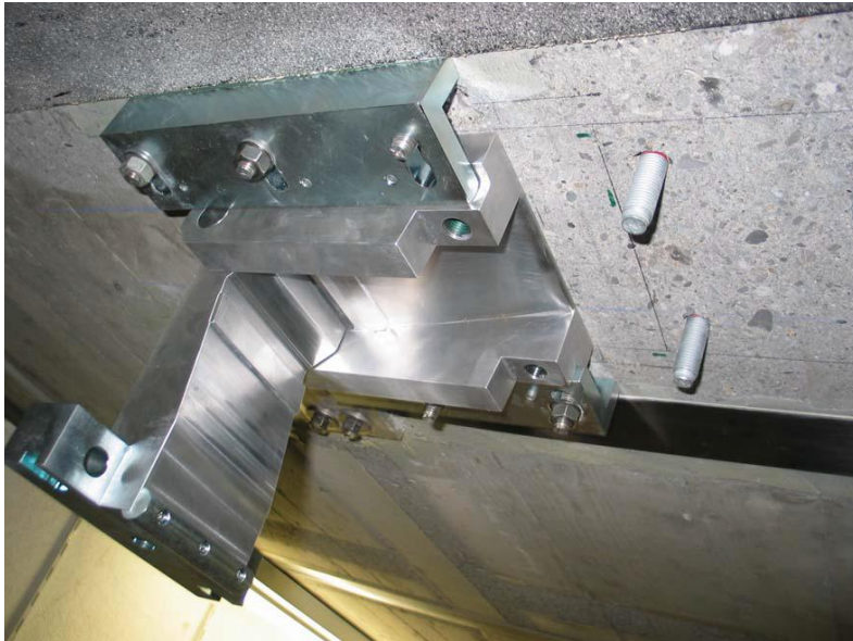
Abbildung 4-3: Klemmschuh eines vorgespannten Systems 13
