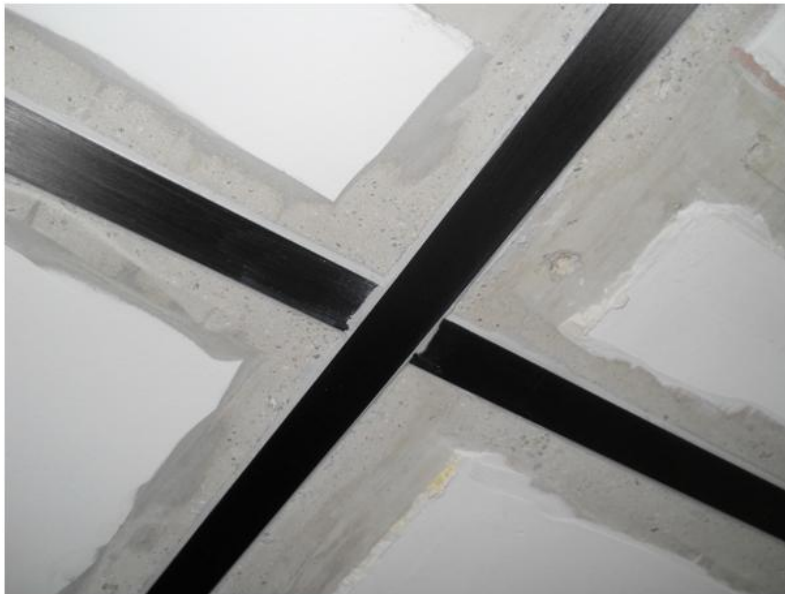
Abbildung 4-2: Oberflächlich verklebte Kohlenstofflamellen 12
