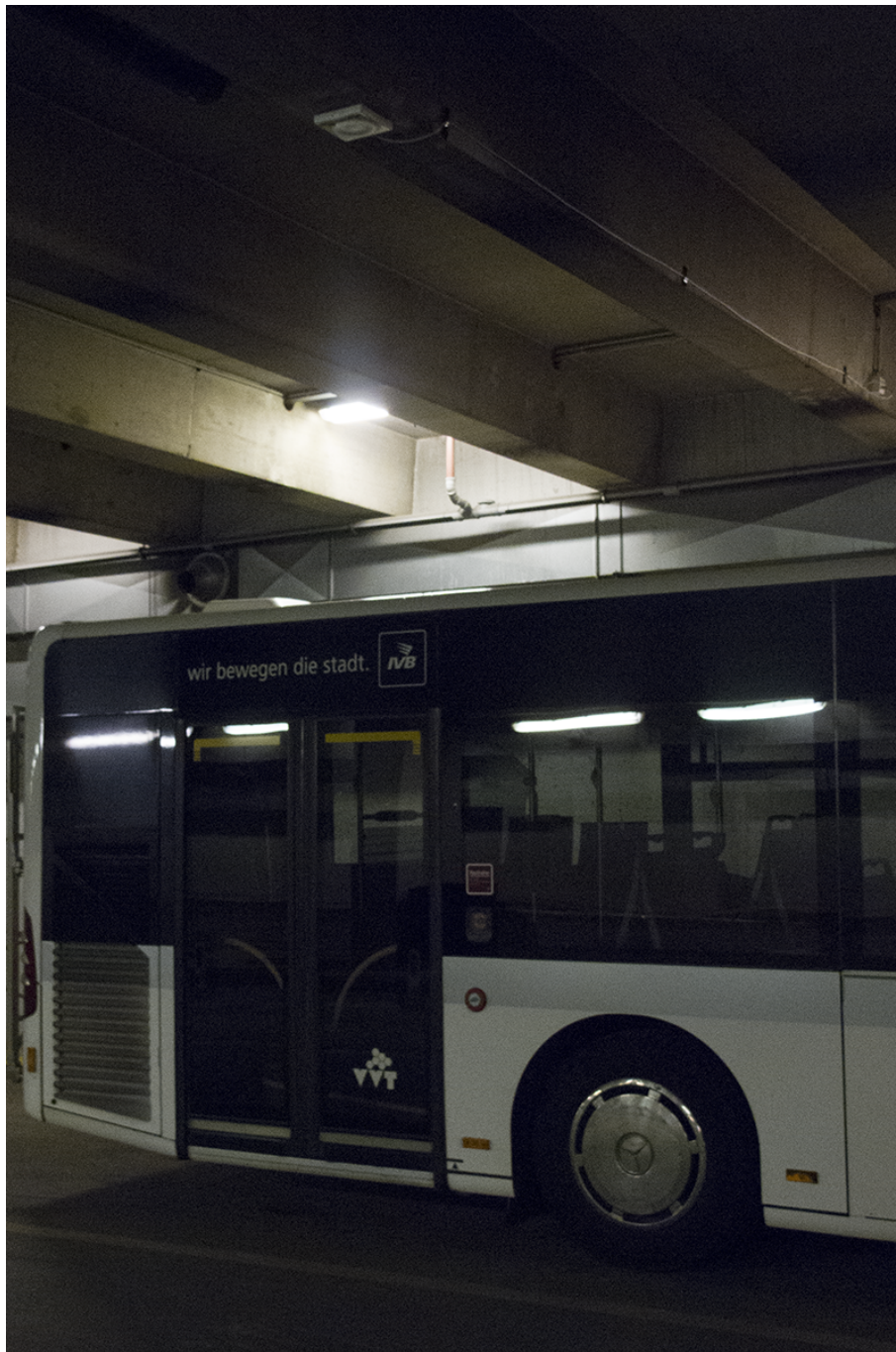
Abbildung 4.5: Neumontage von Access Point AP-51-58 kopfüber an der Decke.
