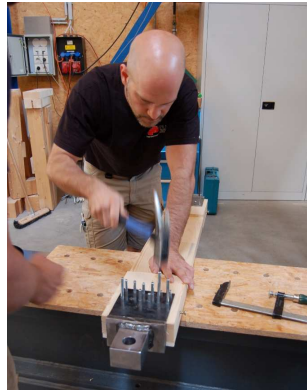
Abb. 5.27 Montage der Stahlteile zur Lasteinleitung
