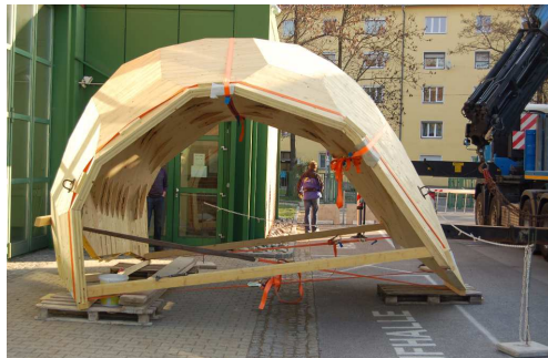
Abb. 7.9 Dach und Mittelteil (Quelle: IAM-TU-Graz)
