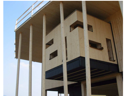
Abb. 2.3 Einsatz von BSP als Wand-, Dach- und Deckenbauteil im Bauzustand links: Bauvorhaben Volksschule Seiersberg, rechts: Bauvorhaben Sonneninsel Seekirchen (Quelle: ZT Büro Koppelhuber, Rottenmann)
