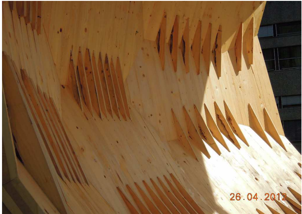
Abb. 7.22 Detail Holz-Holzverbindung
