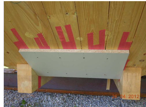
mechanische Sicherung der Klebebänder
