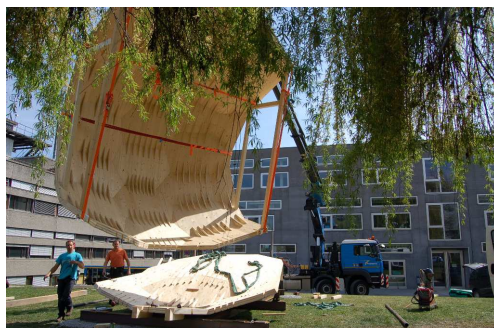
Abb. 7.11 einrichten und fixieren der beiden Teile in der Endlage (Quelle: IAM-TU-Graz)
