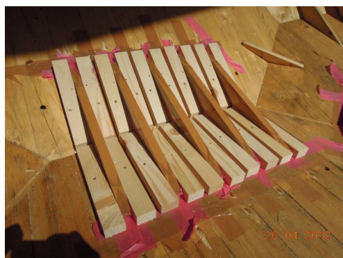
Abb. 7.15 mechanische Sicherung der Klebebänder
