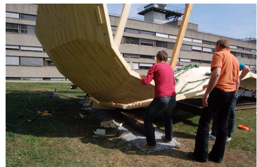
Abb. 7.11 einrichten und fixieren der beiden Teile in der Endlage (Quelle: IAM-TU-Graz)
