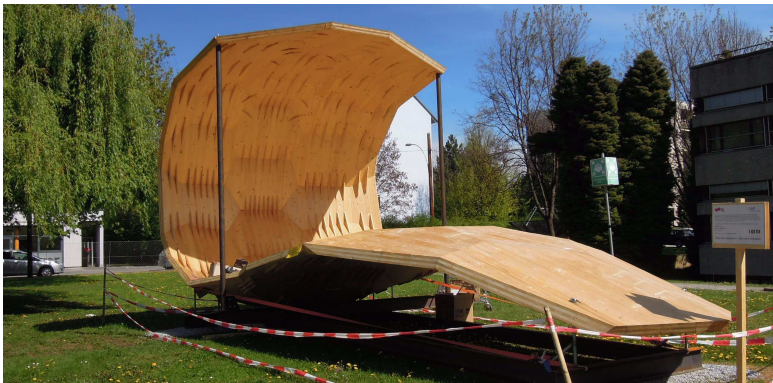
Abb. 7.12 Durch Stahlstützen wurden die Bauwerksteile in der Sollage fixiert
