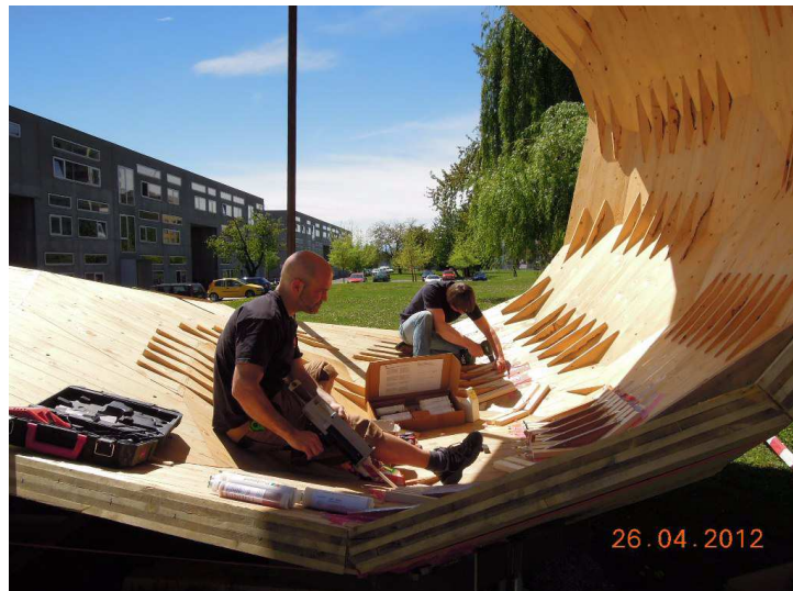
Abb. 7.18 herstellen der Baustellenverklebung
