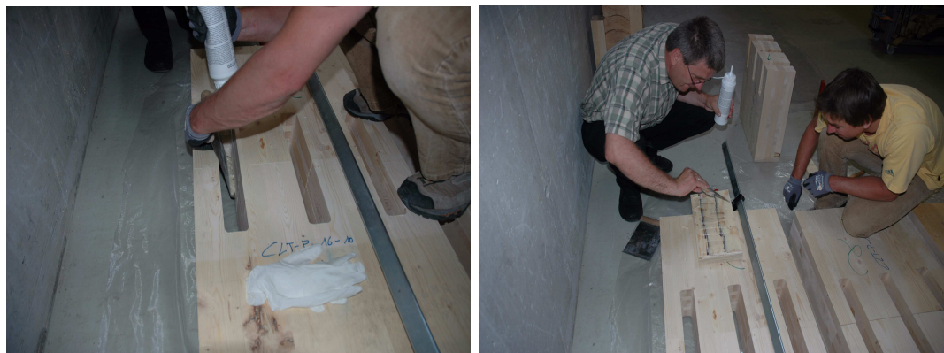
Abb. 5.19 Beleimen von Schlitz und Verbinder mit der Zahnspachtel
