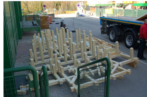
Abb. 7.5 Abbund der Rüstung auf der CNC-Anlage, die fertige Rüstung. (Quelle: IAM-TU-Graz)
