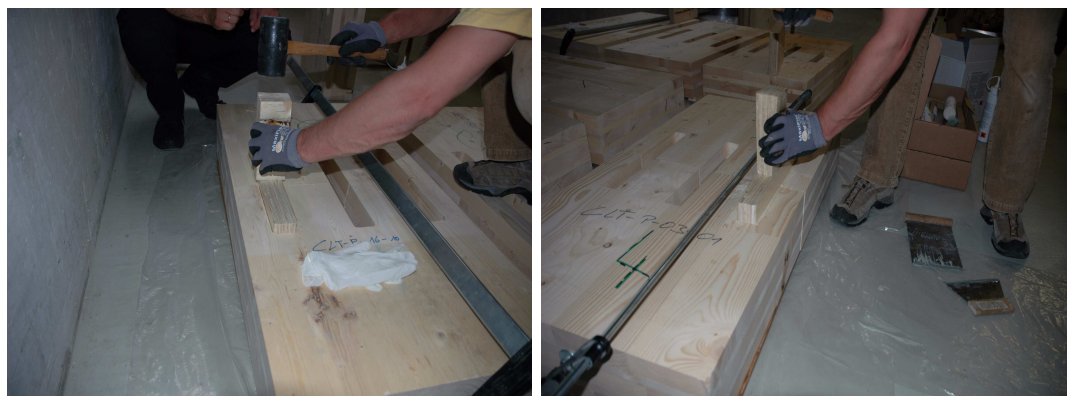
Abb. 5.20 Zentrisches Einbringen des Kerto-Verbinders, Einschlagen mit dem Gummihammer
