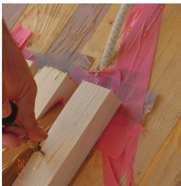
Abb. 7.17 verschließen der Kontrollbohrungen
