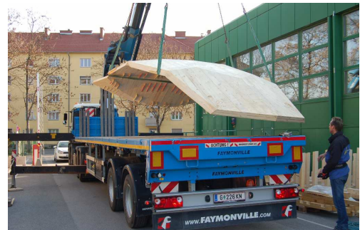
Basisteil bei der Verladung auf den LKW
