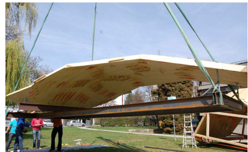
Der Basisteil auf dem Stahlrahmen
