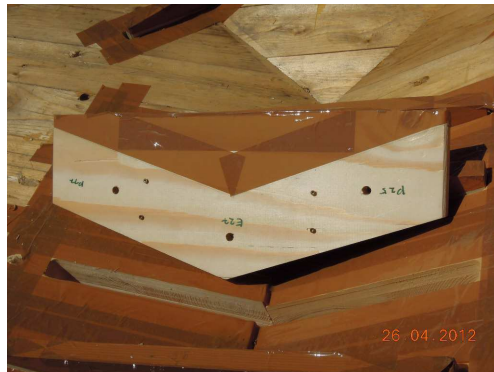
Abb. 7.14 Verbinder mit Entlastungsbohrungen
