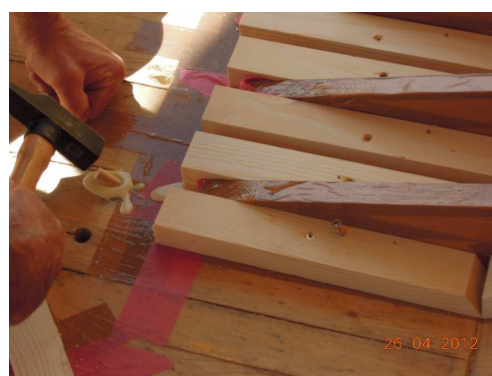
verschließen der Einfüllöffnungen
