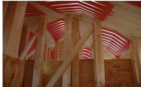
vor der Verklebung des Bauteils
