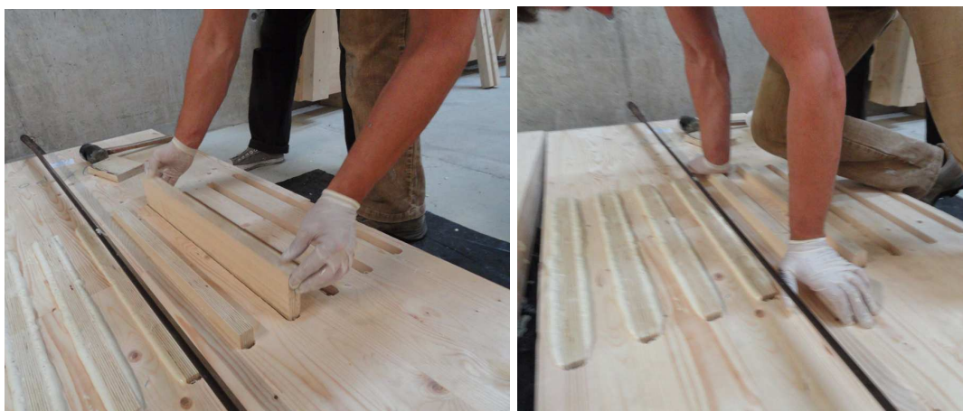
Abb. 5.56 Zentrisches Einbringen des Kerto-Verbinders
