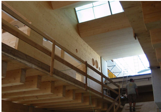
Abb. 2.3 Einsatz von BSP als Wand-, Dach- und Deckenbauteil im Bauzustand links: Bauvorhaben Volksschule Seiersberg, rechts: Bauvorhaben Sonneninsel Seekirchen (Quelle: ZT Büro Koppelhuber, Rottenmann)
