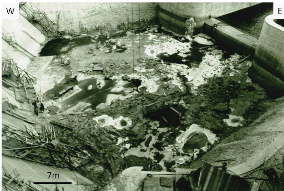
Abb. 3-9 Zustand des Tosbeckens vor der Inbetriebnahme; Quelle: EVN-Bildarchiv
