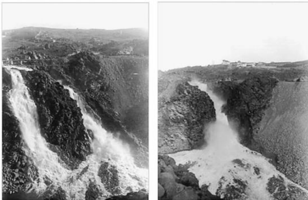
Abb. 2-10 Linkes Bild: Ricobayo Staudamm, Spanien; Zustand der Entlastungsanlage zu Beginn des Überlaufes (Quelle: Iberdrola, Spanien) Rechtes Bild: Zustand der Entlastungsanlage nach dem 19 tätigen Überlauf, deutlich ist die Askolkung bzw. der Materialverlust in diesem Zeitraum zu erkennen; Quelle: Iberdrola, Spanien
