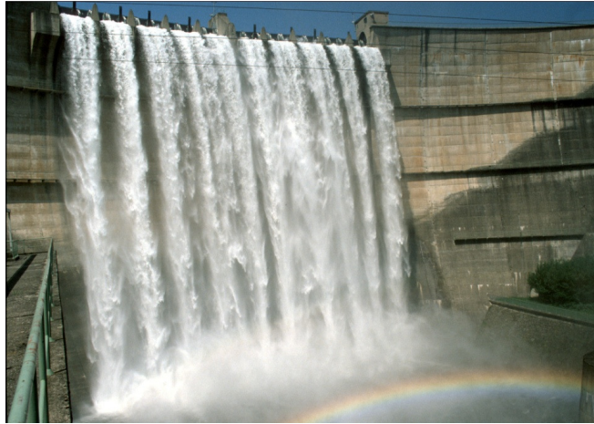
Abb. 3-4 Freier Überfall in das Tosbecken, Höhendifferenz 62 m; Quelle: EVN
