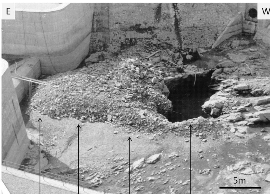
Abb. 3-10 Zustand des Tosbeckens nach dem Überfall am 03.09.1957; Von links nach rechts erkennt man eine Abfolge von: Überwiegend Sand- Überwiegend Kies- Überwiegend Blockwerk; Beschreibung siehe Text; Quelle: EVN-Bildarchiv
