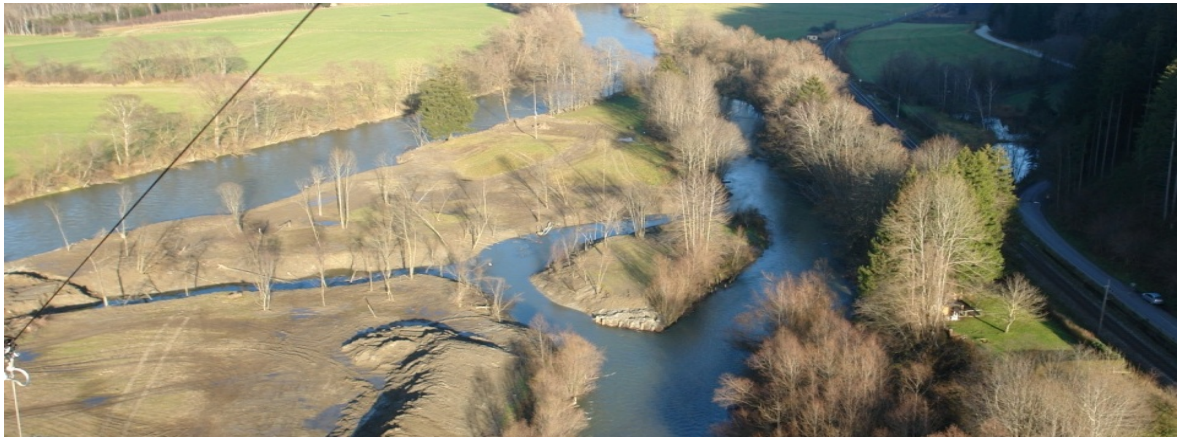
Abb. I-3: Luftaufnahme des Life-Projekts Paltenspitz – weitläufiger Mündungsbereich der Palten in die Enns bei Selzthal – am Ende der Bauarbeiten [Foto Marko, November 2006]
