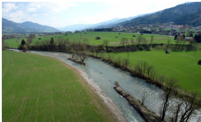
Abb. I-8: Verbesserung der Ufer- und Sohlstruktur im Zuge der Flussaufweitung der Enns bei Haus im Ennstal, flussabwärts fotografiert – zu sehen sind hier drei größere Inseln, sowie Sandbänke und ein ausgedehntes Flachufer links [Foto Marko, April 2008]
