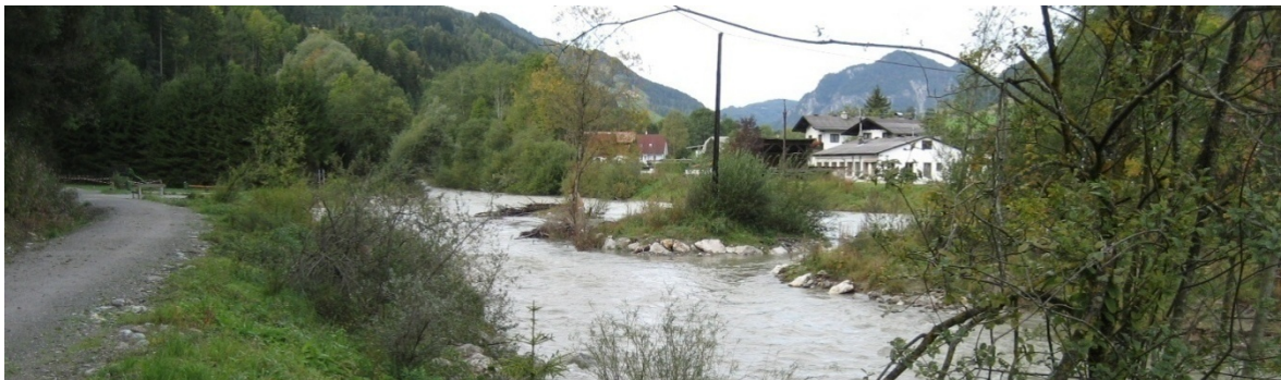
Abb. II-1: Aufweitung der Enns bei Schladming mit mehreren Inseln und Sandbänken mit Bewuchs sowie großzügigen Flachufer- und Buchtbereichen [Foto Marko, September 2007]
