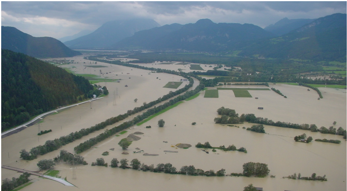
Abb. I-16: Luftaufnahme von der „Überführer“-Brücke südlich von Liezen flussaufwärts am 13. August 2002 – die Enns tritt trotz massiver technischen Regulierungen und Ausbau des Hochwasserschutzes auf HQ 25 auch bei kleineren Hochwasserabflüssen über ihrer Uferdämme, wengleich nicht so massiv und eindrucksvoll wie auf dieser Aufnahme aus dem Jahr 2002 [Foto Marko, August 2002]
