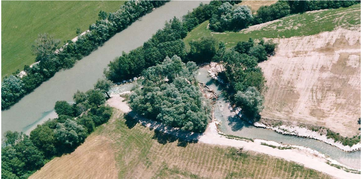
Abb. I-17: Mündungsbereich des Grimmingbaches in die Enns bei Trautenfels – der dynamisch entwickelte Gewässerlauf des Grimmingbaches bietet neuen Lebensraum für wassergebundene Organismen und verbessert den Hochwasserschutz für Trautenfels [Foto Baubezirksleitung Liezen, 2005]
