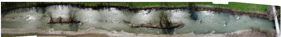
Abb. I-6: Panoramaaufnahme einer Flussaufweitung an der Enns im Rahmen des Hochwasserschutzprojektes in Haus im Ennstal – gut zu erkennen sind hier vor allem auch die vielseitigen Strömungsmuster entlang der Aufweitung [Foto Marko, April 2008]
