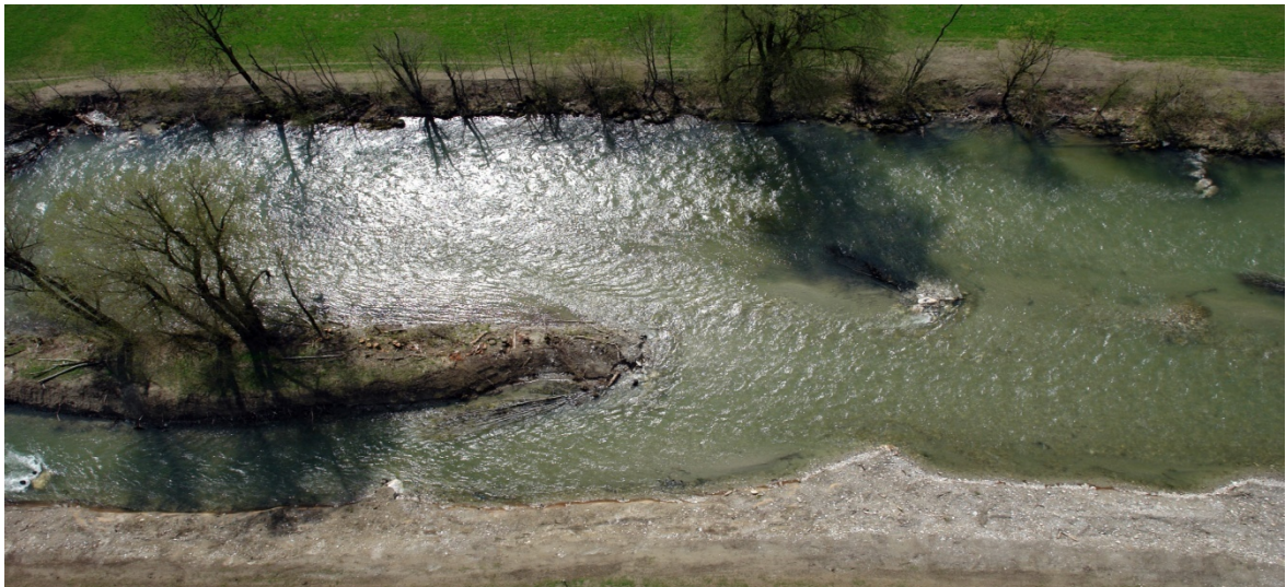
Abb. II-25: Erweitertes Flussbett der Enns im Rahmen der Verbesserung des Hochwasserschutzes im Bereich Haus im Ennstal [Foto Marko, April 2008]
