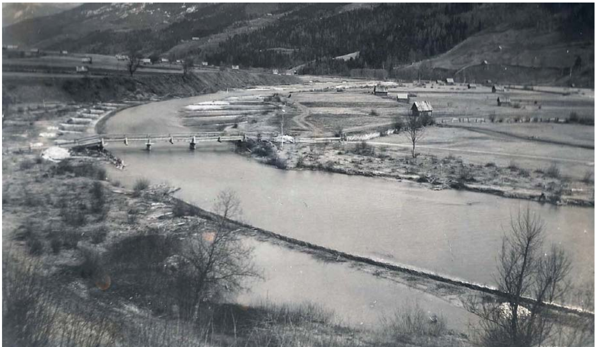
Abb. I-14: Die regulierte Enns im Bereich der Assacher-Brücke im Jahr 1909 – zu sehen sind die technischen Einbauten gemäß den Vorgaben der ministeriellen Kommission [Archiv der Baubezirksleitung Liezen]
