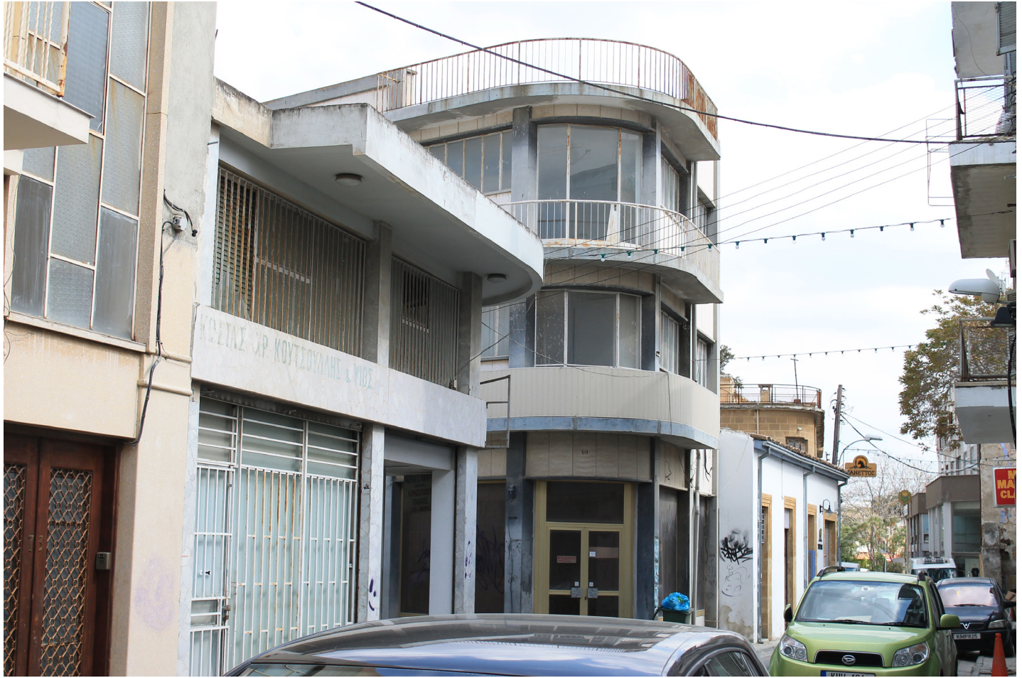
Abbildung 40: Bauten aus den 70/80er
