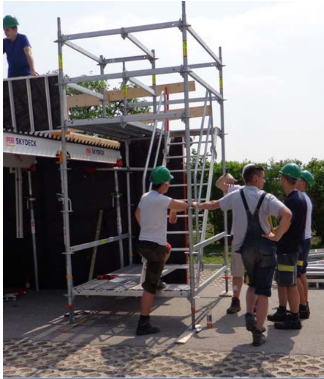
Abbildung 89: Gerüsttreppe 75 mit Belag UDI „PERI UP Rosett Flex“
