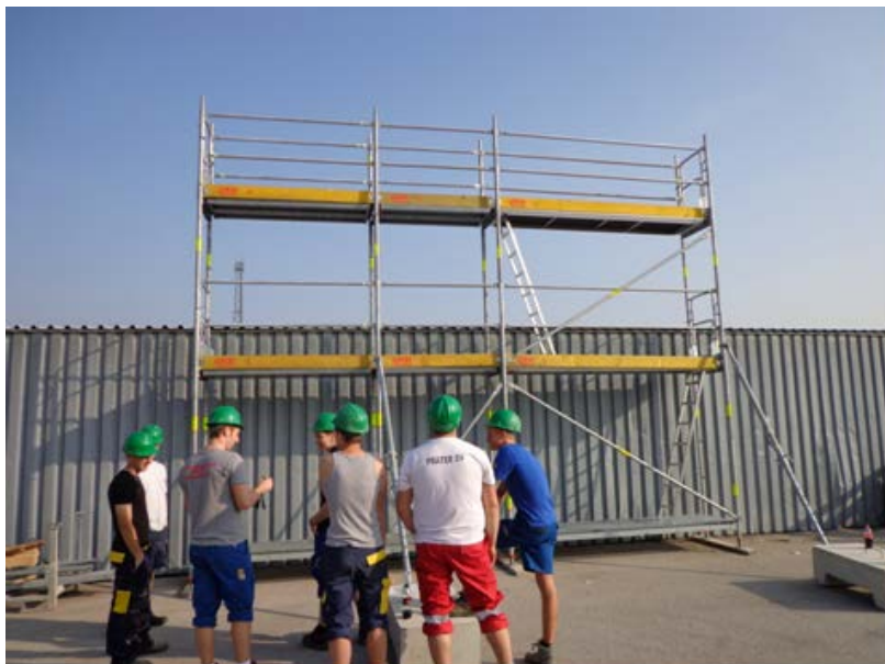
Abbildung 88: Arbeits- und Schutzgerüst mit vorlaufendem Geländer und Belag UDS „PERI UP T 72“
