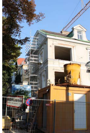
Abbildung 78: Baustelle EFH Wien
