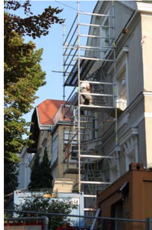
Abbildung 72: Treppenturm beim Umbau des EFH Wien
