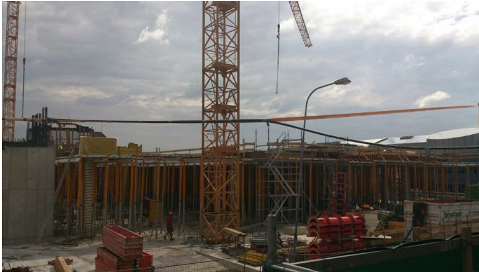
Abbildung 73: Baustelle EKZ Wachau
