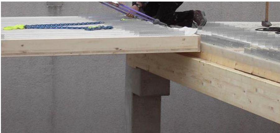
Bild 3.18 Holz-Beton-Verbund Decke und Unterzug beim Kaufhaus Langwies 366
