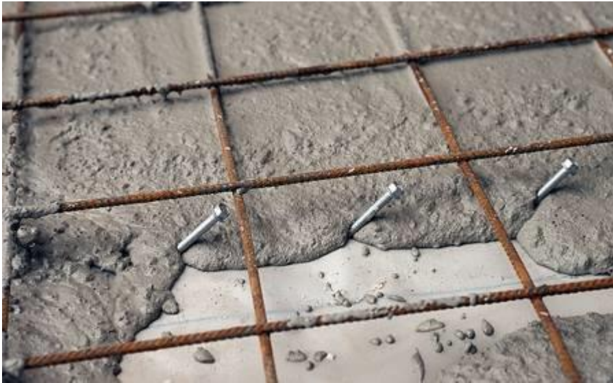
Bild 2.47 Betoniervorgang bei einer HBV-Decke 280
