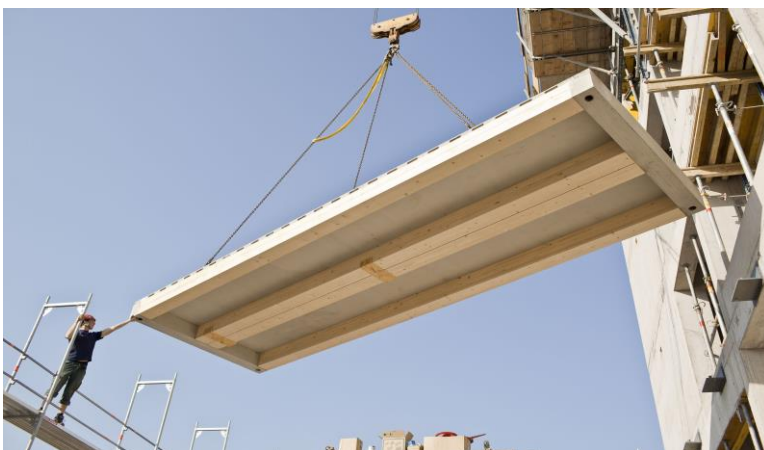
Bild 2.41 Versetzen von HBV-Fertigteilelementen auf der Baustelle 276
