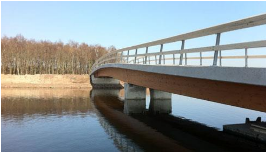
Bild 2.39 Fertiggestellte Holz-Beton-Verbundbrücke im niederländischen Winschoten 275
