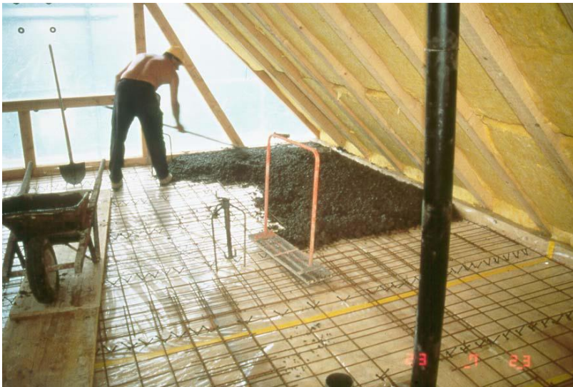
Bild 2.49 Betoniervorgang einer Holz-Beton-Verbunddecke 281
