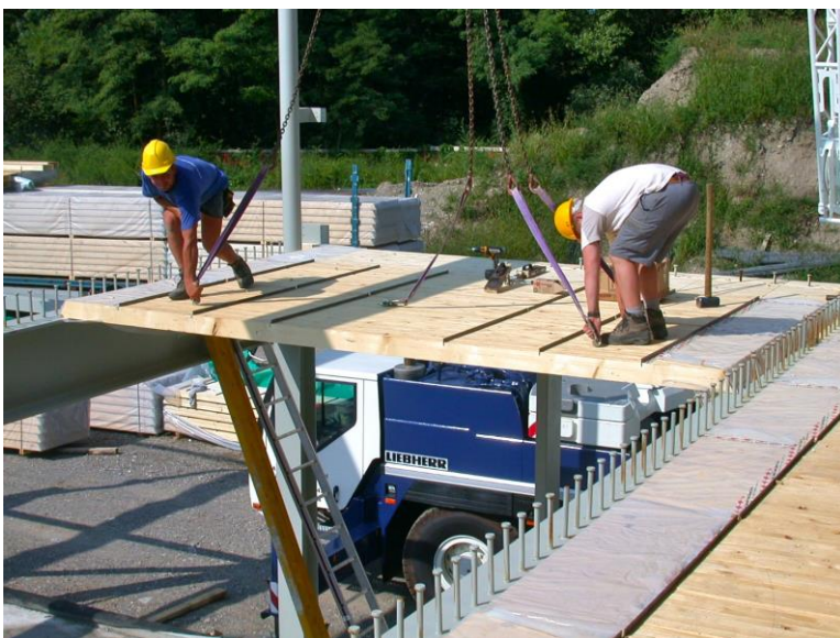
Bild 3.11 Holz-Beton-Stahl-Verbunddecke 343
