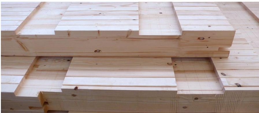
Bild 2.33 Brettstapelelemente mit Schubkerven 217
