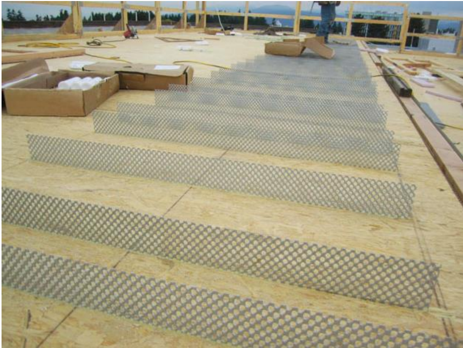
Bild 3.4 Holz-Beton-Verbunddecke mit HBV-Schubverbindern 321
