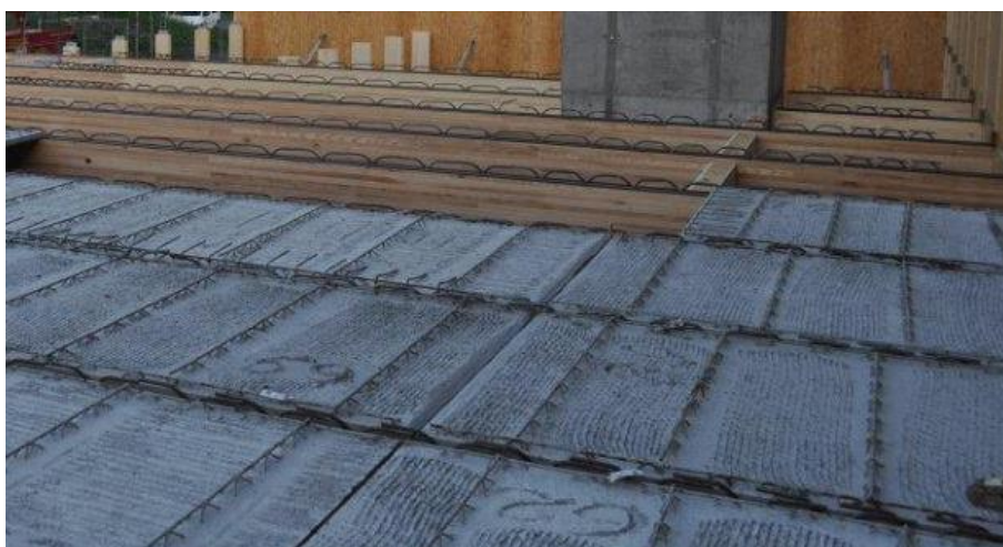
Bild 3.8 HBV-Decke des Herstellers n'H 337
