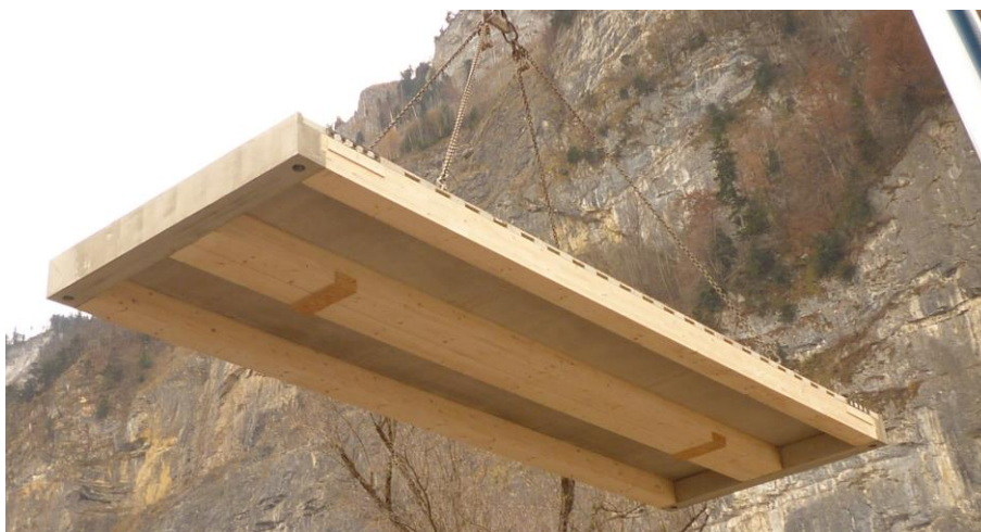
Bild 3.14 Holz-Beton-Verbund Rippendeckenelemente beim Life Cycle Tower One in Dornbirn 353
