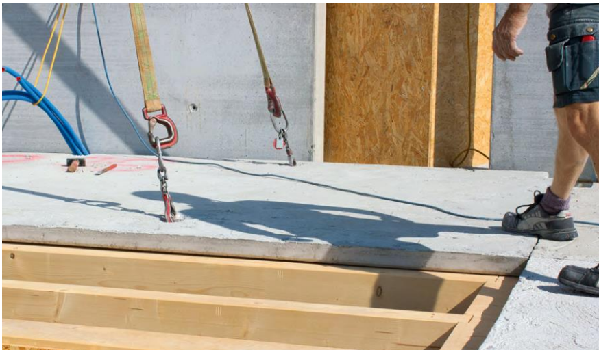
Bild 3.3 Versetzen von Betonfertigteilen des Herstellers Häring 315
