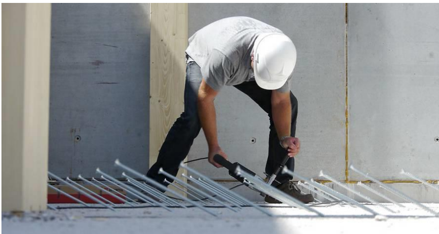
Bild 2.44 Herstellen einer HBV-Decke mit Herstellungsmethode B 278
