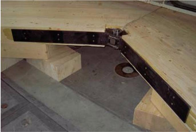
Abb. 2.45 Beispiel eines vorgefertigten biegesteifen Rahmenecks mit Lochblechen [19]
