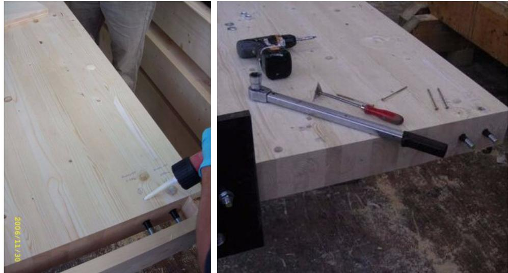
Abb. 2.39 Während und nach dem Verpressen der Gewindestangen [20]
