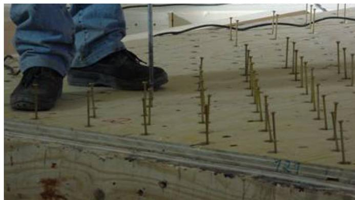
Abb. 2.35 flächenhafte Verklebung mit Hilfe der Schraubenpressverklebung [19]
