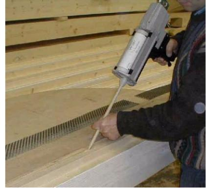
Abb. 2.46 Herstellen der Fuge im Holz mit einer Handkreissäge und Befüllen mit Klebstoff [25]
