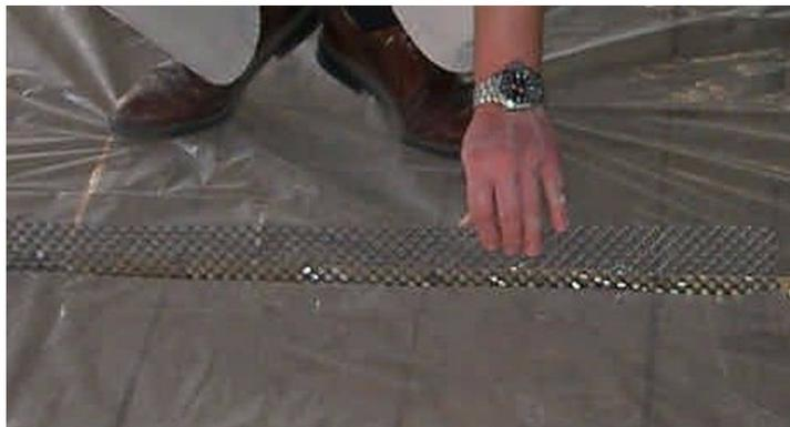
Abb. 2.47 Eindrücken des Lochblechs in die mit Klebstoff gefüllte Fuge von Hand [25]
