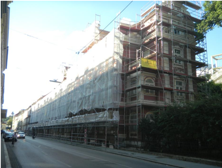
Bild 4.49 Sanierungsarbeiten an der Fassade
