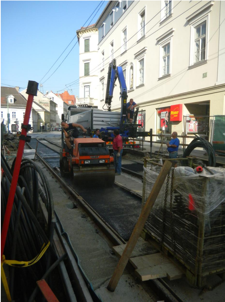
Bild 4.30 Asphaltarbeiten Kreuzung Annenstrasse - Vorbeckgasse
