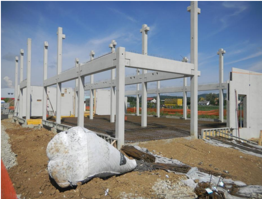
Bild 4.18 Lagerhalle in Fertigteilbauweise
