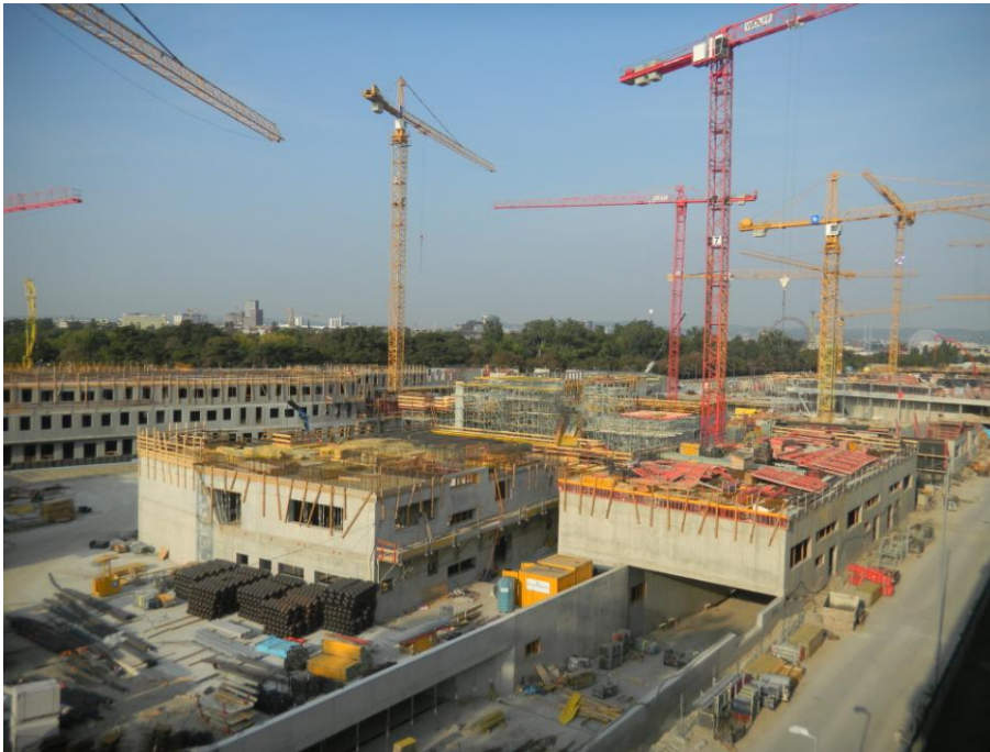
Bild 4.70 Stand bei den Bauarbeiten
