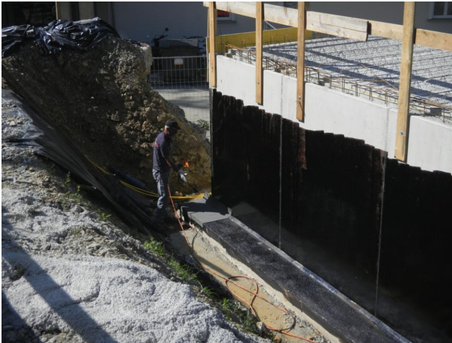
Bild 4.23 Verlegung von Bitumenbahnen
