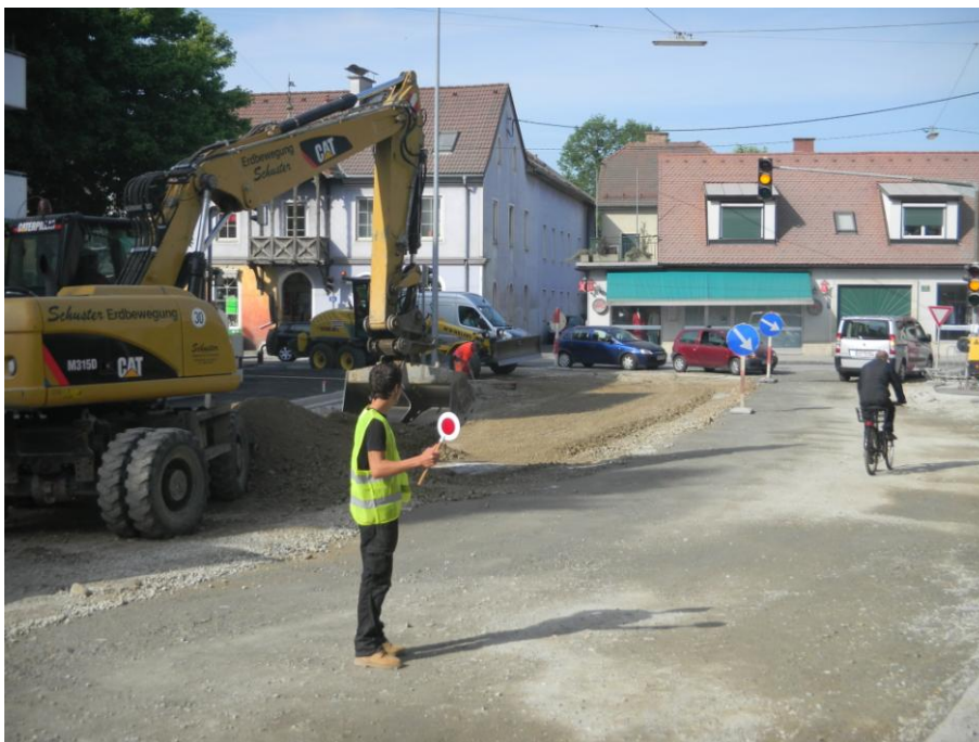
Bild 4.14 Herstellung des Straßenplanums
