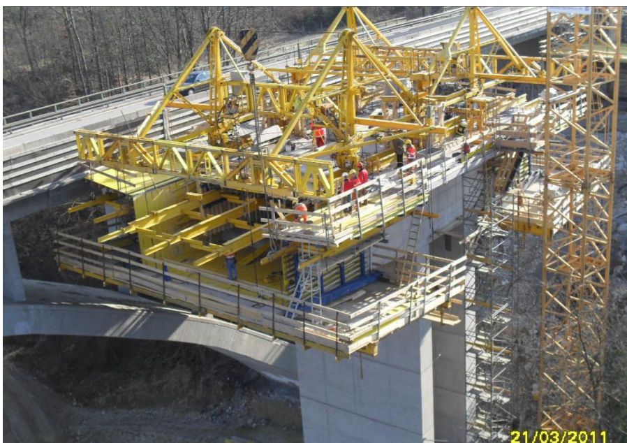
Bild 4.64 Freivorbau der neuen Traunbrücke (Fahrtrichtung Salzburg) und Bestand (Bogenbrücke, Fahrtrichtung Linz) 54
