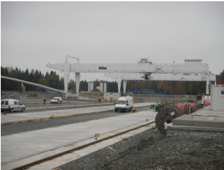
Bild 4.77 Baulos Kat 2, Portalkrane über den Schächten
