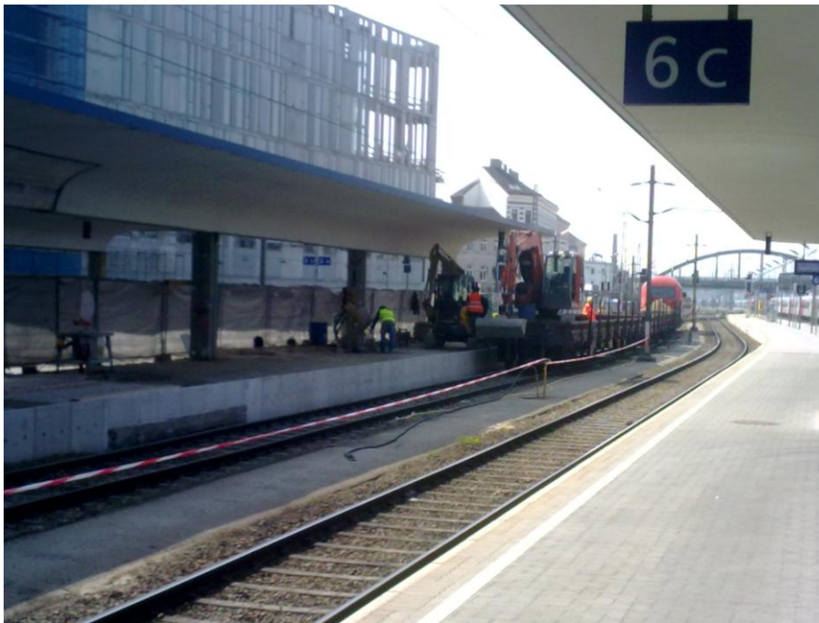
Bild 4.5 Sanierung der Bahnsteige
