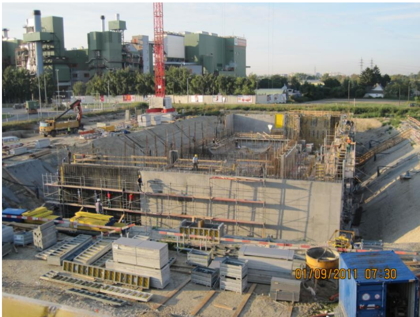
Bild 4.46 Abfalllogistikzentrum Pfaffenuh, Rohbauarbeiten 42
