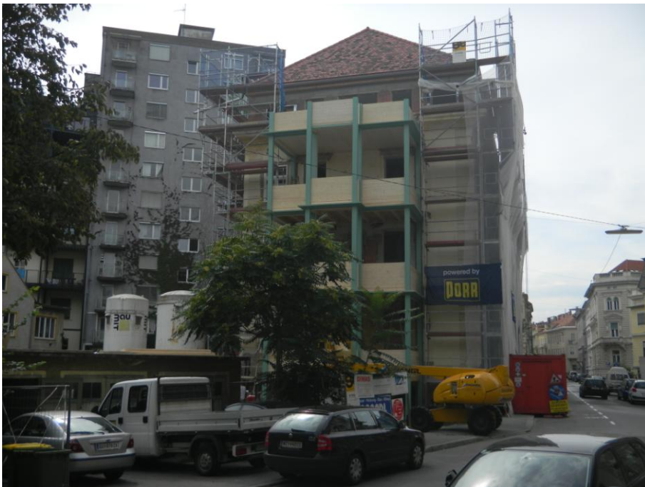
Bild 4.53 Sanierung, Um- und Neubau eines Altbaus
