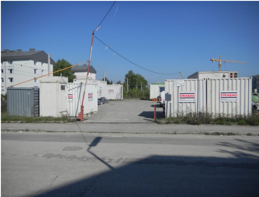
Bild 4.59 Baucontainer für die Bauleitung, Materialdepot Aufenthaltsräume, Sanitärcontainer, etc.
