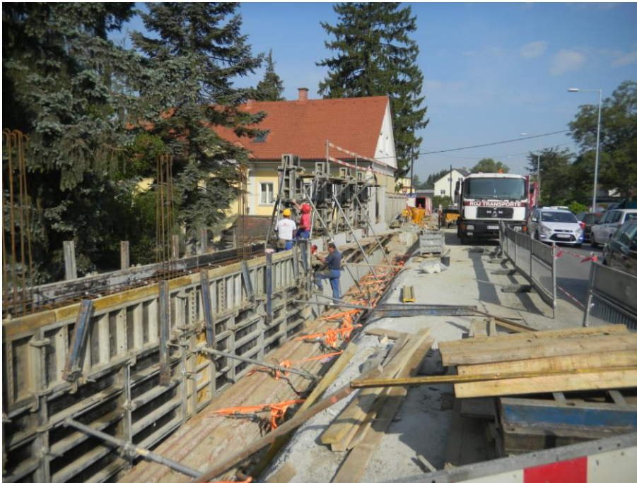
Bild 4.17 Einschalen und Bewehren einer Stützmauer
