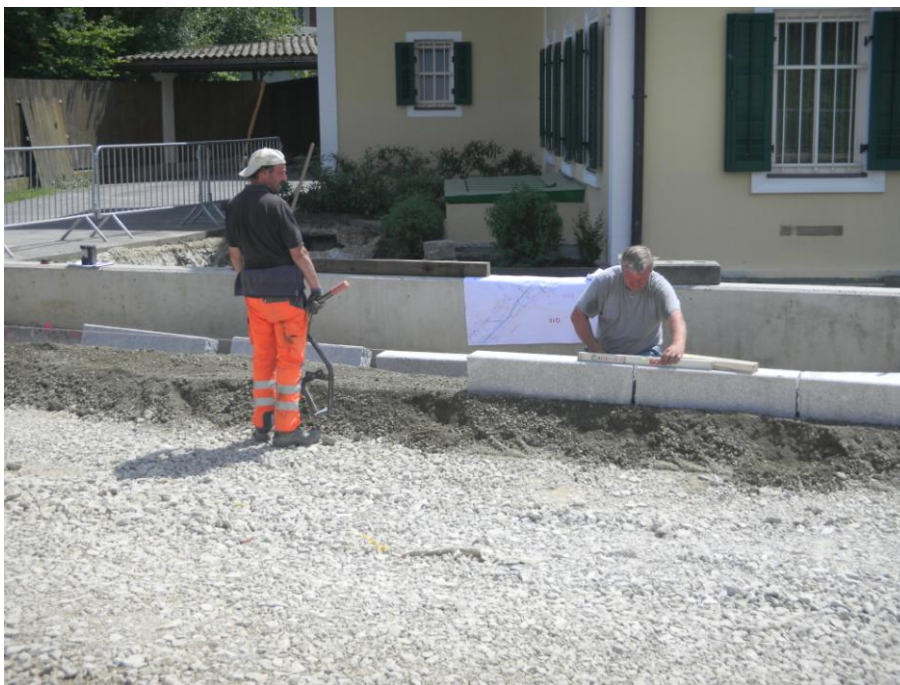
Bild 4.15 Errichten der Bordsteinkante
