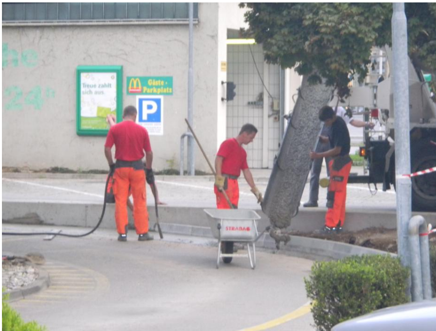
Bild 4.58 Betonieren der zusätzlichen Fahrfläche
