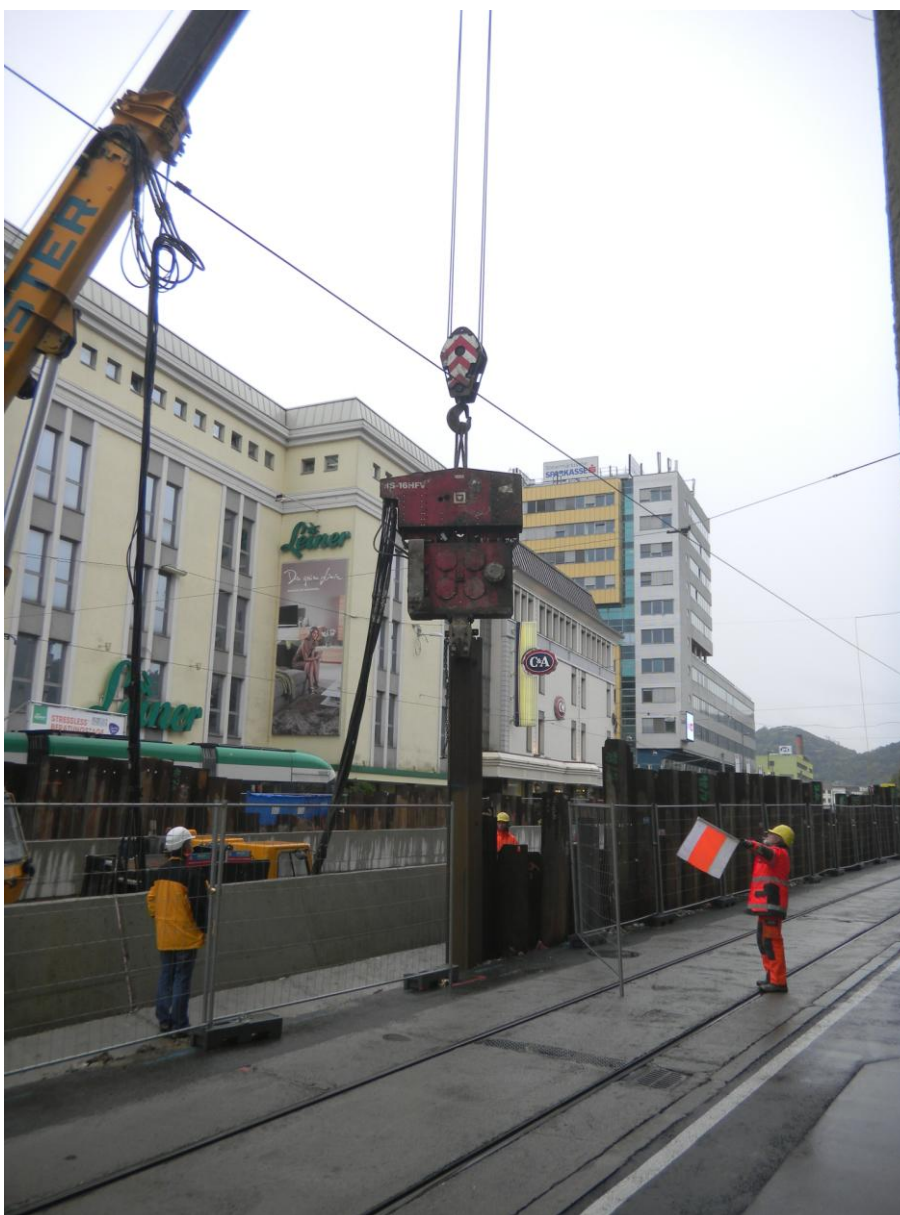
Bild 4.75 Rückbau der Spundbohlen
