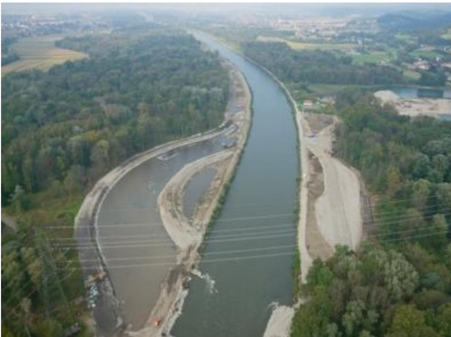
Bild 4.8 Baustelle KW Gössendorf und Kalsdorf 19
