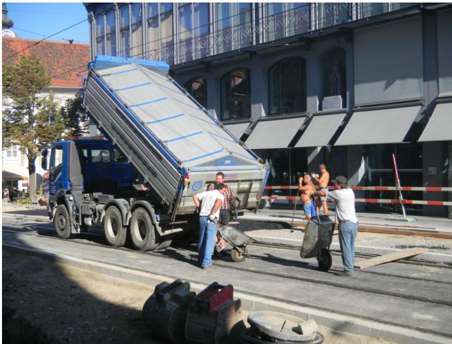
Bild 4.28 Asphaltarbeiten vor dem Kunsthaus
