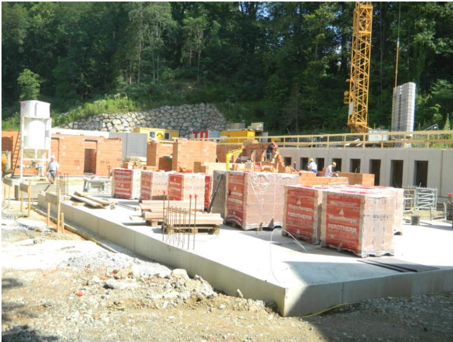
Bild 4.22 Errichtung eines Ziegelmauerwerkes
