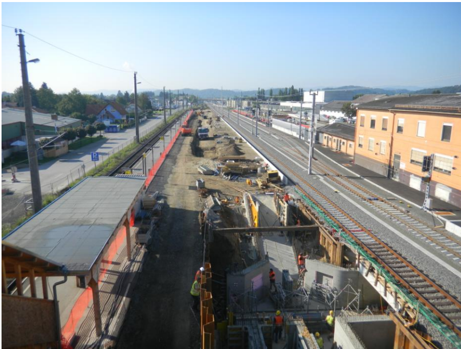
Bild 4.33 Bahnhof Leibnitz, Blick Richtung Süden
