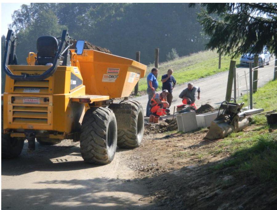
Bild 4.63 Bauarbeiter bei der Rohrverlegung
