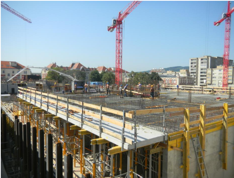
Bild 4.37 Geriatriezentrum Baumgarten, Stahlbetonarbeiten
