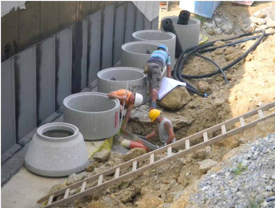
Bild 4.24 Arbeiten am Sickerschacht
