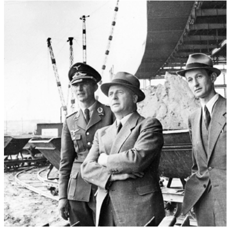
8 Ernst Sagebiel auf der Baustelle des Flughafens Tempelhof mit einem Mitarbeiter und einem Offizier
