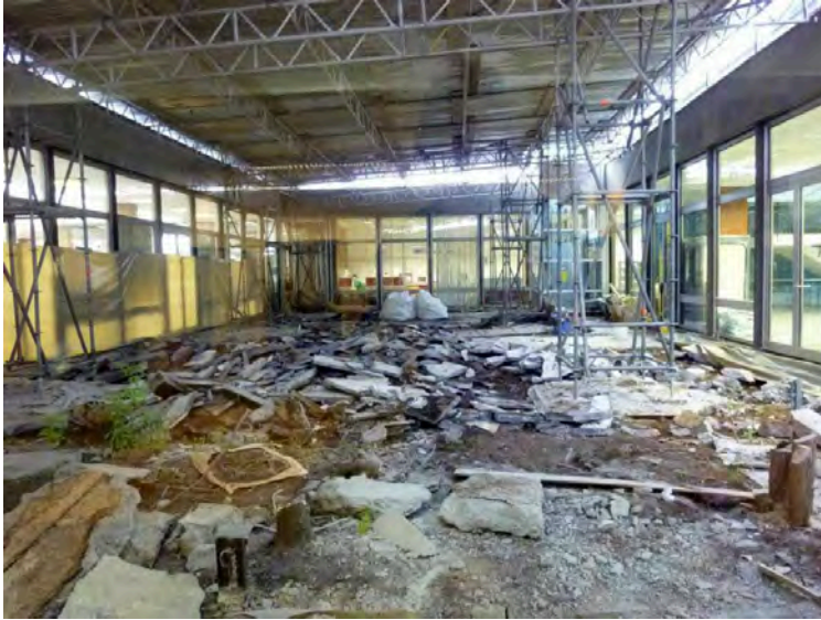
9/10 Sanierungsarbeiten nach einem Wassereintrich 2011
