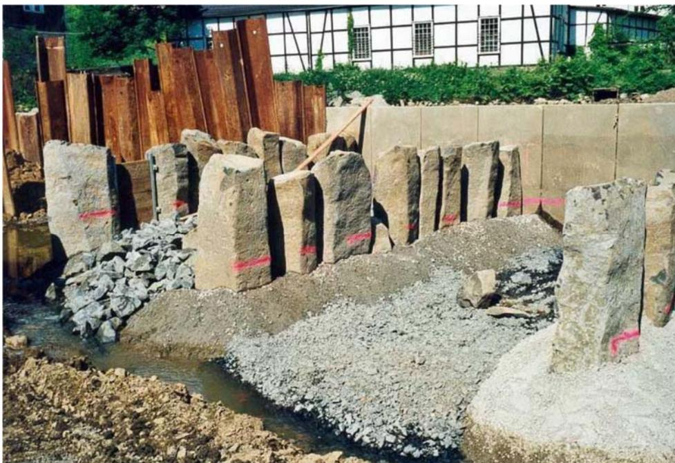
Abbildung 24: Raugerinne mit Beckenstruktur im Bau- Riegel aus großen Wasserbausteinen, raue Sohle mit filterstabilem Aufbau (Betzdorf/Sieg, Rheinland-Pfalz) ([ 3 ], S. A-35)
