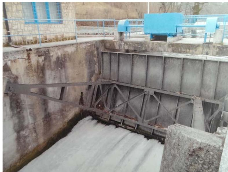
*Abbildung 6: Hochwasserentlastung mit der Segmentklappe*
