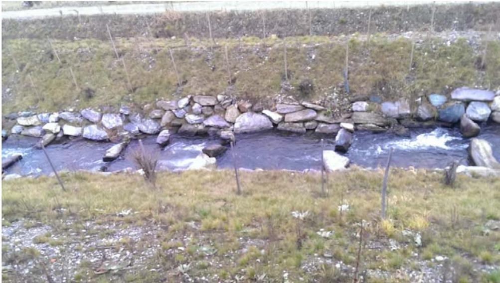
*Abbildung 53: Natürlicher Beckenpass WKW Gössendorf - in der Mitte*
