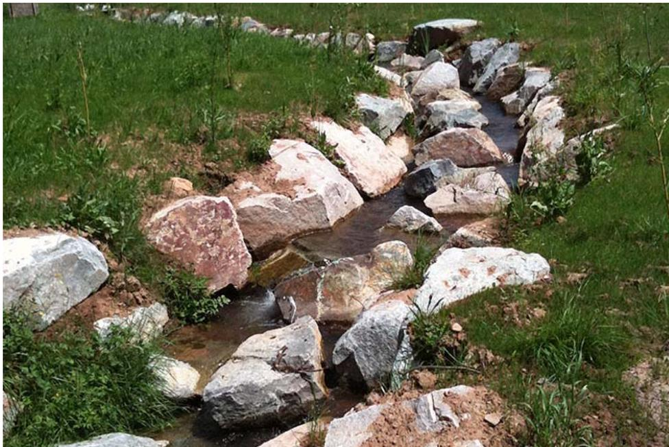
*Abbildung 27: Raugerinne mit Störsteinen bei der Wasserkraftanlage in Reichenbach (Bauunternehmen Himmelsbach) ([ 4 ], S. 12)*
