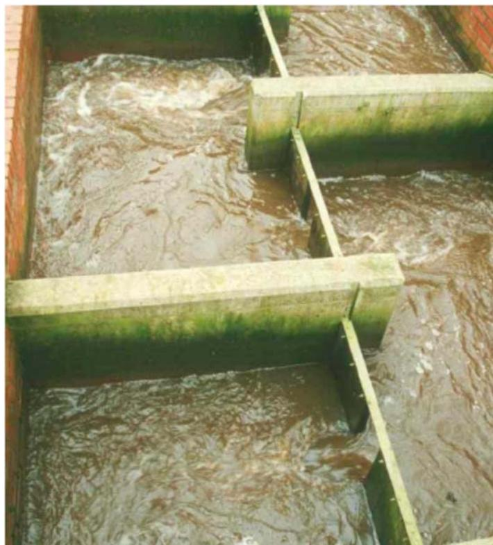
Abbildung 29: Kompakte Ausführung eines Schlitzpass ähnlichen Beckenpasses (Heiligenrode, Brandenburg), ([ 3 ], S. A-43)
