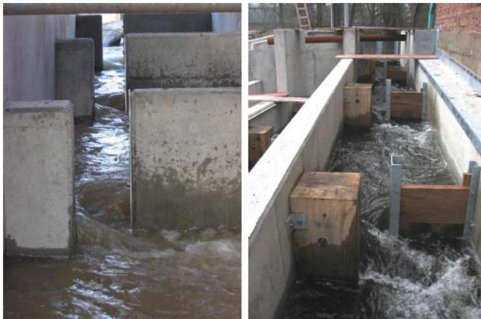
Abbildung 28: Links: Vertical-Slot-Pass Klinkelsche Mühle in Gießen (Hessen), Rechts: Vertical-Slot-Pass Hohmühle (Hessen), ([ 3 ], S. A-42)
