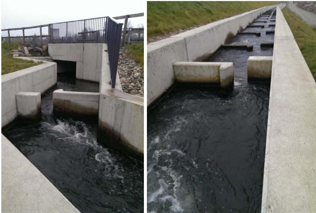
Abbildung 50: Schlitzpass WKW Gössendorf - Anschluss oben
