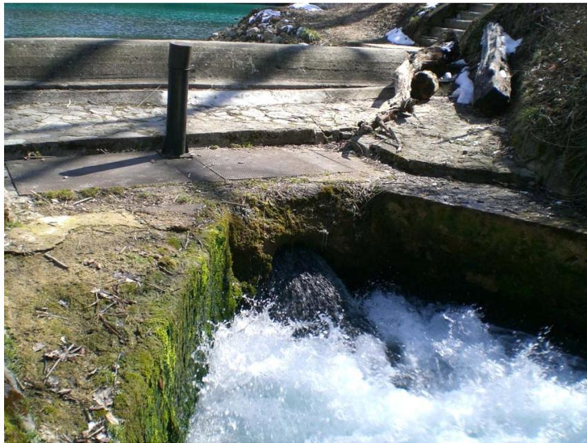
*Abbildung 7: Der Rohrdurchlass  $D= 1000$  mm*
