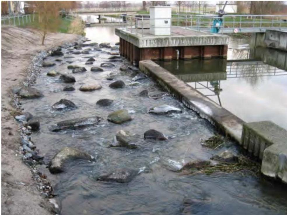
*Abbildung 26: Sohlgleite mit Störsteinen, Wehr Bad Sülze/Recknitz ([ 4 ], S. 12)*
