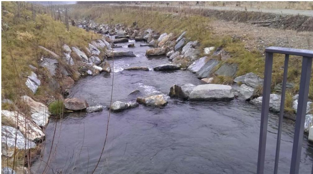
Abbildung 52: *Natürlicher Beckenpass WKW Gössendorf – Übergang vom Schlitzpass*
