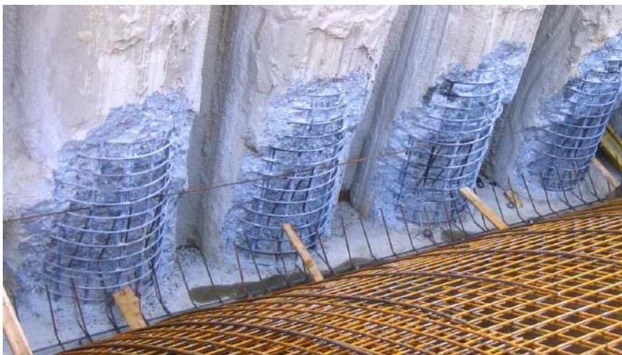
Bild 3.14 Freilegung der Bohrpfahlbewehrung am Beispiel des Tunnels Perschling, Deckelbauweise Ost 78
