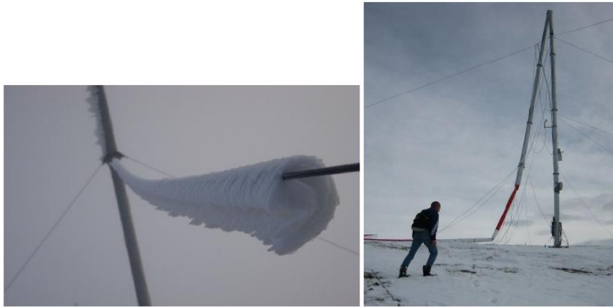
Abbildung 18: Links: Zylinderförmiger Eisansatz an Abspannungen eines Messmasts. Rechts: Wegen Vereisung eingestürzter Messmast (beides Schwyberg, Schweiz), (Cattin, 2008)
