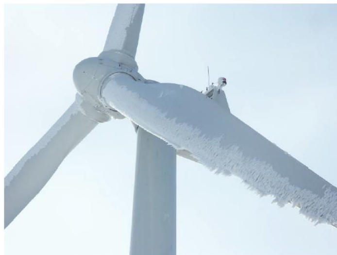
Abbildung 7: Vereisung an Rotorblättern (Baring-Gould et al., 2009, © Kent Larsson)
