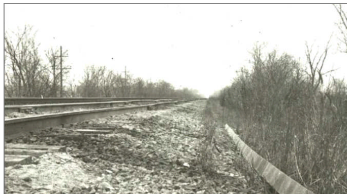
Abbildung 22 Schotterzermahlung durch Schwellen (Skriptum TU Graz, Veit 2010)
