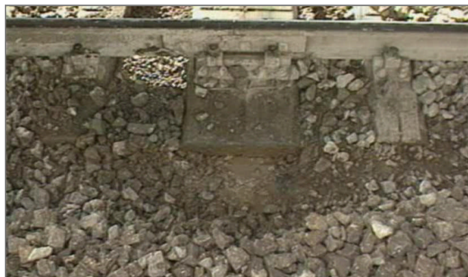
Abbildung 20 Spritzstoß unter Schwellen (Skriptum TU Graz, Veit 2010)
