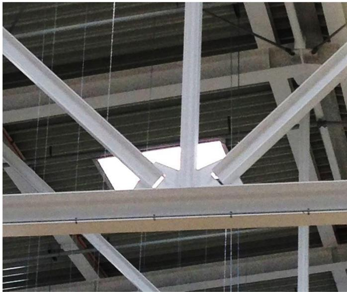
Abbildung 2 – Fachwerkknoten mit beidseits in das Knotenblech eingeschlitzten Diagonalen aus I-Profilen, Verkaufshalle des OBI Bau- und Heimwerkermarktes in 8051 Graz Nord
