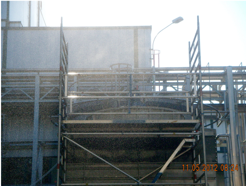
Abbildung 6-3 Tröpfchenaustrag ohne Filtervlies
