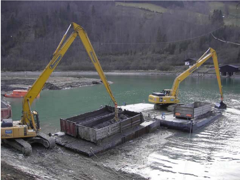
Abbildung 1: Baggerungen im Stausee Schönau der Ennskraftwerke AG 2
