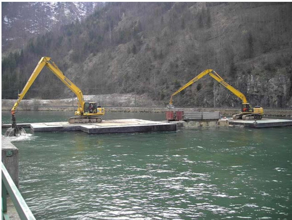
Abbildung 2: Baggerungen im Stausee Schönau der Ennskraftwerke AG 3
