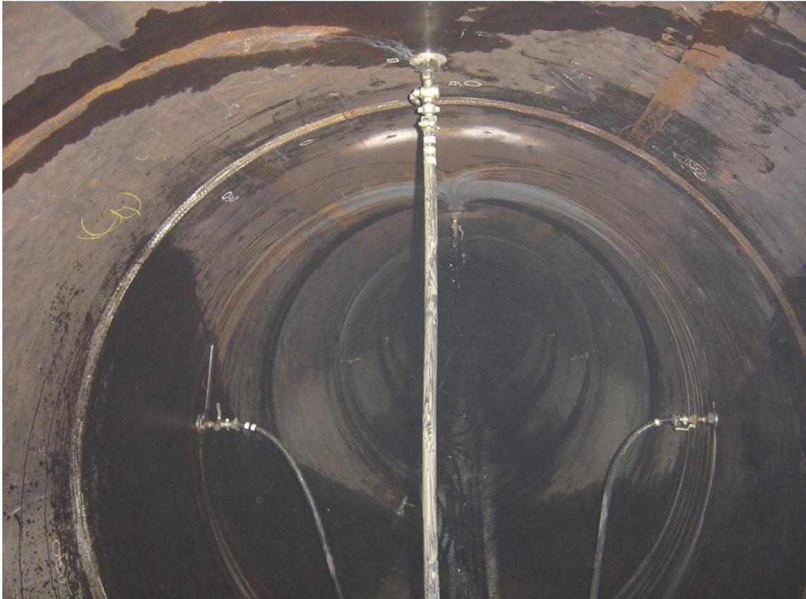
Abbildung 10: Arbeitsschritt Injektion, Injektionsnippel [11]
