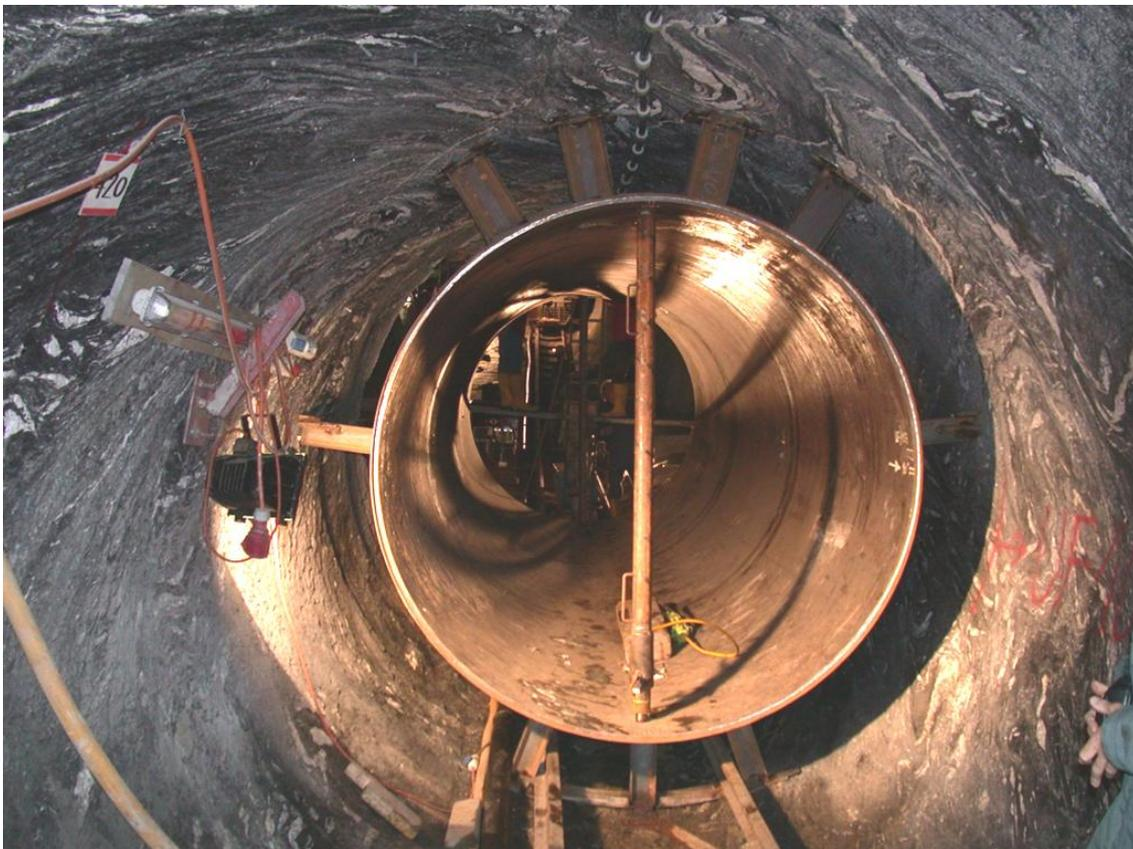
Abbildung 4: Verlegung der Stahlpanzerung im Druckschacht, Schachtvortrieb mittels TBM [11]
