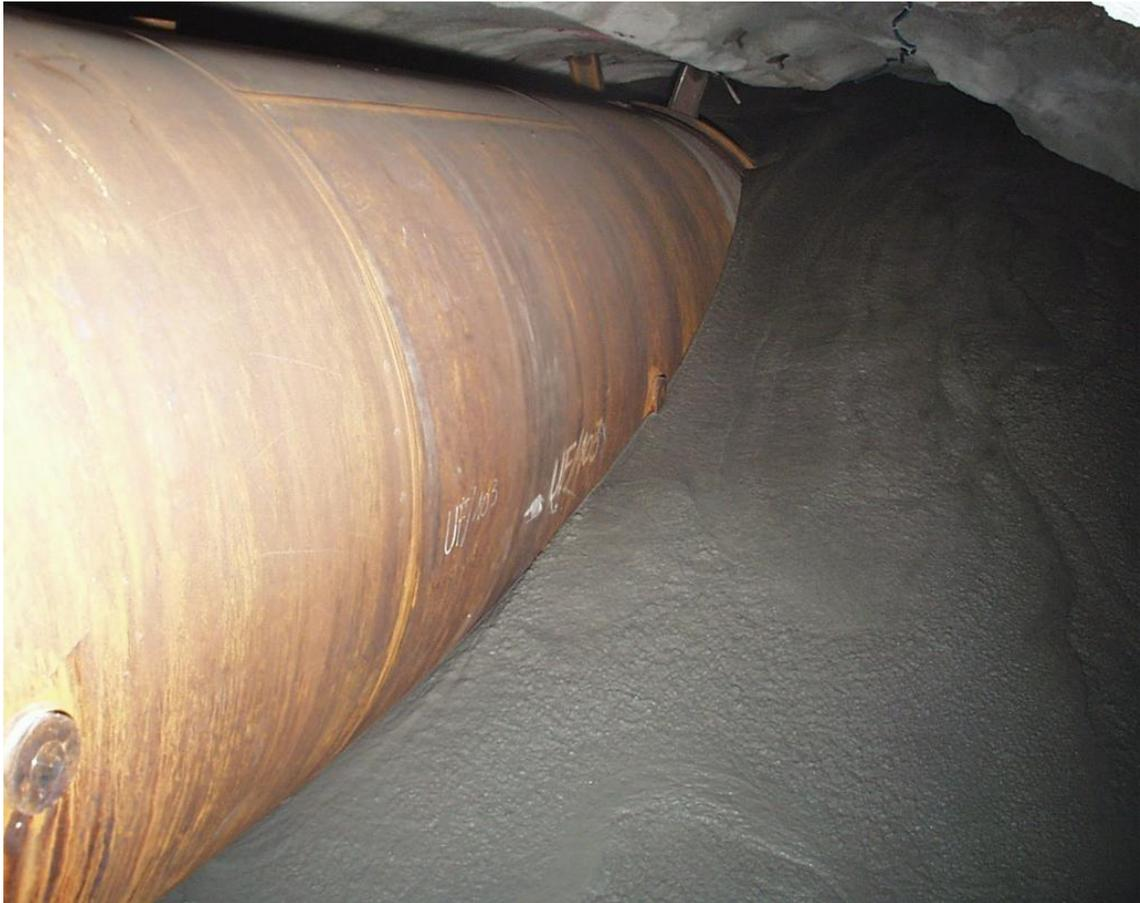
Abbildung 5: Ausbetonierung des Hohlraumes zwischen Panzerung und Gebirgsmantel [11]
