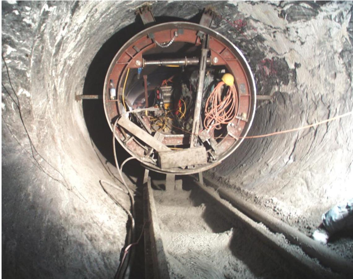
Abbildung 329: Einbau der Panzerung im Ausbruchquerschnitt [11]
