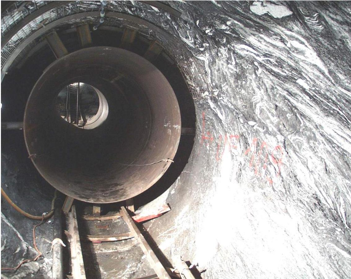
Abbildung 3: Verlegung der Stahlpanzerung im Druckschacht, Schachtvortrieb mittels TBM [11]
