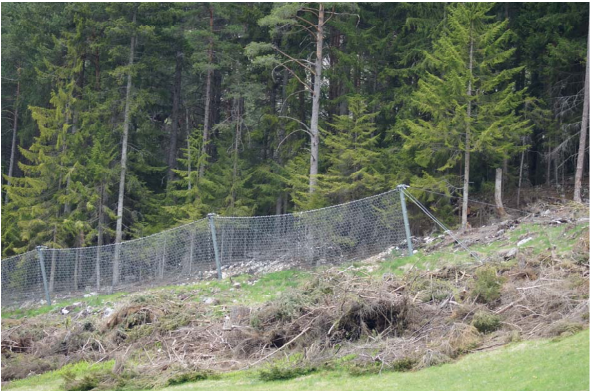
Foto 15: Bereits errichtete Steinschlagschutznetze im Bereich des Bergfußes
