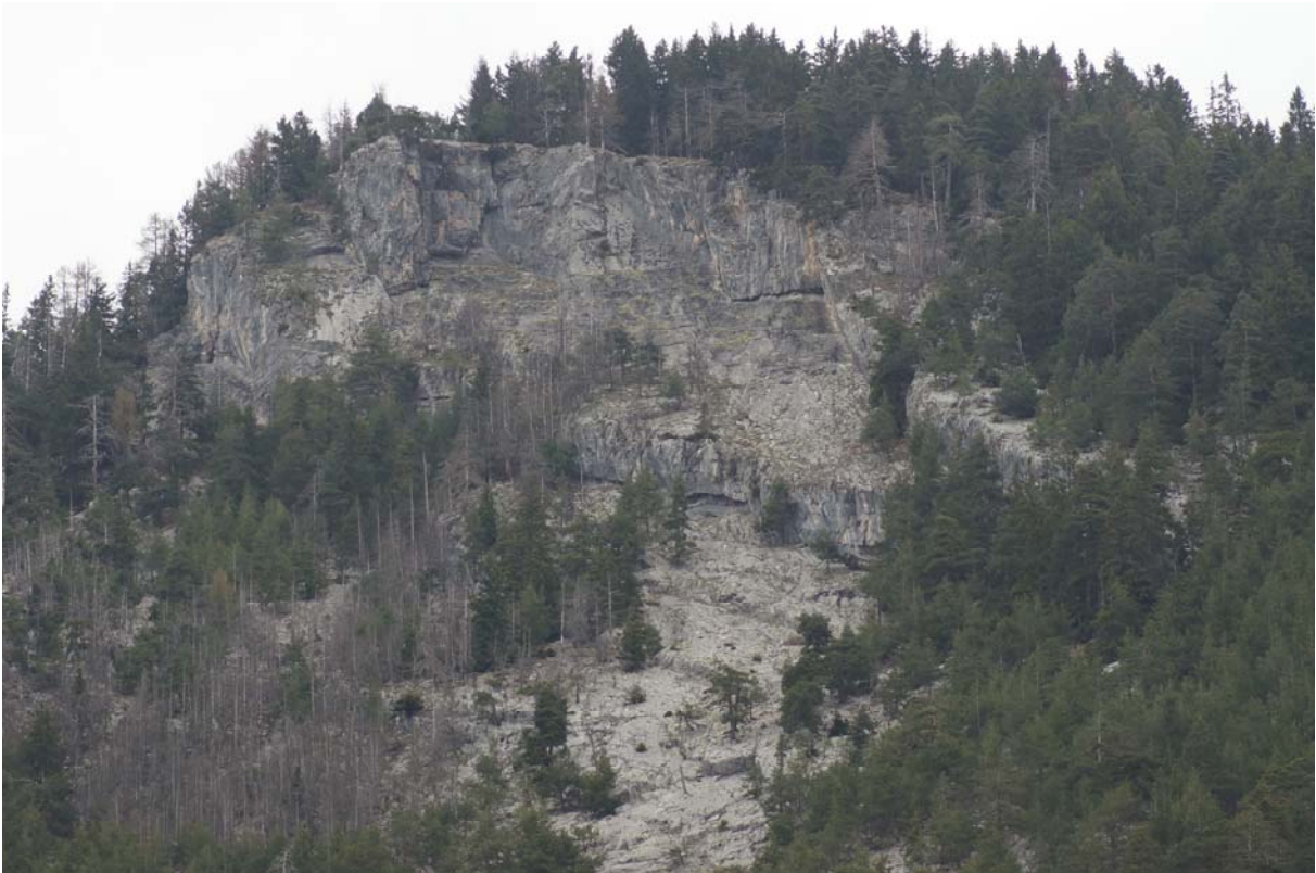
Foto 5: Blick auf den Gipfel und oberen Mittelbereich, anhand dieses Fotos konnten Ebenen im Laserscan Modell eingebaut werden
