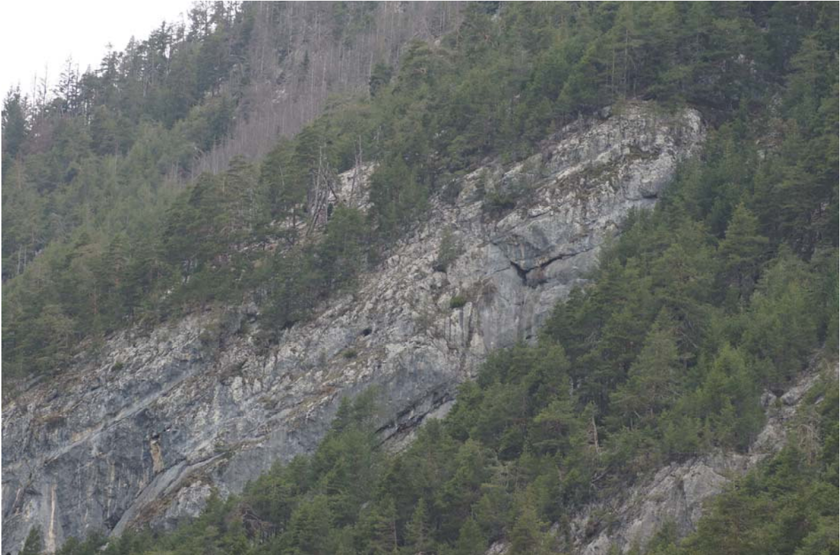
Foto 14: Cliff_Part_4, im oberen Bereich des Aufschlusses ist der Wettersteinkalk zerlegter als in den tiefer liegenden Bereichen, Hauptursache dürfte die von der Oberfläche angreifende Erosion sein
