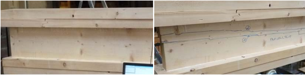
Abb. 4.13 Vorschädigung und Bruch des Trägers T6_19 (Trockenrisse)
