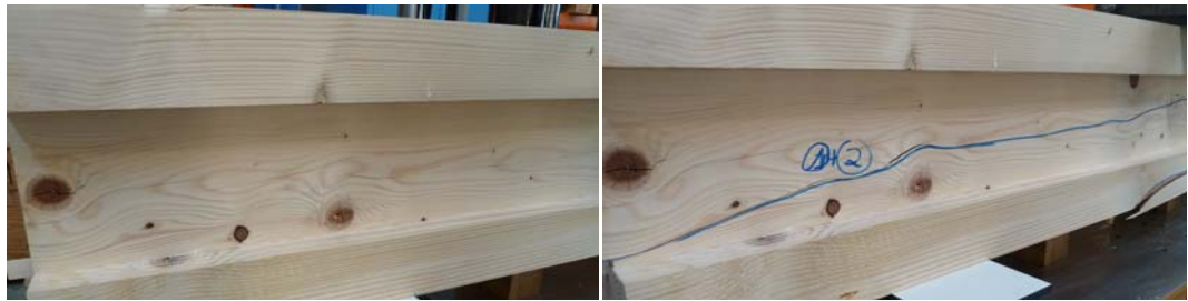
Abb. 4.2 Vorschädigung und Bruch des Trägers T2_21 (Trockenrisse)
