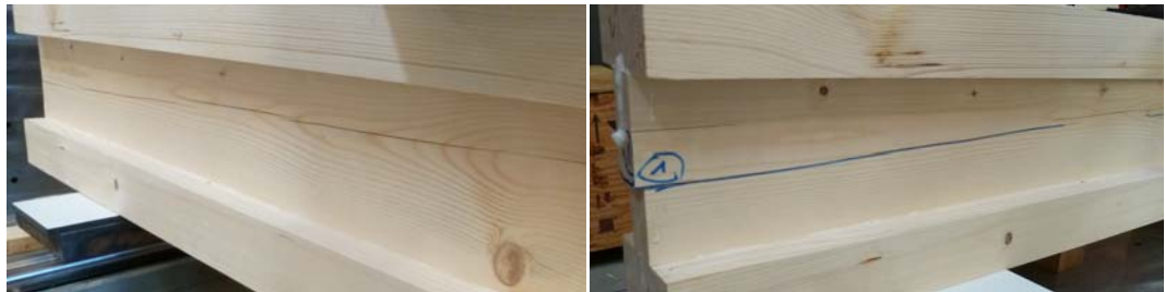
Abb. 4.3 Vorschädigung und Bruch des Trägers T2_22 (Trockenrisse)
