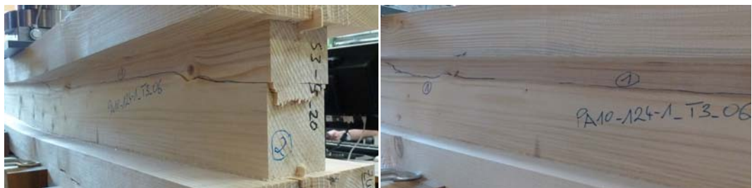
Abb. 4.5 Vorschädigung und Bruch des Trägers T3_06 (Trockenrisse)
