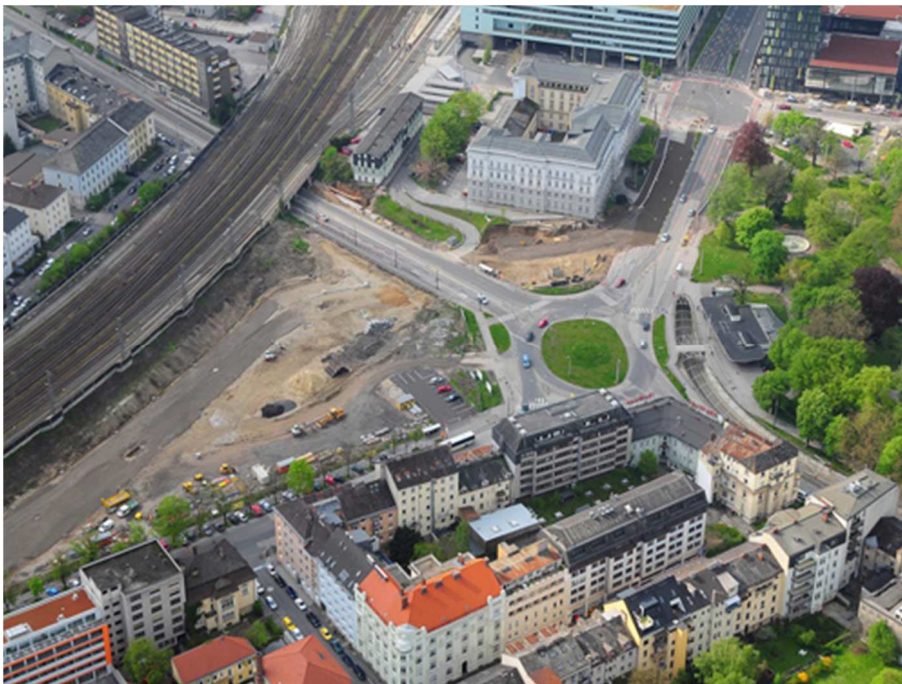
Abbildung 5.11 Luftaufnahme Baufeld Musiktheater Linz 229
