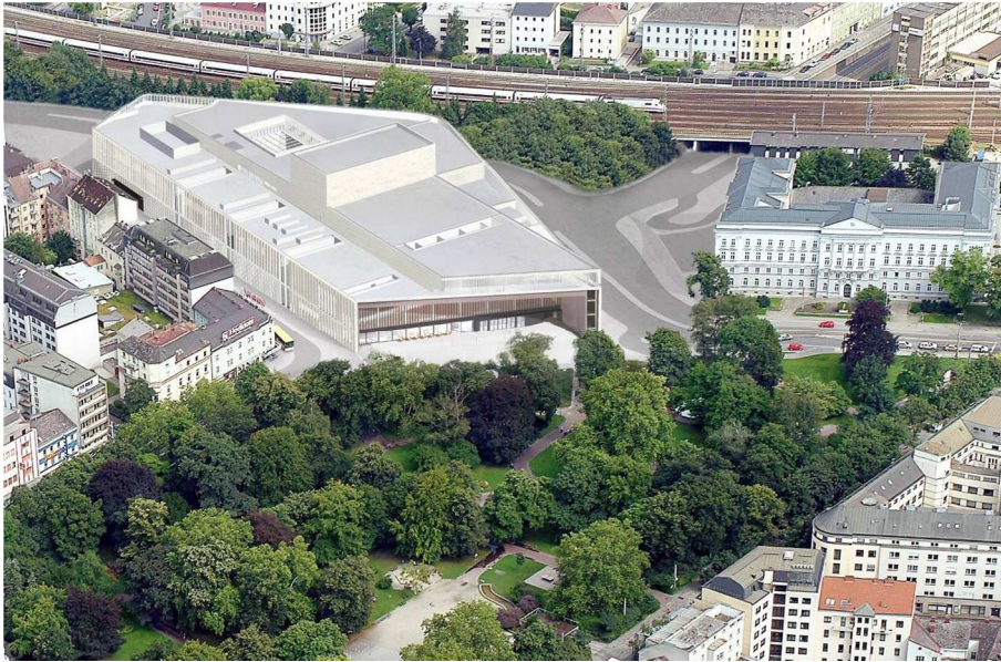
Abbildung 5.7 Blick von oben auf das Musiktheater Linz [Copyright: Terry Pawson Architects] 217
