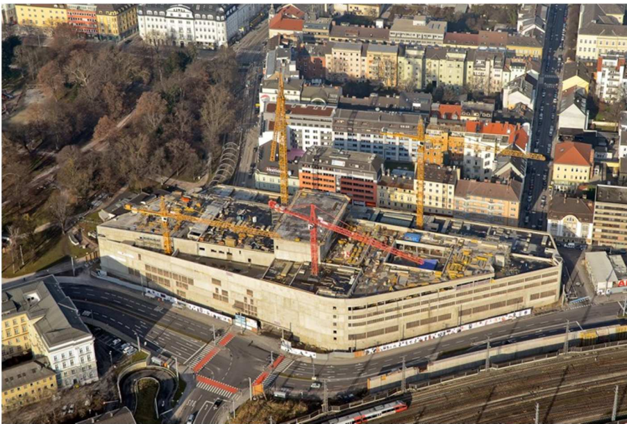
Abbildung 5.23 Luftaufnahme nach Beendigung der Rohbauarbeiten 282
