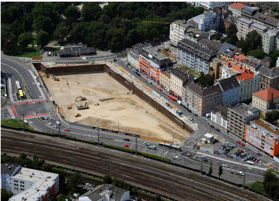
Abbildung 5.16 Ausgangssituation vor dem Beginn der Rohbauarbeiten 254
