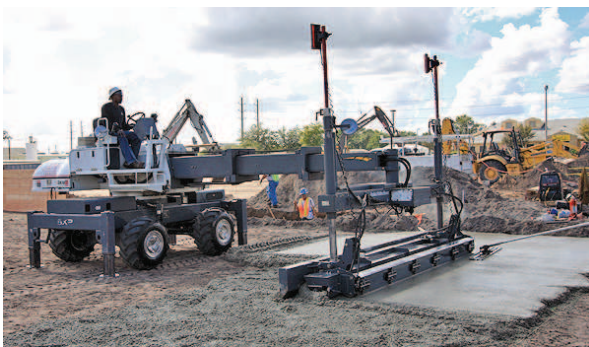
(a) lasergesteuerter Flächenfertiger
