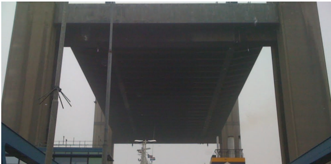
Abbildung 5.5: Unterseite des beweglichen Hubgliedes [36]
