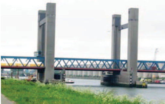
(a) Caland-Brücke geschlossen [2]
