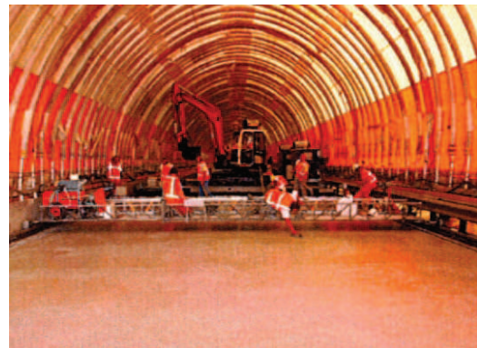
Abbildung 5.24: Einbau mit Rüttelbohle [42]
