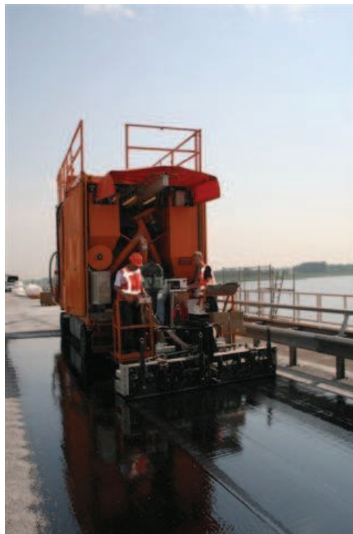
Abbildung 5.26: Aufbringung der Verschleißschicht [44]
