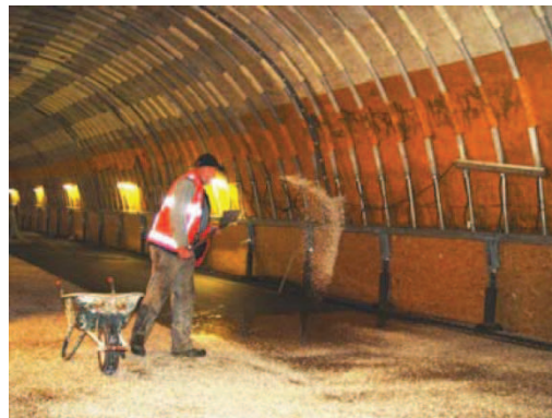
Abbildung 5.7: Aufbringen des Epoxidharzes [38]
