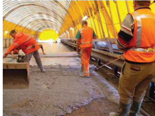
Abbildung 5.9: Einbringen des Betons [2]
