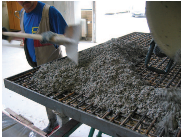
Abbildung 6.2: Bewehrungslage und Einbringen des HPC [1]
