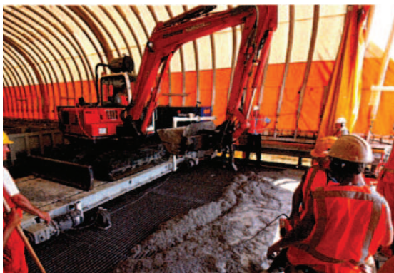
Abbildung 5.23: Einbringen des Frischbetons [42]
