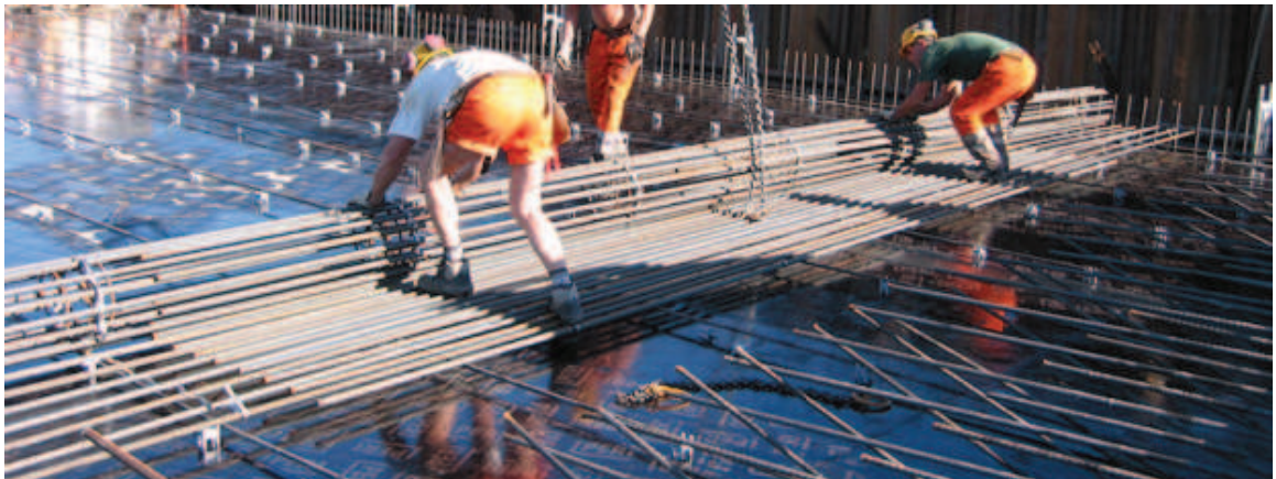
Abbildung 4.9: Verlegung einer vorgefertigten Rollmatten-Bewehrung [31]
