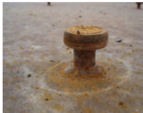
(b) Detail des Kopfbolzendübel
