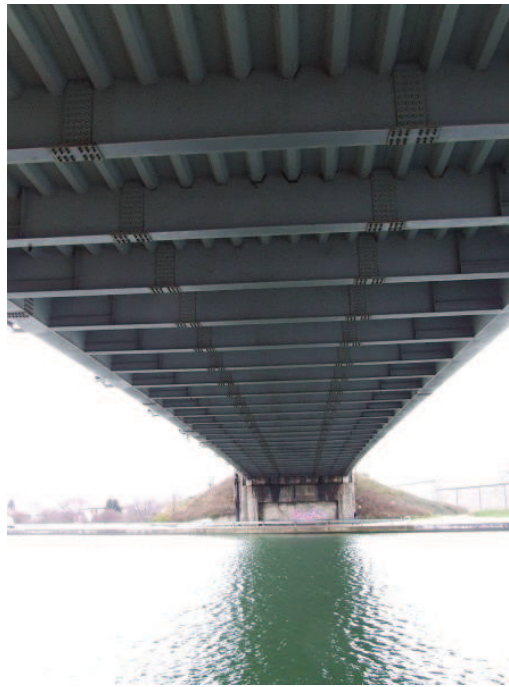
Abbildung 5.29: Untersicht auf die Brücke in Illzach [47]
