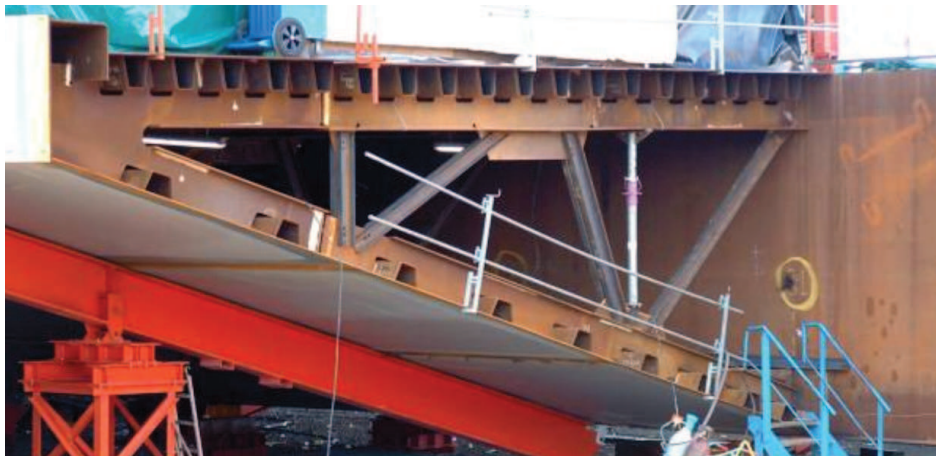
Abbildung 1.8: Orthotroper Kastenquerschnitt - Millau-Viadukt [6]
