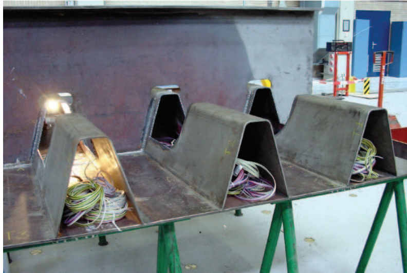
Abbildung 6.4: Herstellung der Zugänglichkeit innerhalb der Hohlrippen [1]
