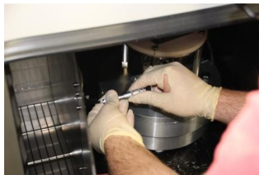
Abbildung 5-36: Mess- und Steuerkabel anschließen
