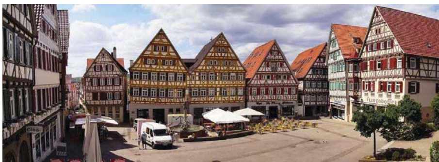
Bild 2.3: Mehrgeschossige Fachwerkbauten in Herrenberg, Deutschland (erbaut 1635) 9
