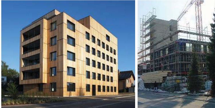
Bild 2.16: Wohnbau- und Gewerbebau Steinhausen 45
