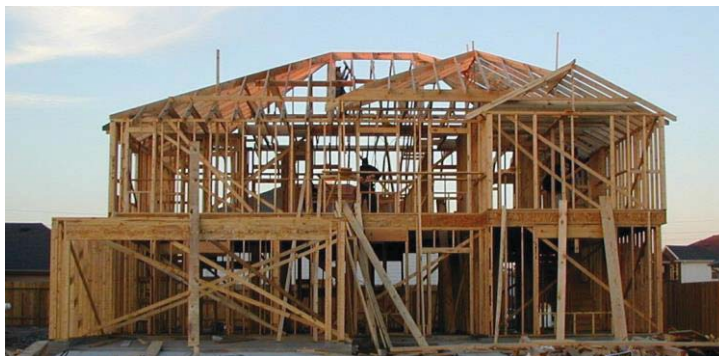
Bild 2.6: „Platform Framing“ in Nordamerika 19
