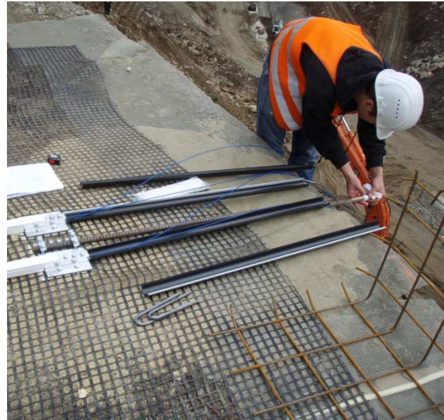
Abbildung 122: links: Anbringen des Schutzes für die Glasfaser im vorderen Bereich der Bewehrte-Erde; rechts: Montage des Prismas für die geodätische Überwachung
