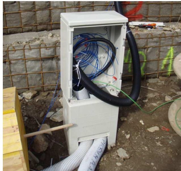
Abbildung 123: links: Anbringen Blick auf die Wandfläche; rechts: Kabelkasten zur Sammlung aller Leitungen eines Querschnitts
