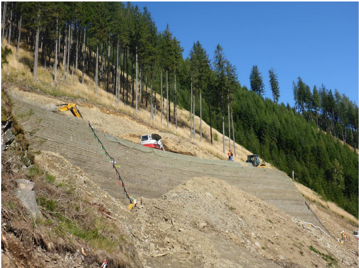
Abbildung 121: Blick auf die Bewehrte Erde Konstruktion mit den Messquerschnitten
