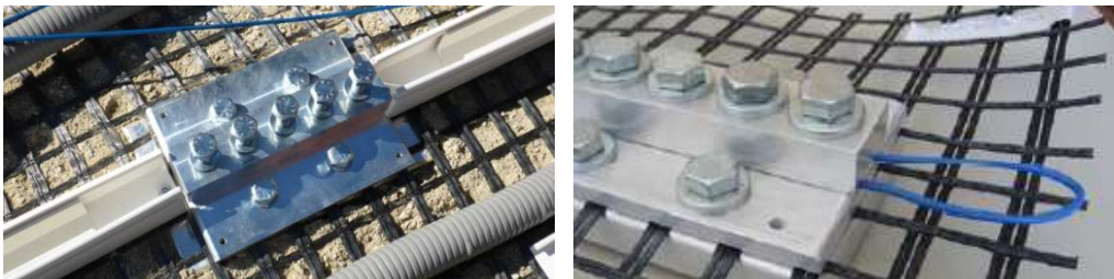
Abbildung 22: links: Auslegen des Sensorkabels; rechts: Befestigung des Geogitters an der letzten Ankerplatte
