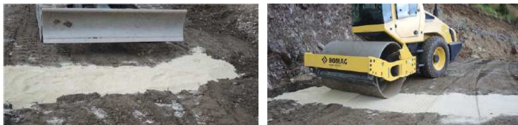
Abbildung 20: links: Verfüllen der Sensorkünette; rechts: Verdichtung des kiesigen Sands
