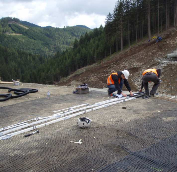
Abbildung 122: links: Anbringen des Schutzes für die Glasfaser im vorderen Bereich der Bewehrte-Erde; rechts: Montage des Prismas für die geodätische Überwachung
