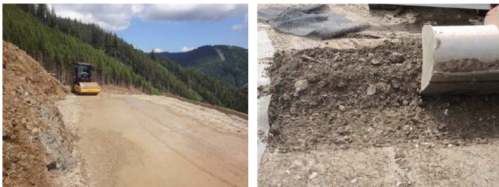
Abbildung 19: Herstellung des Planums der Messebene
