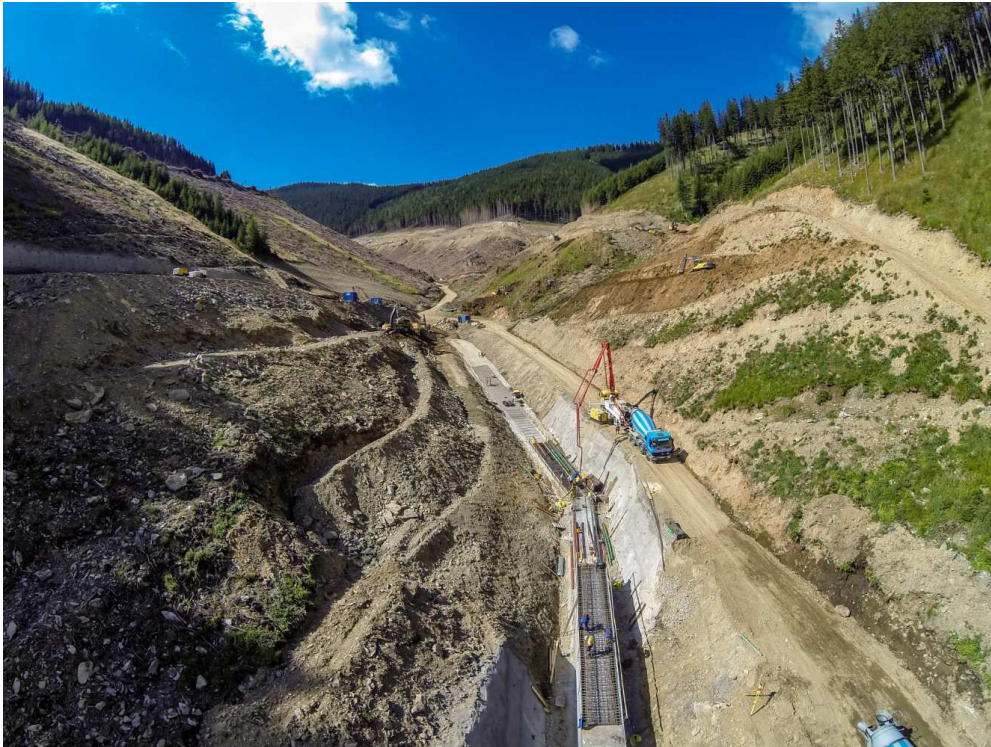
Abbildung 5: Blick in den Longsgraben (Stand: 1. August 2013) (Quelle: ÖBB / Franz Zwickl)
