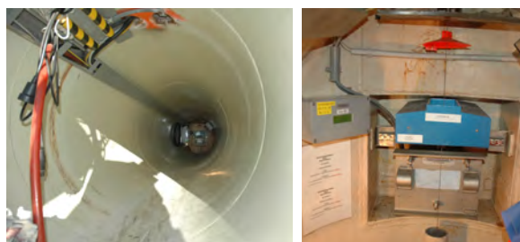
Abb. 3.6: Zugangsrohr und Ableseeinrichtung auf VE 661
