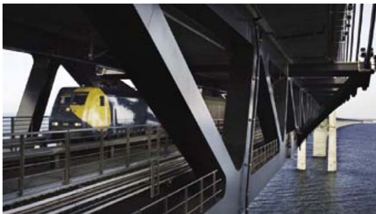
Bild 1-1: Verbundbrücke mit Fachwerkträger als Hauptträger [ 22 ] [Foto: Miklos Szabo]
