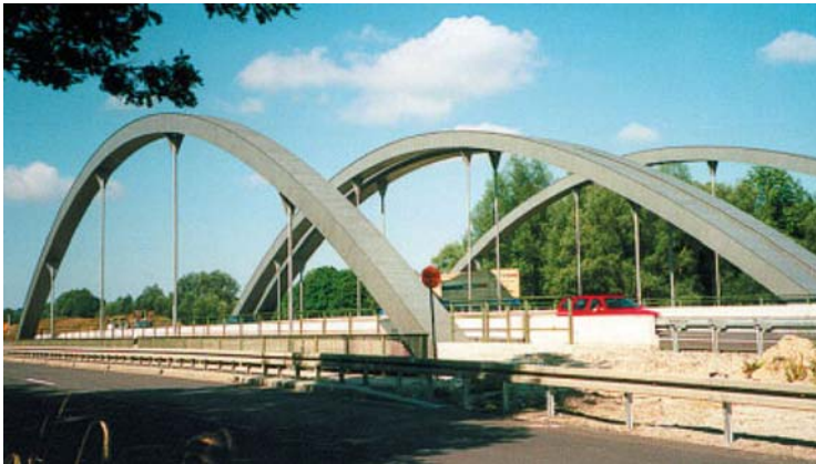
Bild 1-2: Stabbogenbrücke über die Amper [ 8 ]
