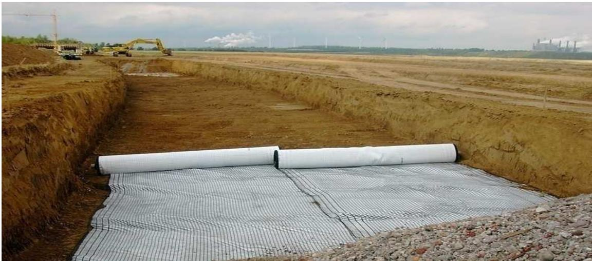
Abbildung 2.12: Geogitter mit Vliesstoffkomponente bei feinkörnigem, wenig tragfähigem Untergrund(69)
