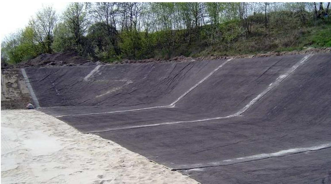
Abbildung 2.16: Einsatz von geosynthetischen Tondichtungsbahnen (72)
