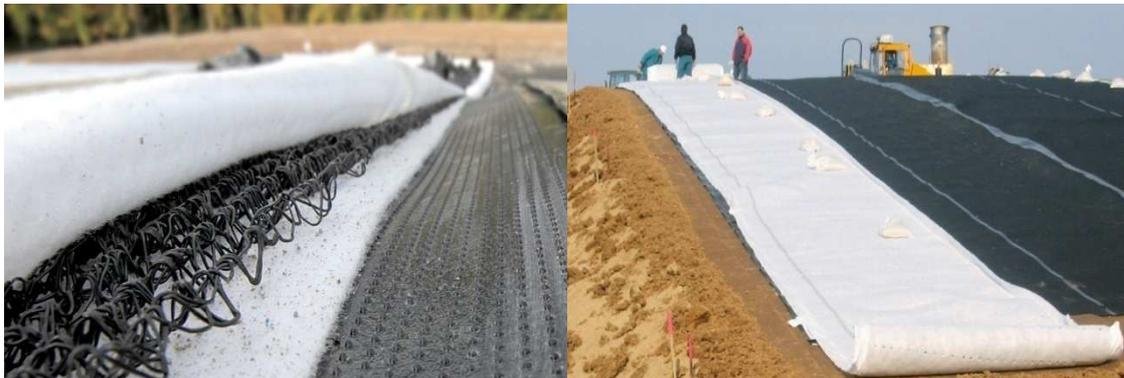
Abbildung 2.18: Verlegung einer Kunststoffdichtungsbahn mit darüber liegender Dränmatte zur Entwässerung (71)
