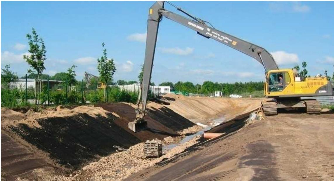
Abbildung 2.17: Einbau einer Erosionsschutzmatte (71)
