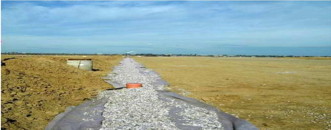
**Abbildung 2.13: Geovliesstoff bei Entwässerungsgraben (70)**
