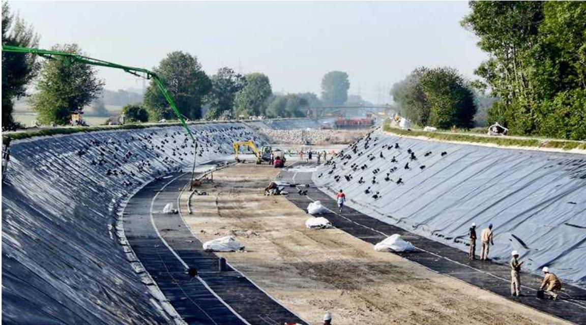
Abbildung 2.15: Einbau von Kunststoffdichtungsbahnen (71)
