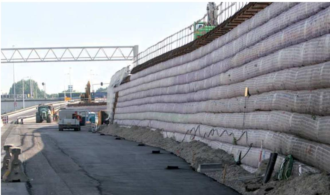
**Abbildung 2.14: Stützwand mit geokunststoffbewehrter Erde (71)**
