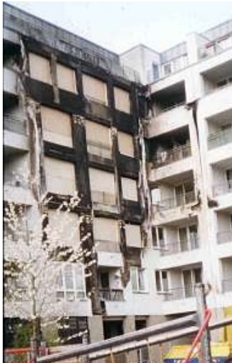
Abb. 2–4: Brandfall Berlin (Deutschland) 2005 – Fassadenschädigung [31]
