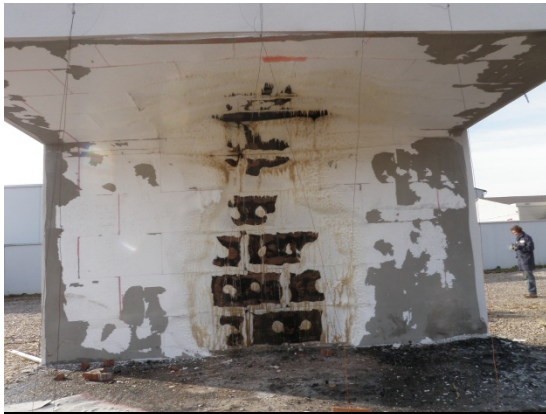
Abb. 6-4: Schädigung der Fassadenkonstruktion hinter der Putzoberfläche
