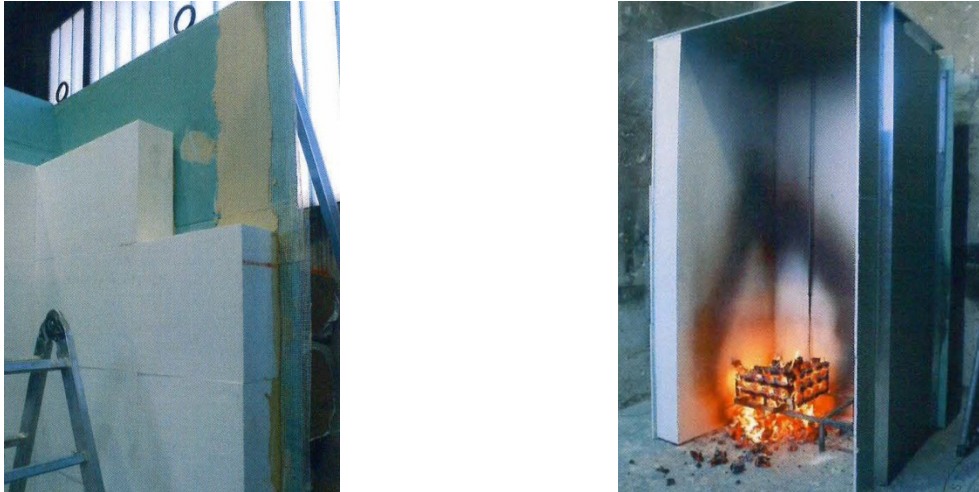
Abb. 4–29: Brandprüfung Loggia-Nische 1 – Fassadenschädigung [84]
