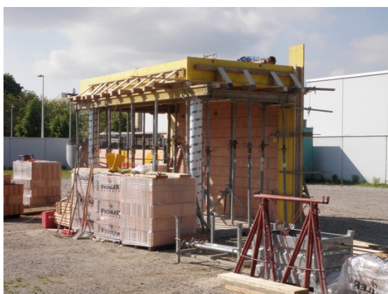
Abb. 3-1: Herstellung des Rohbaus des Prüfaufbaus
