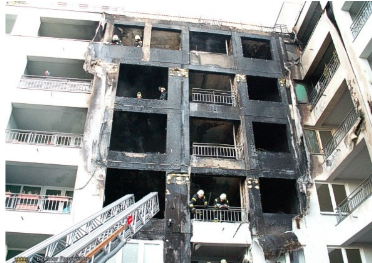
Abb. 2–4: Brandfall Berlin (Deutschland) 2005 – Fassadenschädigung [31]
