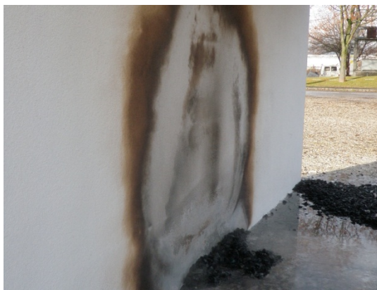
Abb. 6-3: Schädigung der Fassadenkonstruktion an der Putzoberfläche
