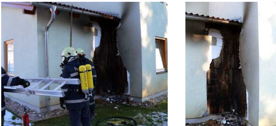
Abb. 2–5: Brandfall Voralpe (Österreich) 2005 [33]
