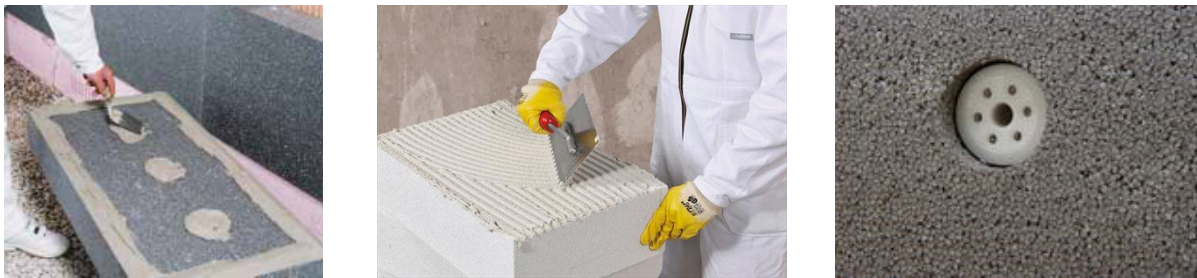
Abb. 1–4: Verarbeitung von Dämmstoffen aus Polystyrol-Hartschaum [2][6][7]
