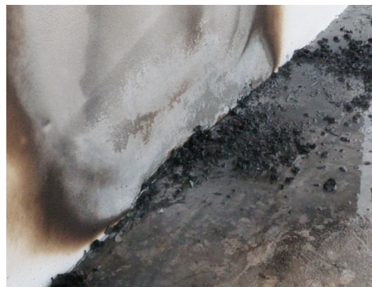
Abb. 6-3: Schädigung der Fassadenkonstruktion an der Putzoberfläche
