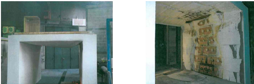
Abb. 4-11: Brandprüfung einer Durchfahrt 2 – Fassadenschädigung [76]
