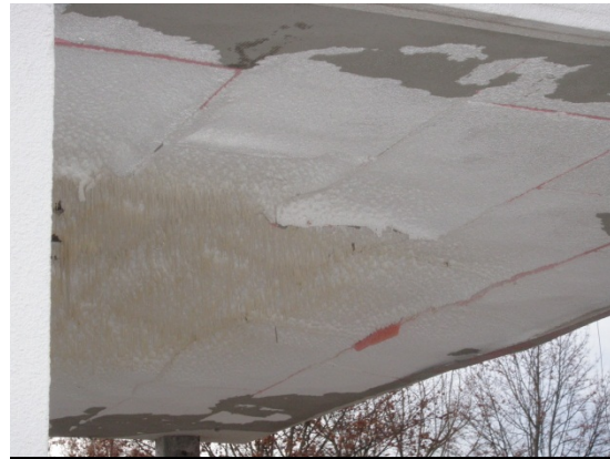
Abb. 6-4: Schädigung der Fassadenkonstruktion hinter der Putzoberfläche
