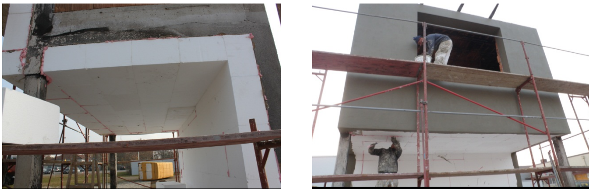
Abb. 3-2: Herstellung Fassadendämmung, Putzauftrag
